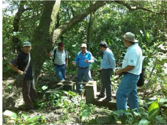
Lámina 7.3. Estructura de concreto para retorno del agua
