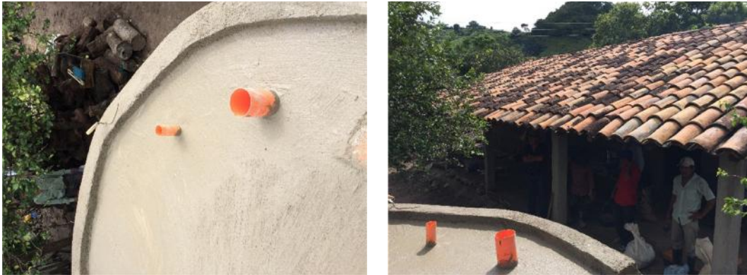
Instalación del Sistema de captación de agua de lluvia (SCALL)
