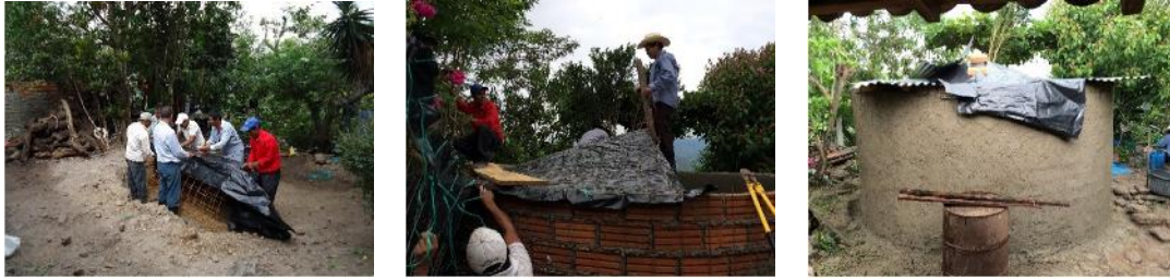
Acabados e instalación de la bóveda.
