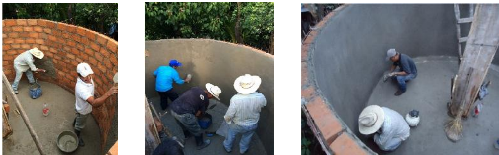
Instalación del muro capuchino con acabados
