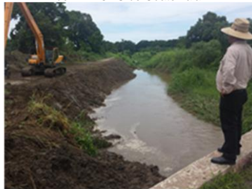
Ilustración 4. Mantenimiento de un dren secundario con excavadora brazo largo
