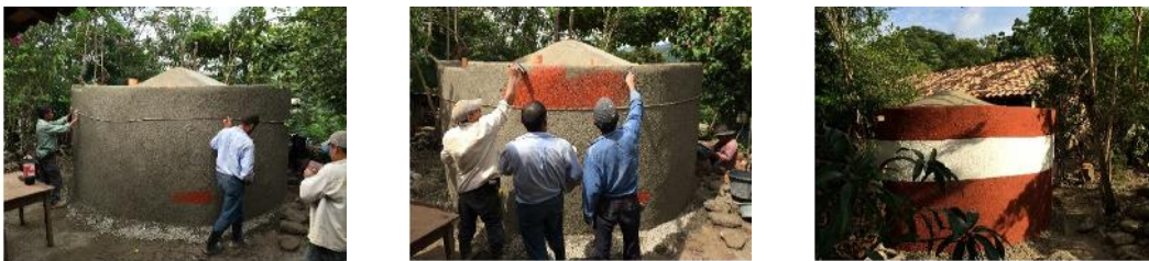
Acabados y pintura de la cisterna.
