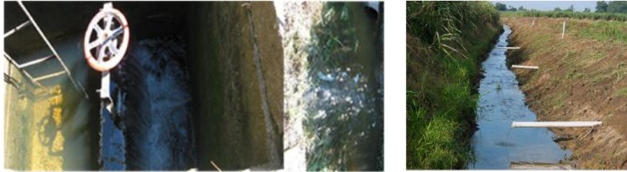
Ilustración 7. Drenaje subterráneo parcelario controlado
