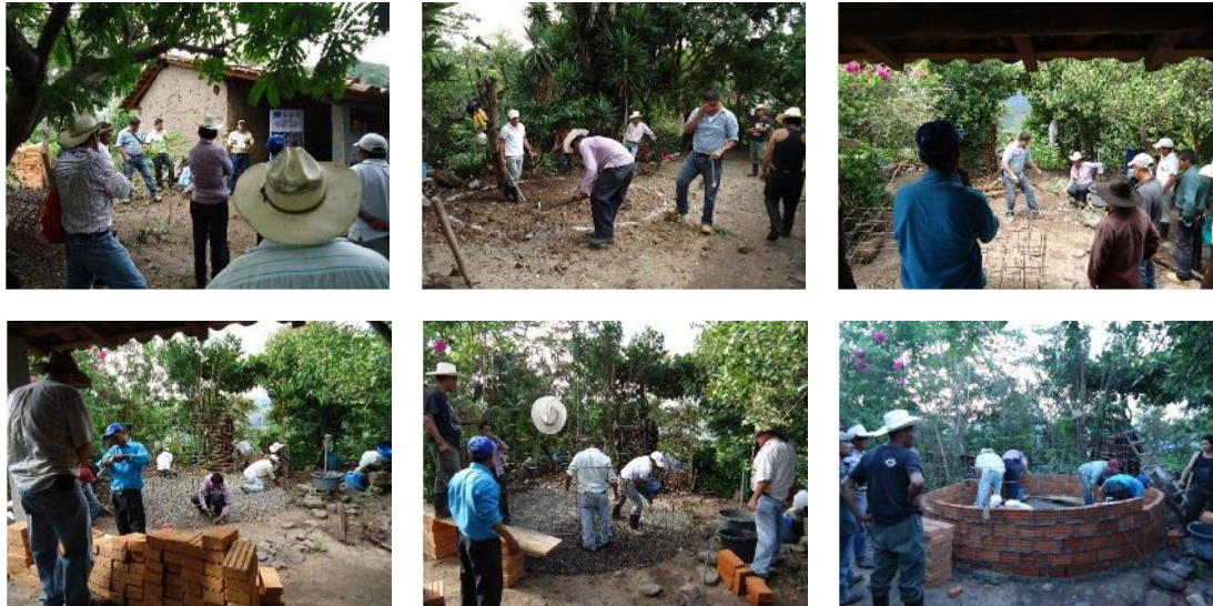
Localización del sitio, chaponeo, trazo, nivelación y compactación del terreno, armado y colocación de la malla, colado de la losa de fondo. Instalación del muro capuchino.
