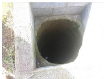
Ilustración 2. Noria, de 20 m de profundidad
