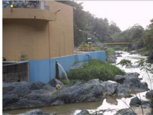
Fotografía 4. Recorrido por central hidroeléctrica.
