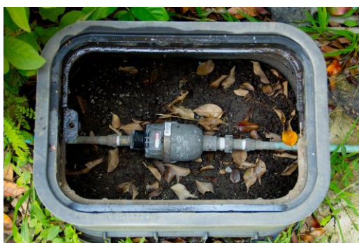
Medidor volumétrico que contabiliza el agua de las valvulas de riego
