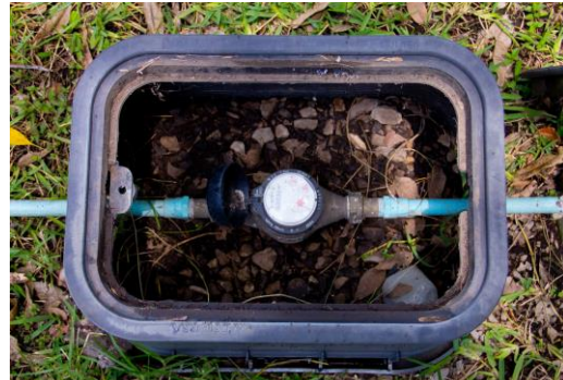
Medidor volumétrico que contabiliza el agua de las valvulas de riego
