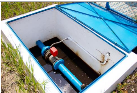
Medidor electromagnético instalado en el pozo.
