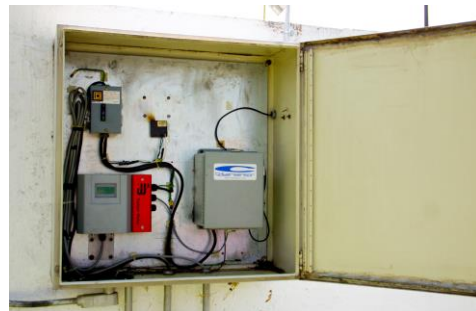
Medidor electromagnético instalado en el pozo.
