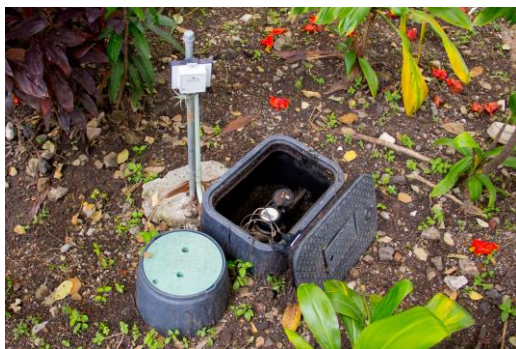
Medidor volumétrico que contabiliza el agua de cada edificio
