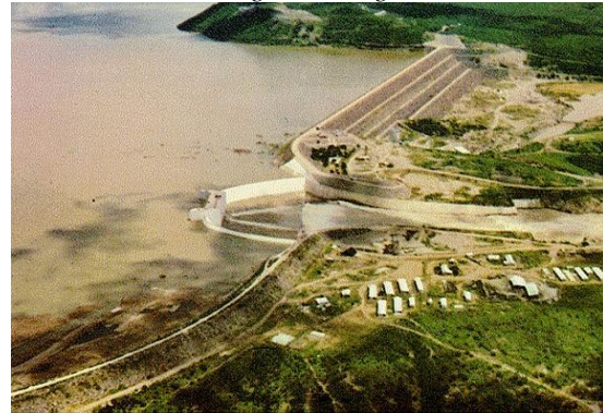
Presa Miguel Hidalgo, Sin.
