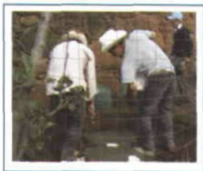
Figura 13. Se hace el colado del piso.
