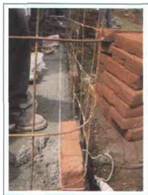
Figuras 47 a y b. Colocación de las guías para hacer el muro.
