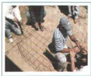
Figura 31. Se forma el contorno semicircular.
