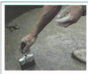
Figura 26. Se repella con acabado fino por dentro para evitar filtraciones.
