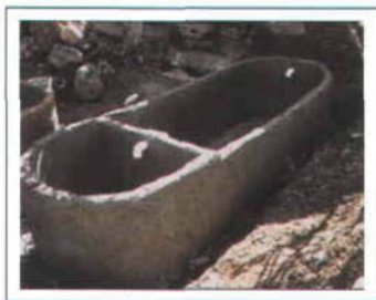
Figura 49. Conexión a la salida del filtro de materiales graduados.
