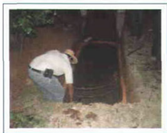
Figura 44. Colado del piso del humedal.
