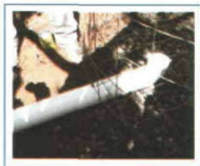
Figura 11. Se coloca el tubo para el sanitario.
