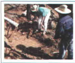
Figura 32. Se coloca el armado en el terreno nivelado.
