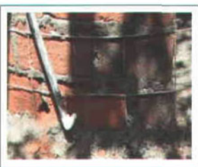
Figura 27. Se Coloca la manguera para el agua del WC.
