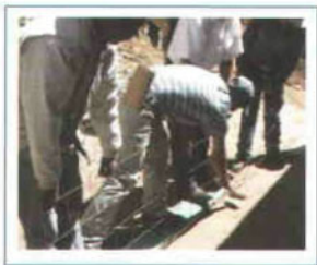
Figura 30. Se marca el doblez con marro.
