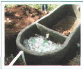
Figura 50. Colocación del PET.
