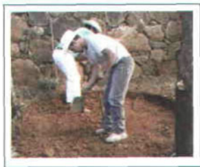
Figura 4. Nivelación del terreno
