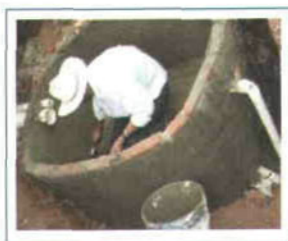
Figura 37. Repellado interior y exterior.
