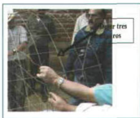
Figura 8. Se corta y se dobla para colocarlo en el cilindro
