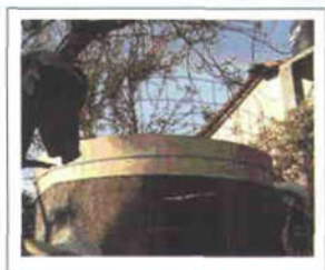
Figura 22. Se coloca un anillo de triplay para el colado.
