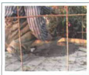
Figura 23. Se hace el colado de 5 cm.
