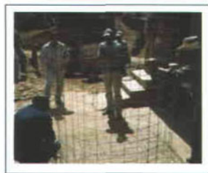
Figura 7. Se invierte el anillo para cortar la malla del piso del tinaco
