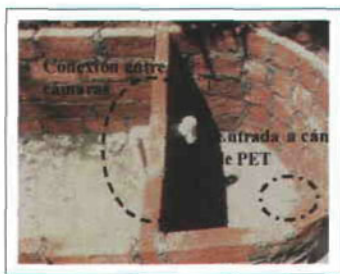
Figura 48. Conexiones entre cámaras.
