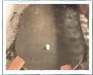
Figura 39. Se coloca el tubo para la salida del gas.
