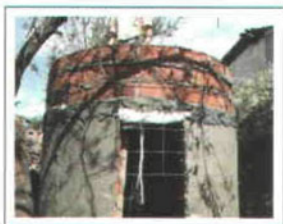
Figura 24. Se coloca el muro capuchino del tinaco.
