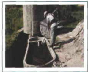
Figura 41. Se coloca el tubo en el tanque séptico
