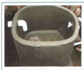
Figura 35. Conexiones en el tanque séptico.
