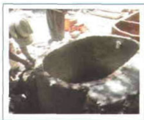
Figura 15. Se hace la mampostería a los lados del tanque séptico.
