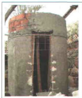
Figura 25. Se repella rústico por fuera.
