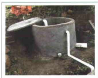
Figura 57. Conexiones entre cámaras.
