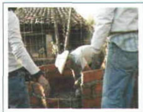
Figura 17. Se coloca el muro capuchino.
