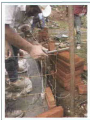
Figuras 47 a y b. Colocación de las guías para hacer el muro.
