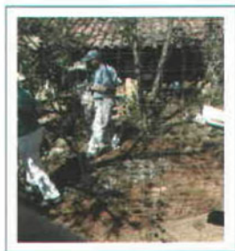
Figura 9. Colocación del anillo en la superficie preparada para el baño
