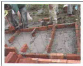
Figura 14.- Instalación de las cámaras 1, 2 y 3.
