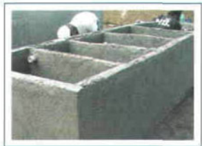
Figura 17.- Repellado interior y exterior
