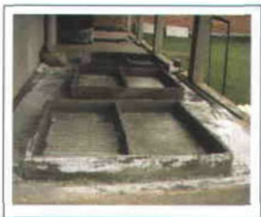
Figura 34. Se deja fraguar y se desmolda.
