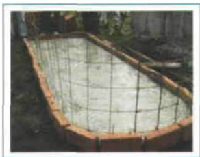
Figura 12. Colado de piso del biofiltro.
