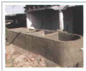
Figura 20. Colocación de las conexiones entre las cámaras con 2cm de desnivel.
