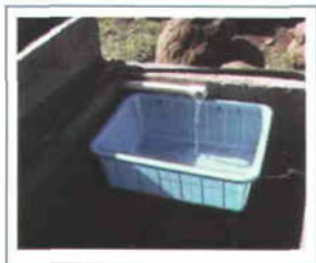
Figura 47. Colocación de la canastilla.
