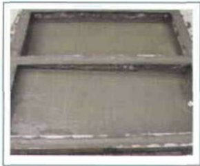
Figura 32. Desagüe del lavadero.
