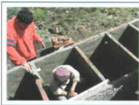
Figura 17.- Repellado interior y exterior
