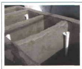
Figura 20. Colocación de las conexiones entre las cámaras con 2cm de desnivel.
