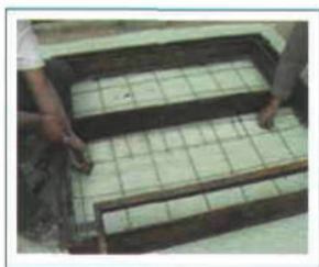
Figura 25. Instalación de refuerzo en forma de L.
