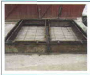
Figura 27. Se amarran los moldes a la base.
