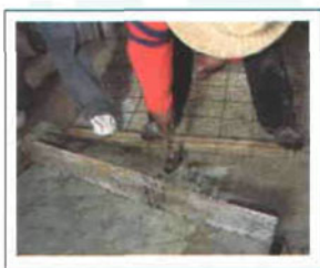
Figura 24. Se marca y dobla la malla.
