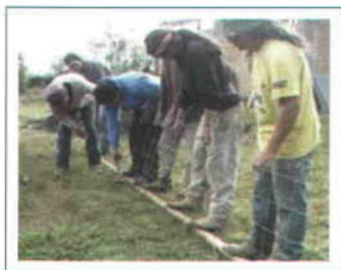
Figura 7. Doblado de la malla.
