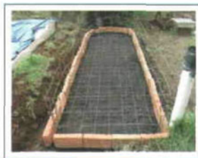
Figura 11. Armado de acero completo.
