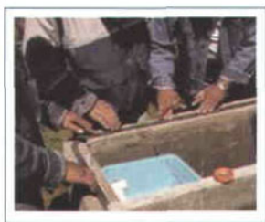
Figura 50. Se pega la junta.
