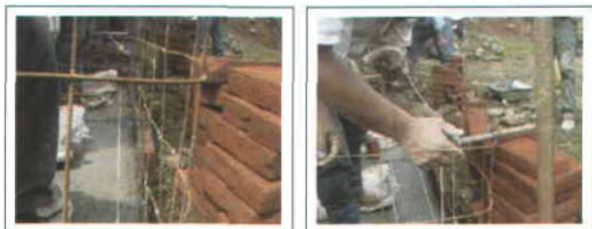
Figura 13. Colocación de las guías para hacer el muro.
