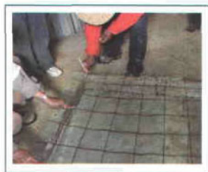
Figura 24. Se marca y dobla la malla.
