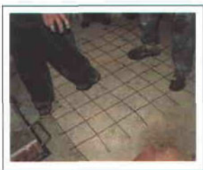
Figura 23. Se corta y aplana la malla.
