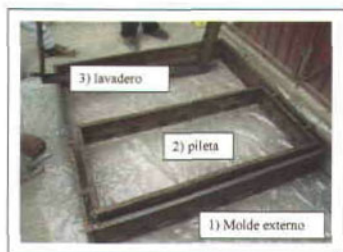
Figura 21. Piezas del molde del lavadero.
