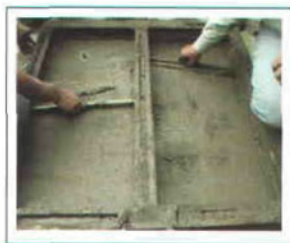
Figura 29. Nivelación de las cámaras.
