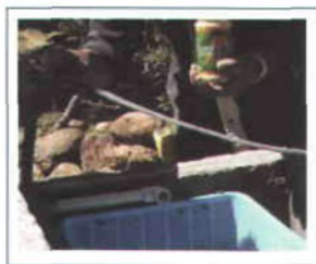
Figura 49. Se aplica el pegamento.
