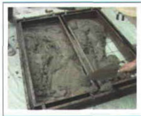
Figura 28. Rellenar los moldes con mezcla.
