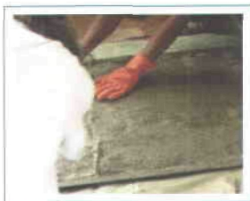
Figura 9. Se coloca el costal de arpilla.
