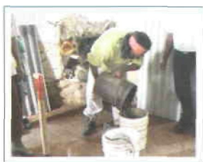
Figura 6. Se mezclan pasándolos de un bote a otro.
