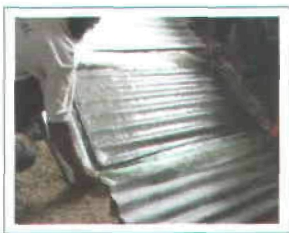
Figura 13. Se coloca sobre la lámina acanalada.
