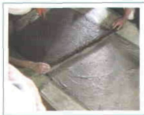
Figura 11. Se nivela con la regleta.
