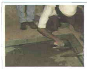
Figura 8. Se forma la primera capa con la mezcla.
