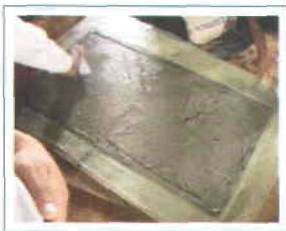
Figura 10. Se agrega la segunda capa de mezcla.
