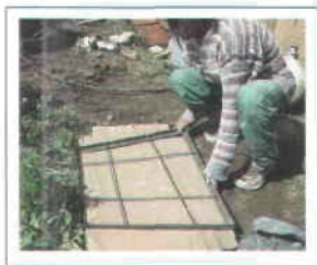
Figura 45. Se realiza el colado de la tapa del registro.
