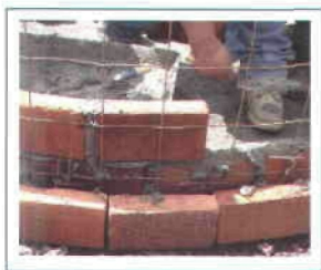
Figuras 23 y 24. Se coloca el muro tipo capuchino.
