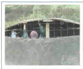
Figuras 33 y 34. Al final se coloca el gajo que tiene la abertura para el registro de la cisterna.
