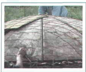
Figuras 37 y 38. Se amarra la malla y se coloca un cuadro adicional de malla para amarrar con las orillas.
