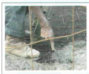
Figuras 17 y 18. Se agrega la mezcla en capa de 10 cm de espesor levantando la malla para que penetre la mezcla.
