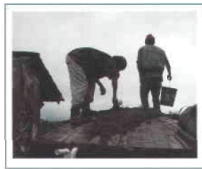
Figuras 41 y 42. Se vierte la mezcla para colar la bóveda.
