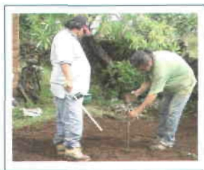
Figura 2. Se fija el radio de la cisterna.
