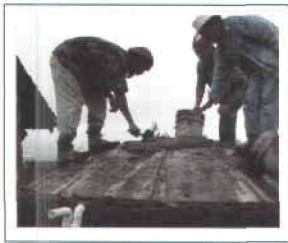
Figuras 41 y 42. Se vierte la mezcla para colar la bóveda.
