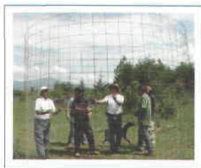
Figuras 9 y 10. Se forma el anillo con 9.5 m de malla y se amarra con alambre recocido.
