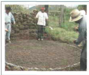
Figuras 11 y 12. Se coloca el anillo sobre la malla de fondo y se verifica el diámetro.
