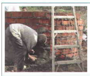
Figuras 23 y 24. Se coloca el muro tipo capuchino.
