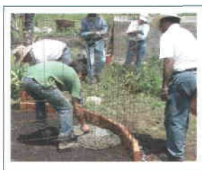
Figuras 15 y 16. Se hace la abertura para la escalera y se coloca tabique alrededor.
