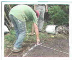
Figura 3. Se marca el círculo de la cisterna con cal.
