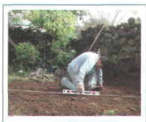
Figura 4. Se nivela el suelo.
