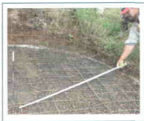
Figuras 11 y 12. Se coloca el anillo sobre la malla de fondo y se verifica el diámetro.
