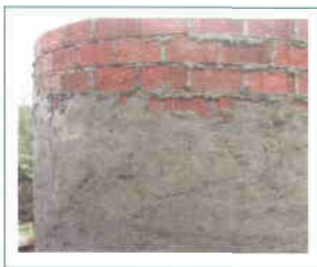
Figuras 25 y 26. Se hace el repellado exterior de 1.5 cm de espesor y se aplanar con llana de madera.
