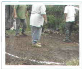
Figura 7 y 8. Se coloca la malla de fondo de 3.16 x 3.16 m.
