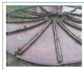
Figura 29. Cimbra prefabricada.
