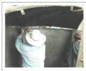
Figuras 31 y 32. Se colocan de dos en dos, al centro se apuntala con un polín de madera.
