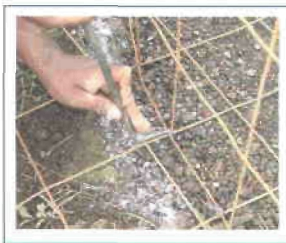
Figuras 13 y 14. Se amarra el anillo a la malla de fondo y se cortan los sobrantes.
