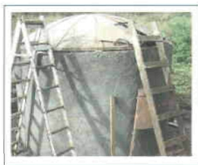
Figuras 33 y 34. Al final se coloca el gajo que tiene la abertura para el registro de la cisterna.
