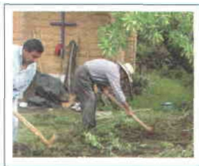
Figura 1. Limpieza del terreno.
