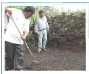
Figura 6. Se agrega grava para que el concreto penetre la malla.
