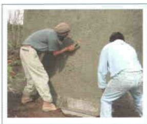
Figuras 25 y 26. Se hace el repellado exterior de 1.5 cm de espesor y se aplanar con llana de madera.
