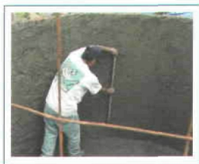
Figuras 27 y 28. Repellado interior.
