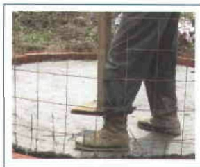
Figuras 21 y 22. Se compacta la mezcla y se agrega mezcla para pulir el fondo.
