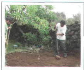
Figura 5. Se compacta con un pizón.
