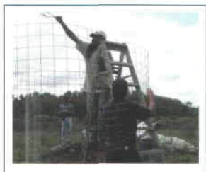
Figuras 15 y 16. Se hace la abertura para la escalera y se coloca tabique alrededor.
