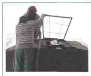
Figuras 35 y 36. Se rellenan de papel mojado las orillas para sellarlas y se corta la malla para doblarla.
