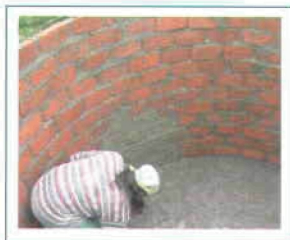
Figuras 27 y 28. Repellado interior.
