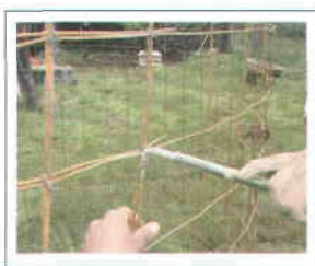
Figuras 9 y 10. Se forma el anillo con 9.5 m de malla y se amarra con alambre recocido.
