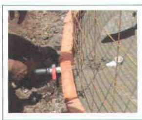
Figura 20. Colocación de la tubería para la toma de agua
