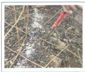
Figuras 13 y 14. Se amarra el anillo a la malla de fondo y se cortan los sobrantes.
