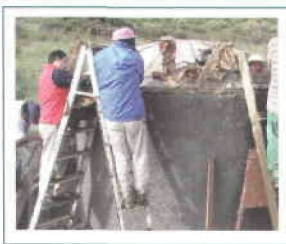
Figuras 35 y 36. Se rellenan de papel mojado las orillas para sellarlas y se corta la malla para doblarla.
