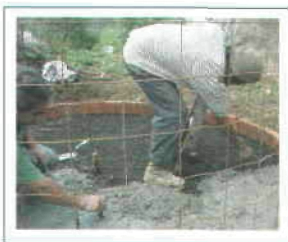
Figuras 17 y 18. Se agrega la mezcla en capa de 10 cm de espesor levantando la malla para que penetre la mezcla.
