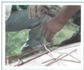
Figuras 37 y 38. Se amarra la malla y se coloca un cuadro adicional de malla para amarrar con las orillas.
