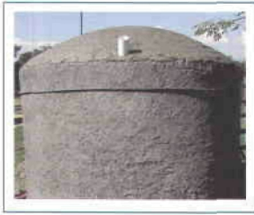
Figura 39. Tubo de 4" para la captación.
