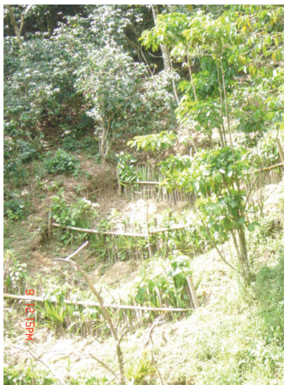
Figura 10. Rehabilitación de derrumbes a base de presas filtrantes vegetativas en el ejido Mexiquito, cuenca del río Huehuetán, Chiapas.
