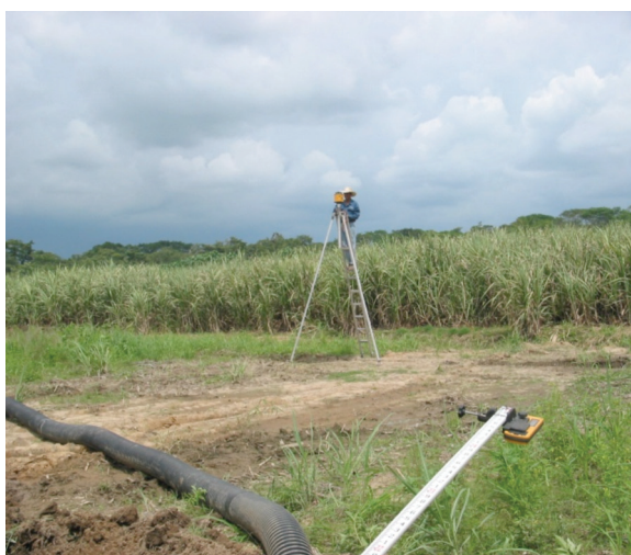
Figura 24. Instalación del emisor de rayo láser.
