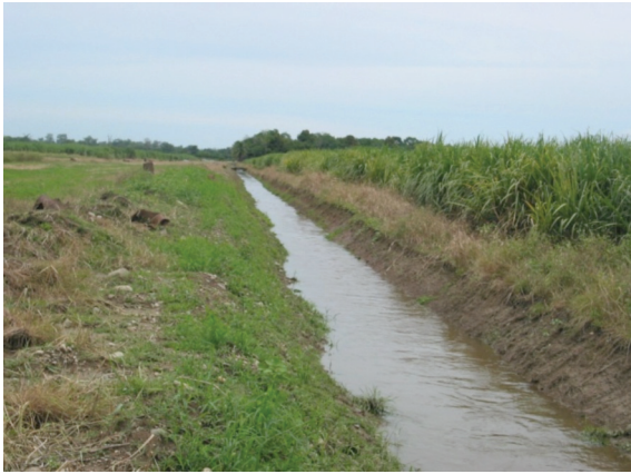
Figura 7. Conservación normal del dren principal.
