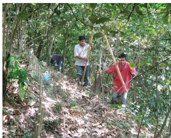
Figura 6. Uso de nivel tipo A en el trazo de curvas a nivel para el establecimiento de terrazas de muro vivo.
