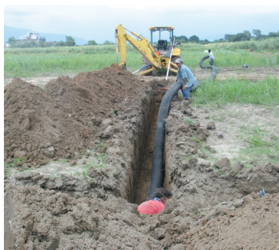
Figura 25. Instalación de colectores.
