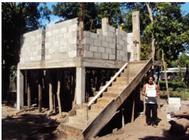
Ilustración 3. Proceso de construcción del palafito en Tabasco (Sedesol, 2010).
