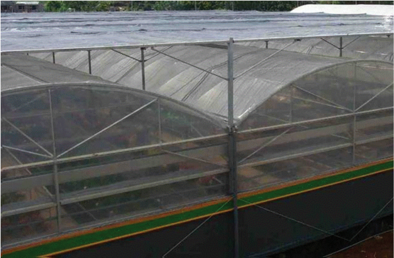
Invernadero con malla sombra para contrarrestar alta insolación.
