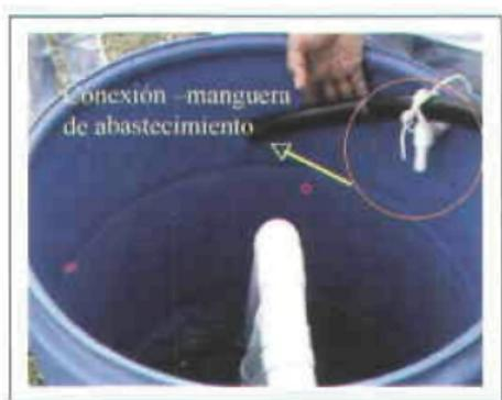
Figura 6. Conexión de la manguera de abastecimiento
