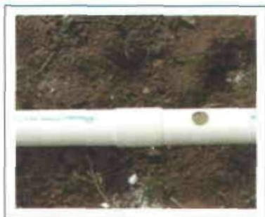
Figura 16. Colocación de los anillos.
