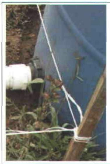
Figura 10. Conector a tuerca unión.
