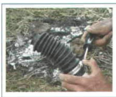
Figura 8. Instalación del cople plegable.
