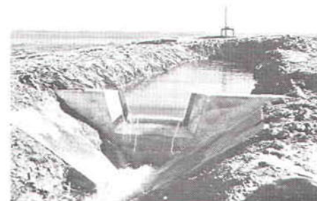
Figura 18. Vista general de la configuración de una estación de aforo en un canal.
