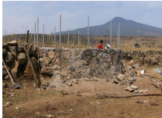
Ilustración 47. Protección del manantial (San Andrés Tzironvaro)
