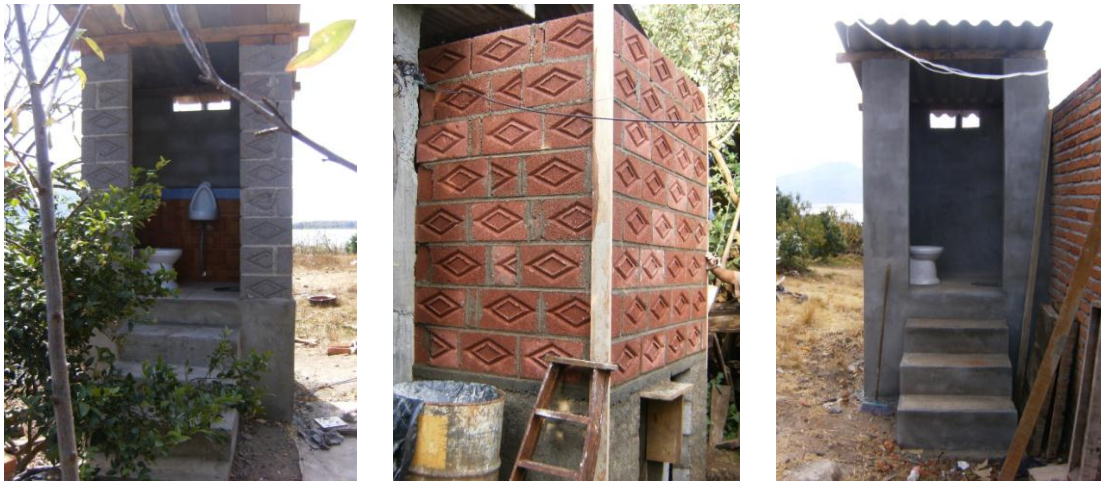
Ilustración 51. Implementación de servicios sanitarios (baños ecológicos secos) en San Jerónimo Purenchécuaro
