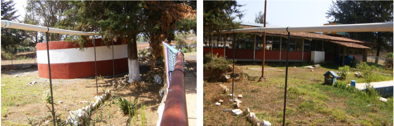
Ilustración 35. Captación, conducción y almacenamiento de agua de lluvia (jardín de niños Silvestre Revueltas)
