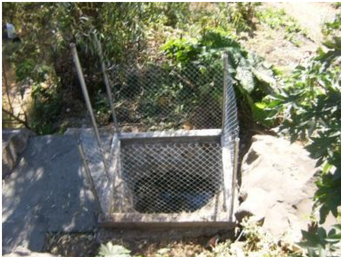
Ilustración 44. Protección del manantial El Patito (San Jerónimo Purenchecuario)
