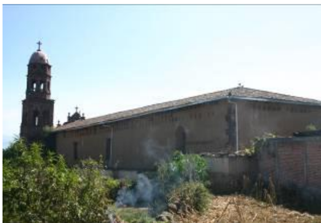
Ilustración 27. Techo de la iglesia con canaletas para captar agua de lluvia
