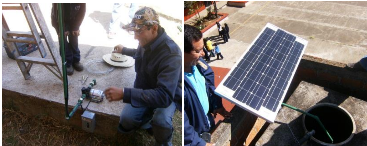
Ilustración 63. Bombeo fotovoltaico en la escuela primaria Miguel Hidalgo (San Andrés Tzironbaro)
