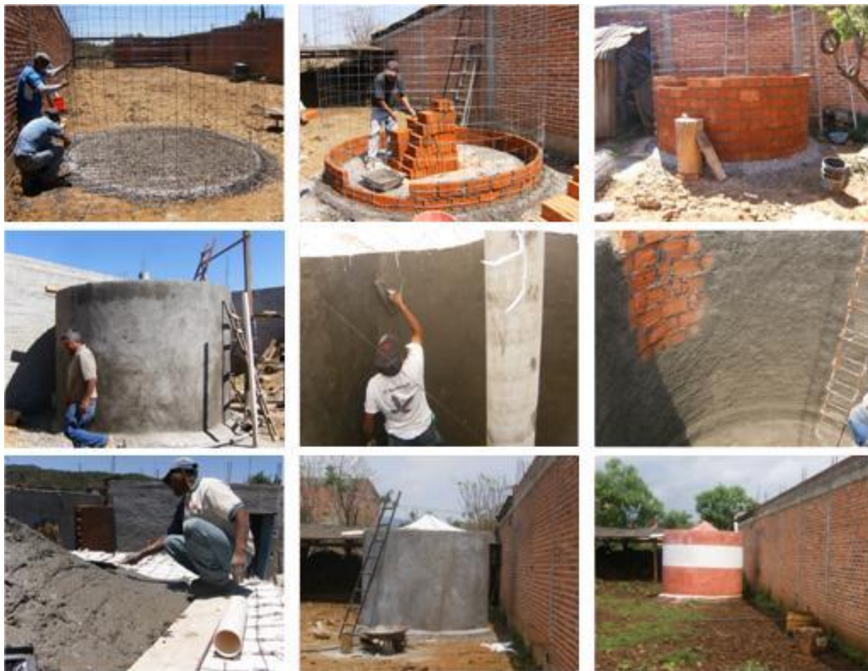
Ilustración 32. Implementación de cisternas tipo vivienda en las comunidades
