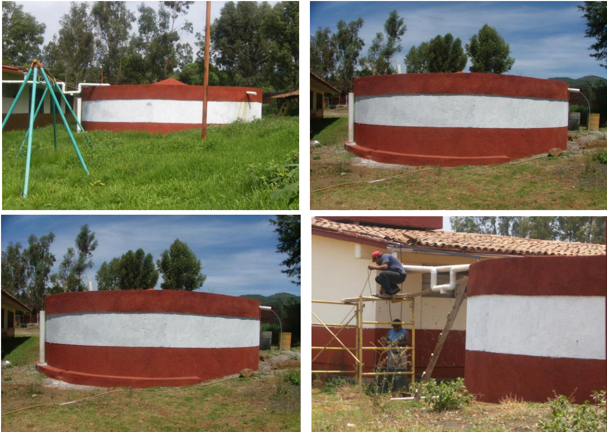
Ilustración 33. Captación, conducción y almacenamiento de agua de lluvia en la escuela primaria Cuauhtemoc.
