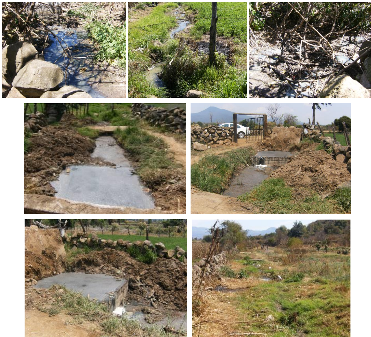
Ilustración 60. Limpieza del tanque sedimentador y tramo de descarga - San Andrés Tzironदारo
