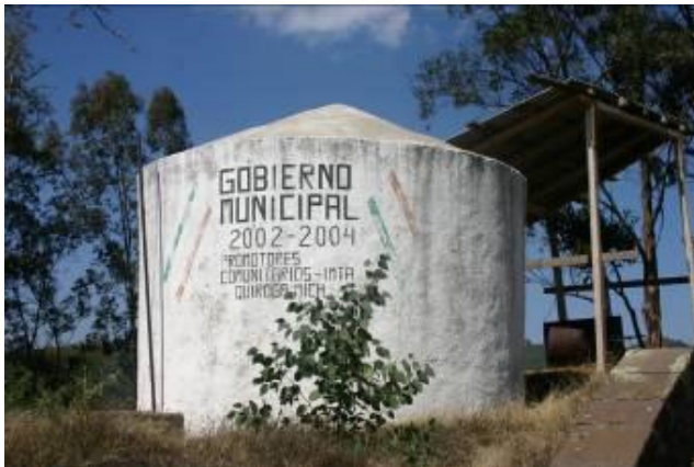
Ilustración 23. Cisterna de ferrocemento y tinaco de 5,000 – El Sandio
