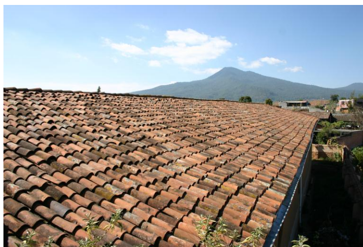
Ilustración 29. Techo de la iglesia de San Andrés Tzirondaro.
