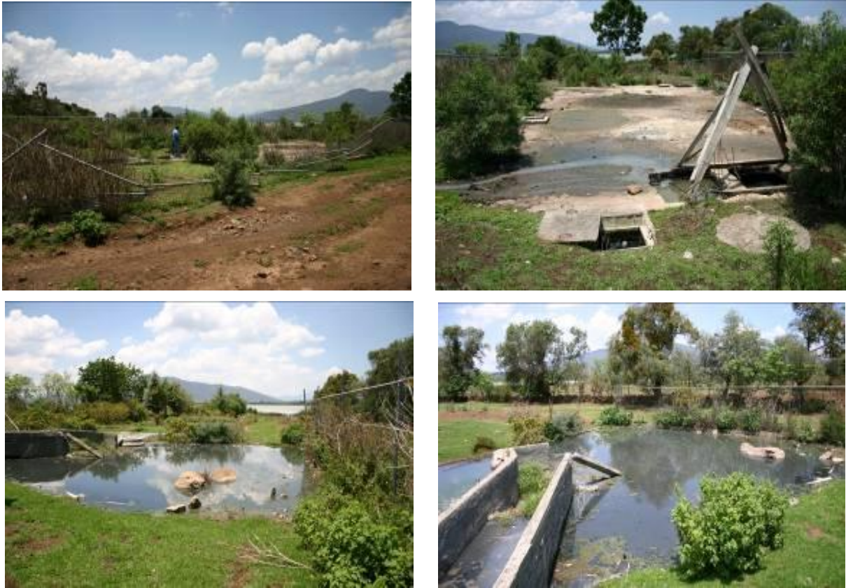
Ilustración 53. Descarga 1 antes del humedal artificial (comunidad de San Jerónimo Purenchécuaro)
