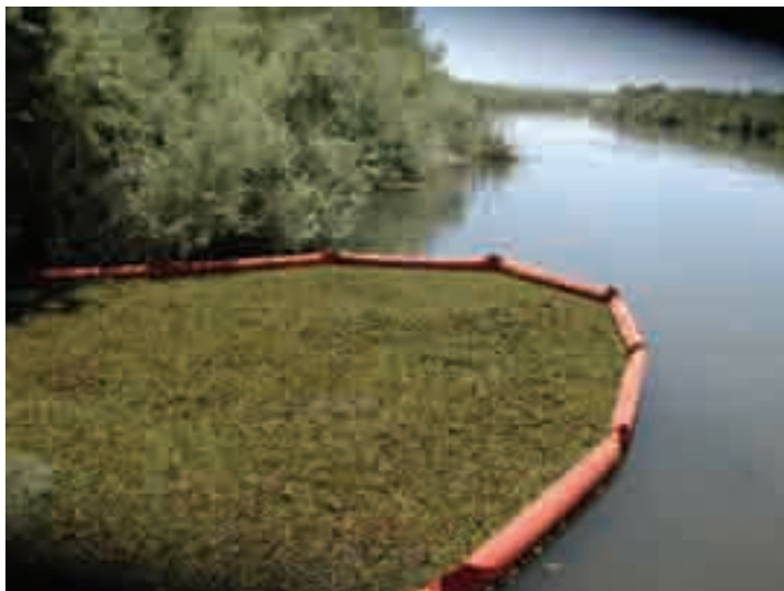
Figura 8. Barrera flotante para el control de Salvinia molesta en canales de riego.
