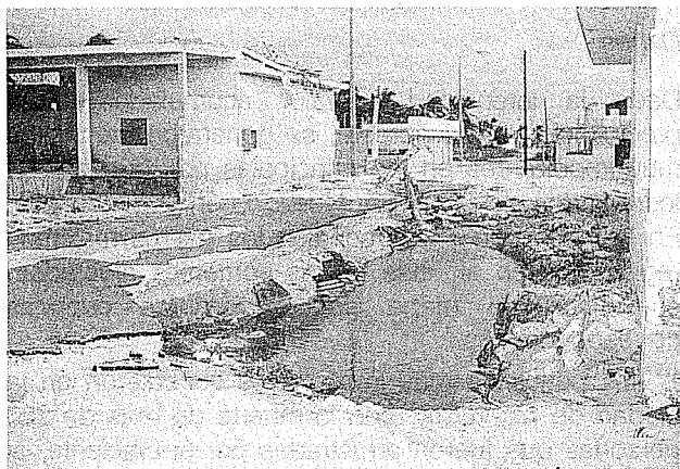
38. Erosión en calles de la costa norte de la península de Yucatán
