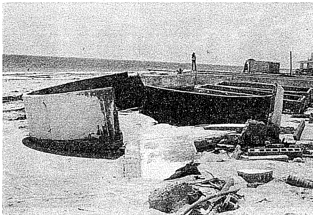
36. Falla de tanques de piscicultura en Puerto Morelos
