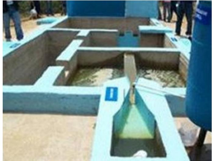
Figura 6. Se observan aquí el canal Parshall, la dosificación de sulfato de aluminio y los filtros.
