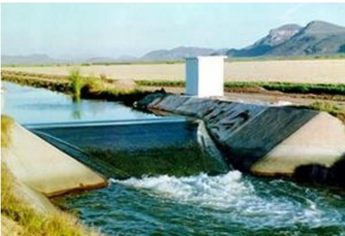
Figura 2. Estructura aforadora para medición de gastos en la red de distribución del agua para riego.
