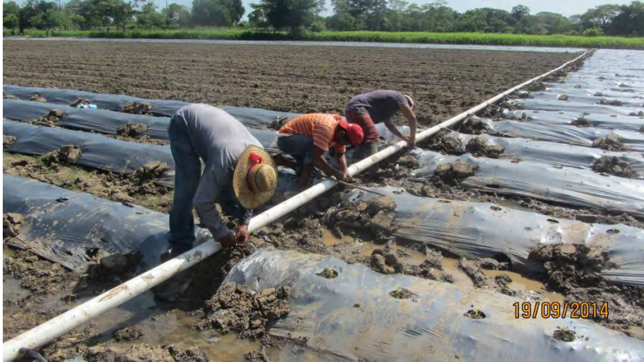
Figura 9.7 Instalación de sistema de riego por goteo con cintas y cubierta plástica.
