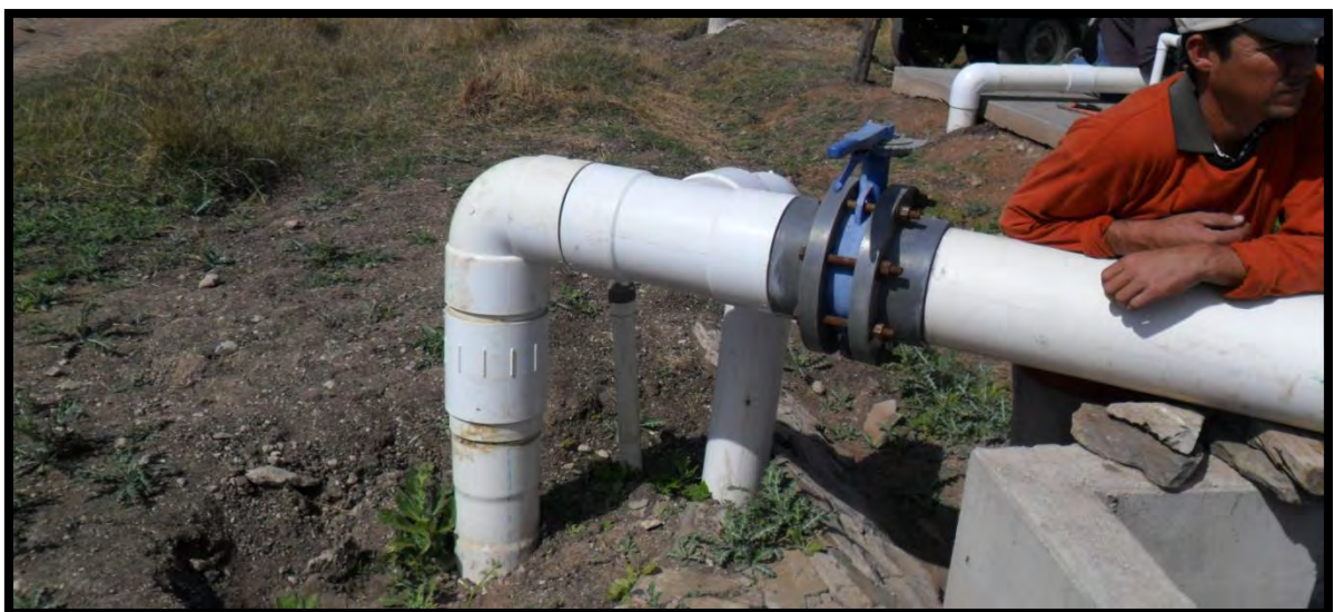
Figura 84. Tubería de conducción
