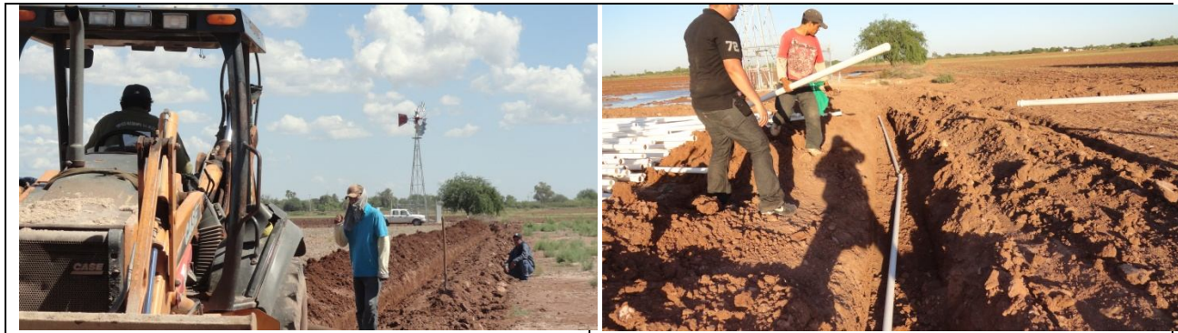
Ilustración 15. Instalación de la tubería de descarga, en octubre
