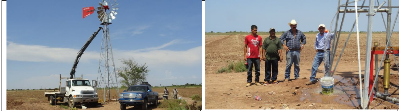
Ilustración 14. Colocación del molino de viento y prueba de extracción de agua, en julio
