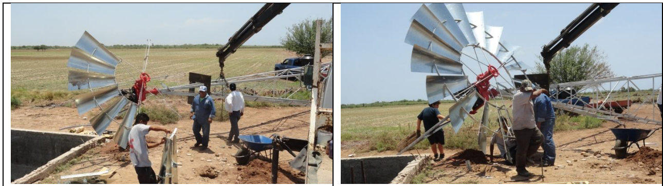
Ilustración 13. Armazón del molino de viento a un lado del cárcamo de bombeo, en julio
