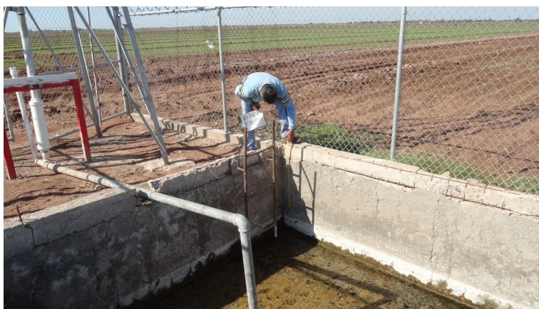
Ilustración 75. Medición de la profundidad del nivel freático en el cárcamo de bombeo, el 10 de diciembre
