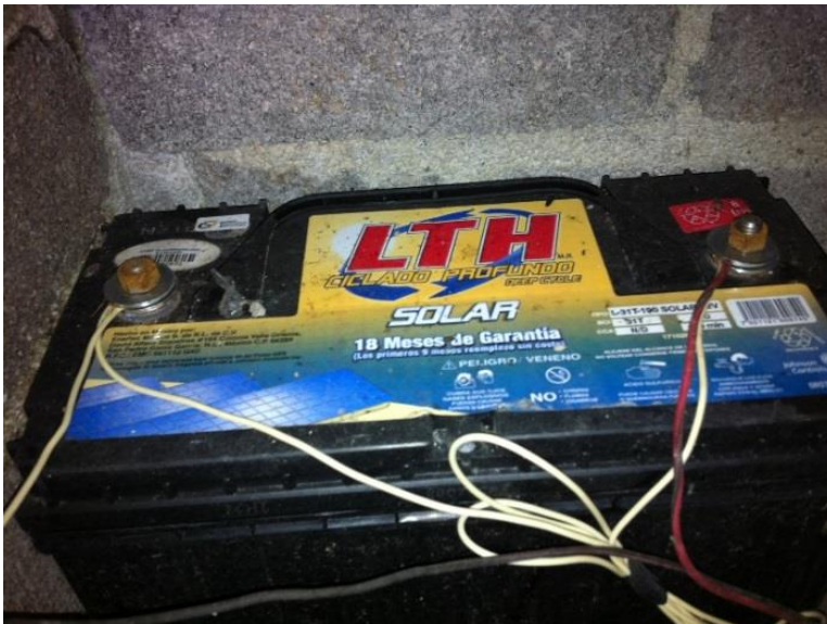
Ilustración I.70. Cambio de rondanas oxidadas en la batería de la microcuenca Ichupio.
