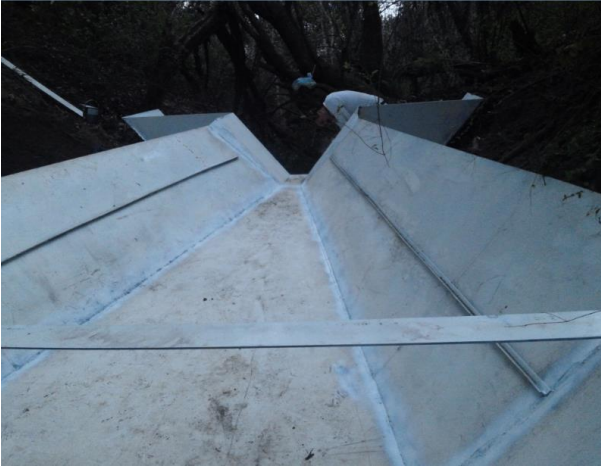
Aforador de garganta larga
