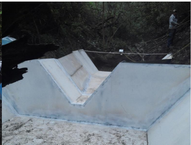
Aguas arriba instalado
