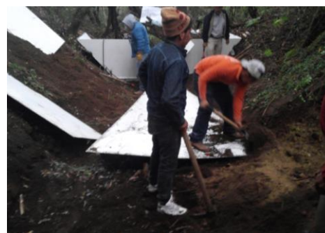
Ilustración I.52 Proceso de ensamblado y soldado del aforador de garganta larga en el sitio seleccionado.
