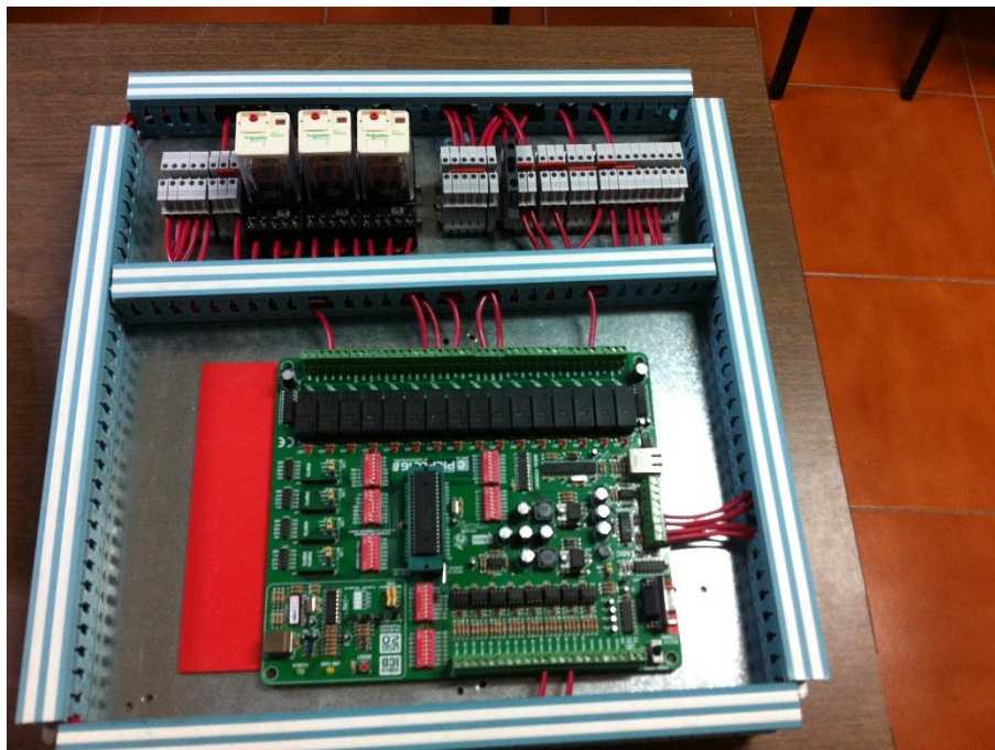
Ilustración II.11. Ensamblaje de 8 paneles para mayor potencia
