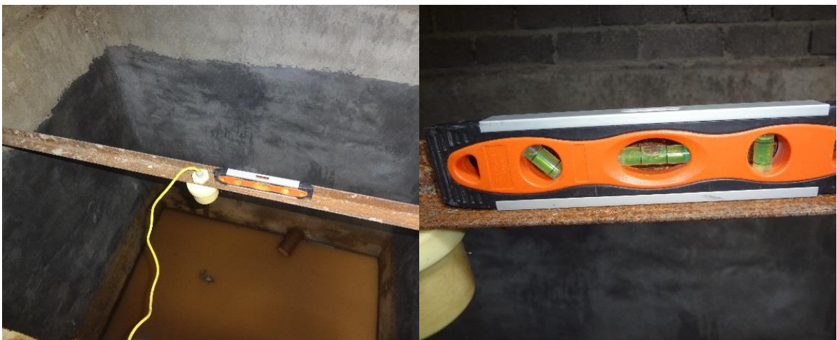
Ilustración I.65. Nivelación y acomodo del sensor ultrasónico de la microcuenca Malacate.
