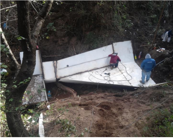
Aforador instalado en secciones
