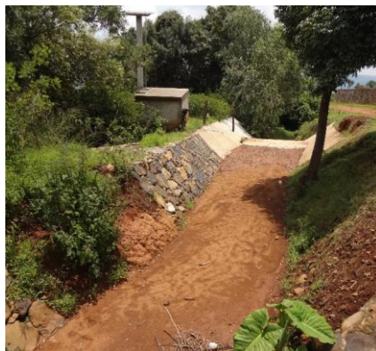
Ilustración I.59. Aforador de garganta larga azolvado en la microcuenca Malacate.
