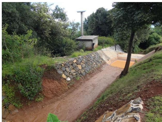
Ilustración I.60. Aforador de garganta larga desazolvado en la microcuenca Malacate.
