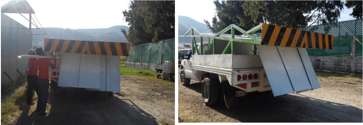
Ilustración I.0.50. Proceso de transporte y traslado de piezas del aforador para su instalación en sitio.
