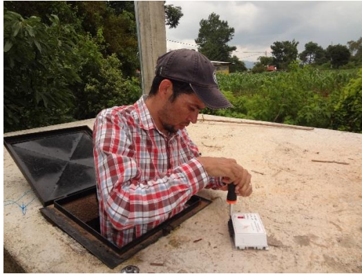
Ilustración I.69. Revisión del controlador de carga de la microcuenca Ichupio.
