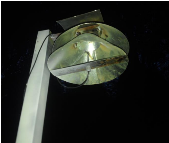
Sensor de temperatura instalado
