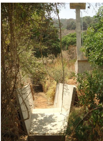
Ilustración I.67. Vista del canal de llegada y aforador sin azolve y limpio de maleza.
