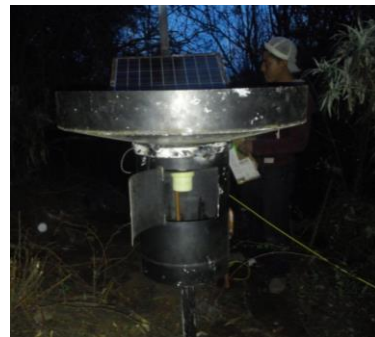
Sensor del pluviómetro
