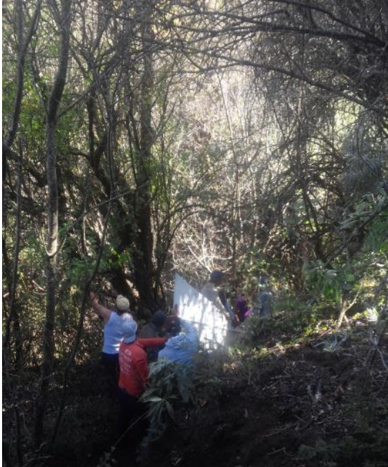
Colocación de piezas de aforador
