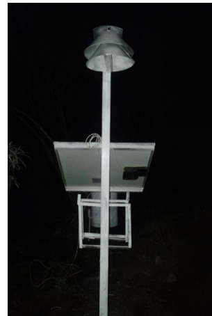
Ilustración I.54 Proceso de instalación en campo de la estructura y equipo hidrotermopluviométrico.
