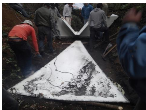
Ilustración I.52 Proceso de ensamblado y soldado del aforador de garganta larga en el sitio seleccionado.
