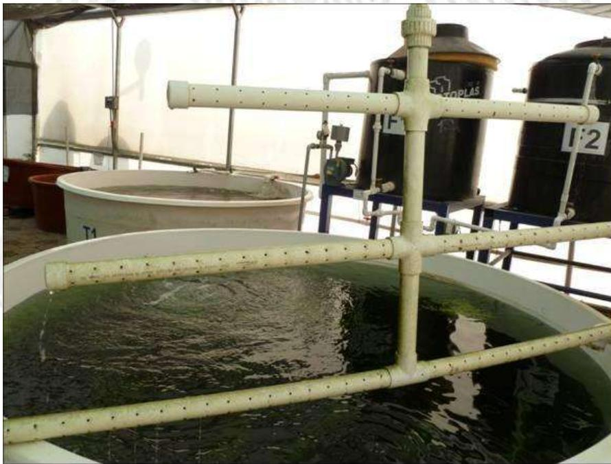
Foto 4.3 Ramal de succión de tanques
