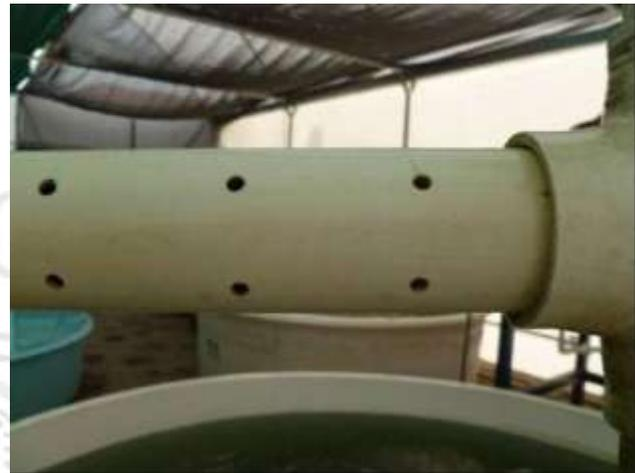
Foto 4.1 Ramal de distribución de agua en el interior del filtro
