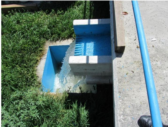
**Figura 3.2.7 Descarga del agua tratada efluente de los tres sistemas experimentales (el tubo blanco ubicado al lado de la descarga de la PTAR Texcal (el canal azul)).**
