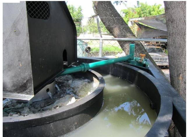
**Figura 3.2.2** Reactor R1: a) detalle de la conexión del tubo del influente al distribuidor del agua en la parte superior del reactor (izquierda); b) detalle de la conexión del tubo de la recirculación del efluente.
