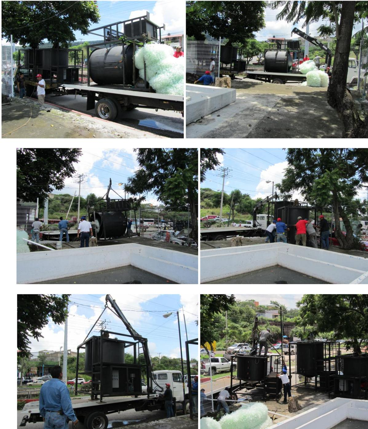
**Figura 3.1.1** Transporte de los reactores hasta la PTAR Texcal y su ingreso al sitio de su instalación.
