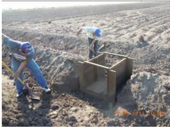
b) Instalación de regadera
