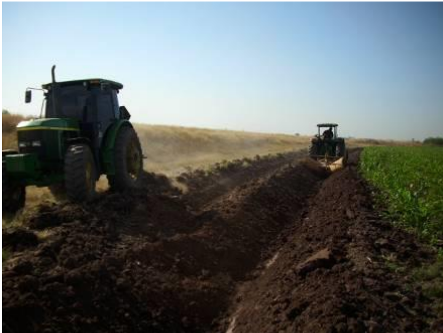
Imagen 2.85 Construcción de regadera principal y auxiliar con bordero y canalera 6 de marzo de 2012
