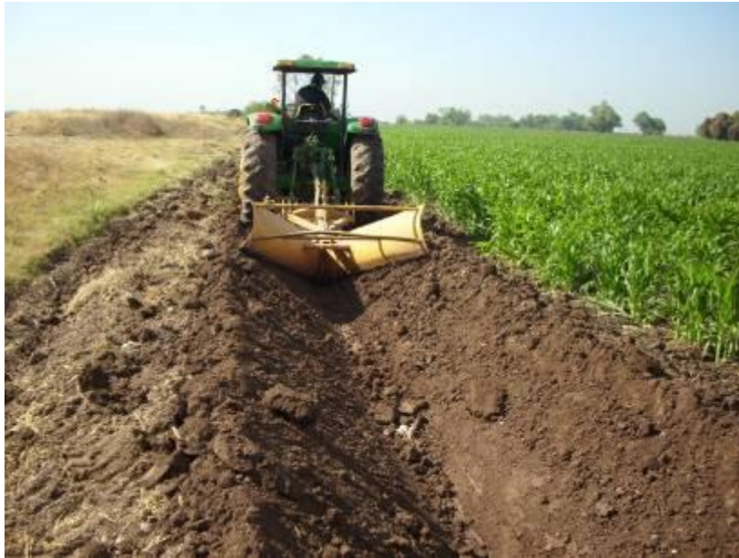
Imagen 2.86 Afine de regadera principal y auxiliar con canalera 6 de marzo de 2012
