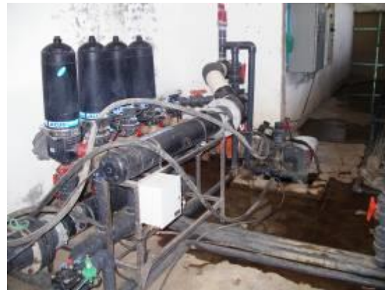
a) Texto Imagen 1.5 Cabezal de bombeo, equipo motor bomba y filtrado e inyección de fertilizantes. b) Texto
