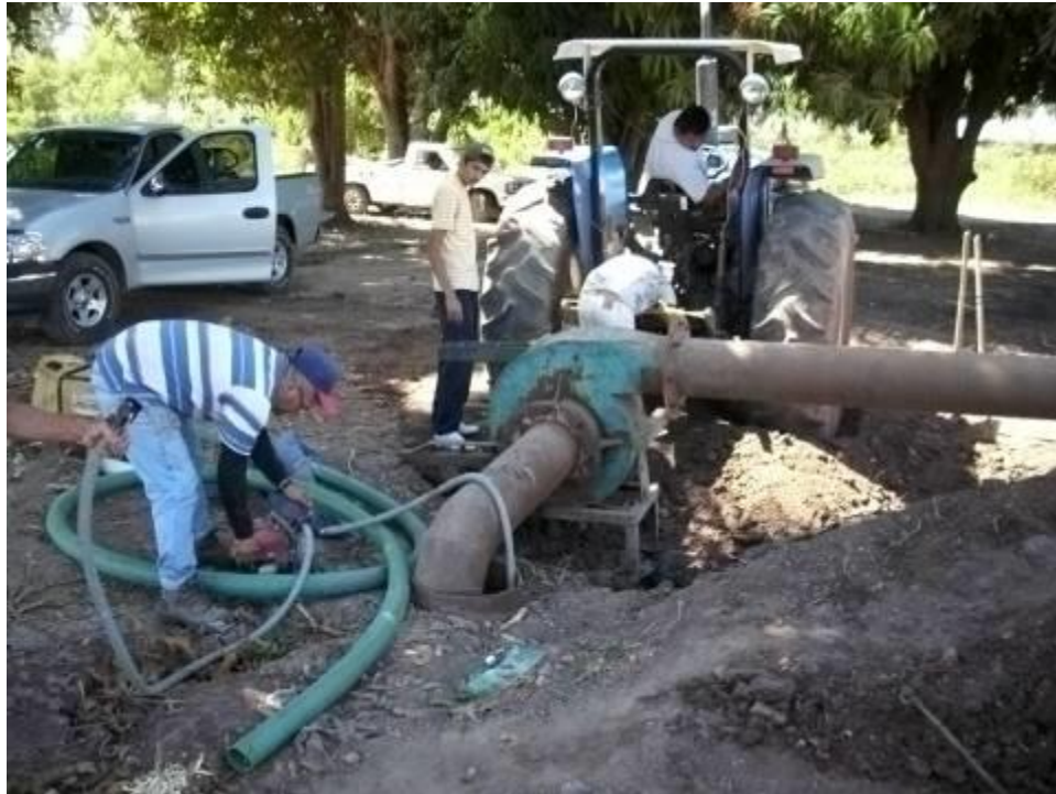
Imagen 2.92 Habilitación de tractobomba centrífuga 7 de marzo de 2012
