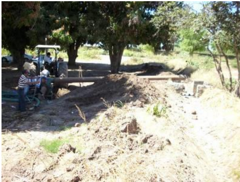
Imagen 2.91 Habilitación de tractobomba centrífuga 7 de marzo de 2012
