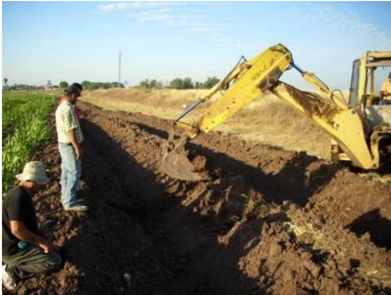
Imagen 2.88 Preparación del sitio para estructuras de madera 6 de marzo de 2012
