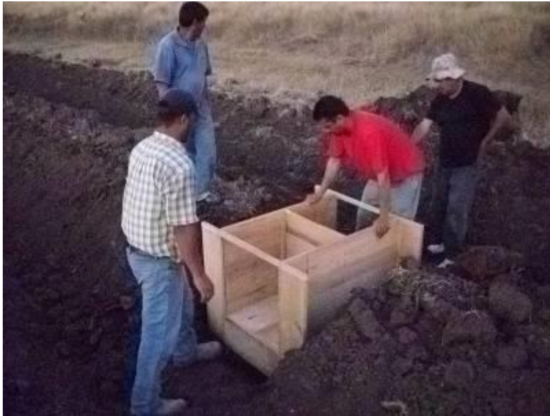
Imagen 2.90 Instalación de estructura de madera individual 6 de marzo de 2012
