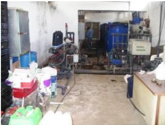
a) Texto Imagen 1.5 Cabezal de bombeo, equipo motor bomba y filtrado e inyección de fertilizantes. b) Texto
