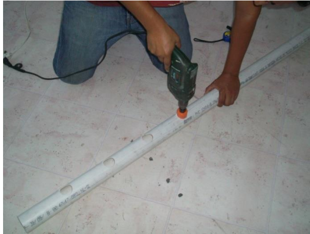
Figura 19. Realización de las perforaciones circulares en los tubos.
