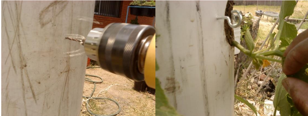
Figura 112. Perforación, y colocación de las armellas a los tubos.
