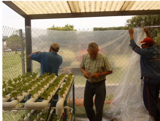
Figura 64. Colocación del polietileno.
