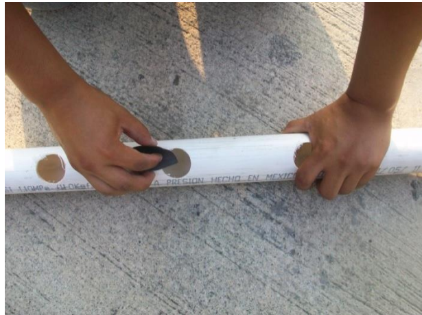
Figura 21. Eliminación de rebabas en el tubo.
