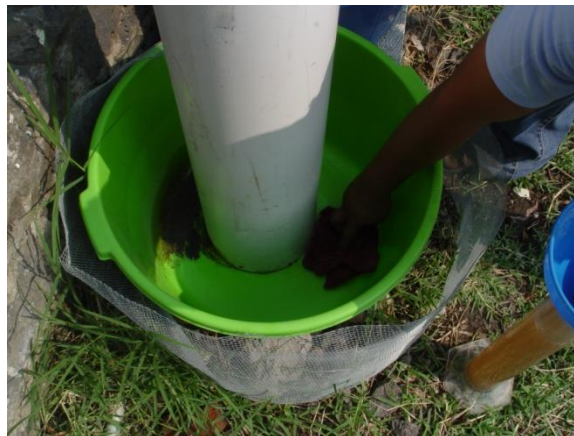
Figura 104. Utilización de un trapo para sacar el agua excedente.
