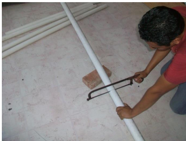
Figura 18. Obtención de los tramos de P.V.C., de 1.5 m de largo.
