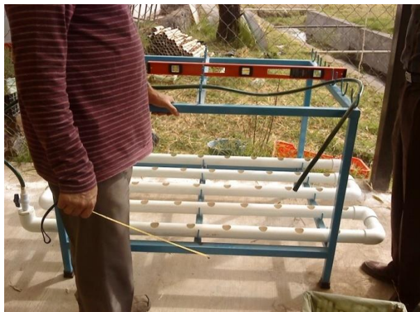
Figura 29. Nivelación de la estructura metálica y tubos de P.V.C.
