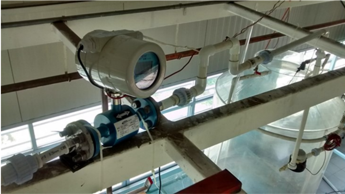
Foto 8. Instalación del Caudalímetro electromagnético antes del depósito, continuación.
