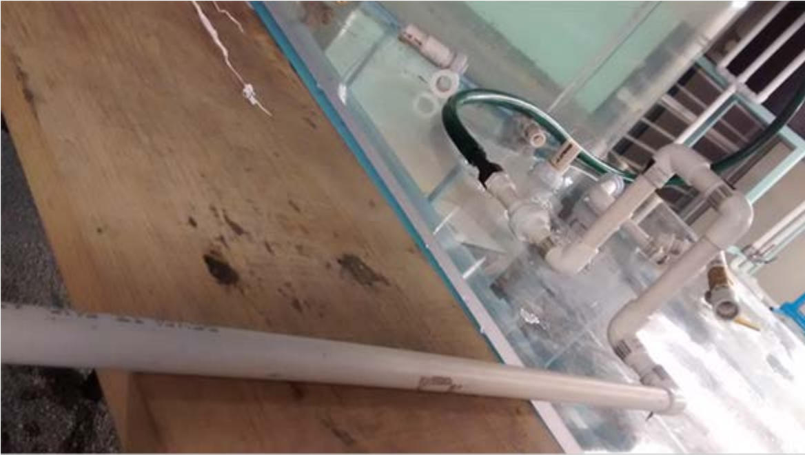
Foto 14. Instalación del caudalímetro y del micromedidor obviando el depósito, continuación.
