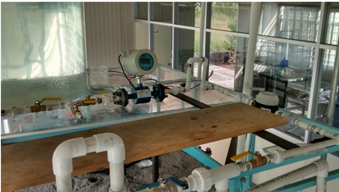
Foto 9. Instalación de caudalímetro electromagnético después del depósito
