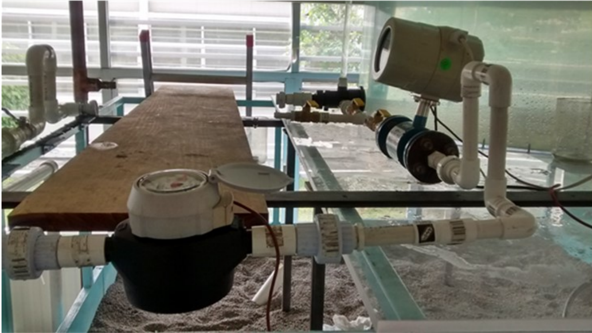
Foto 12. Instalación de caudalímetro electromagnético después del depósito, continuación
