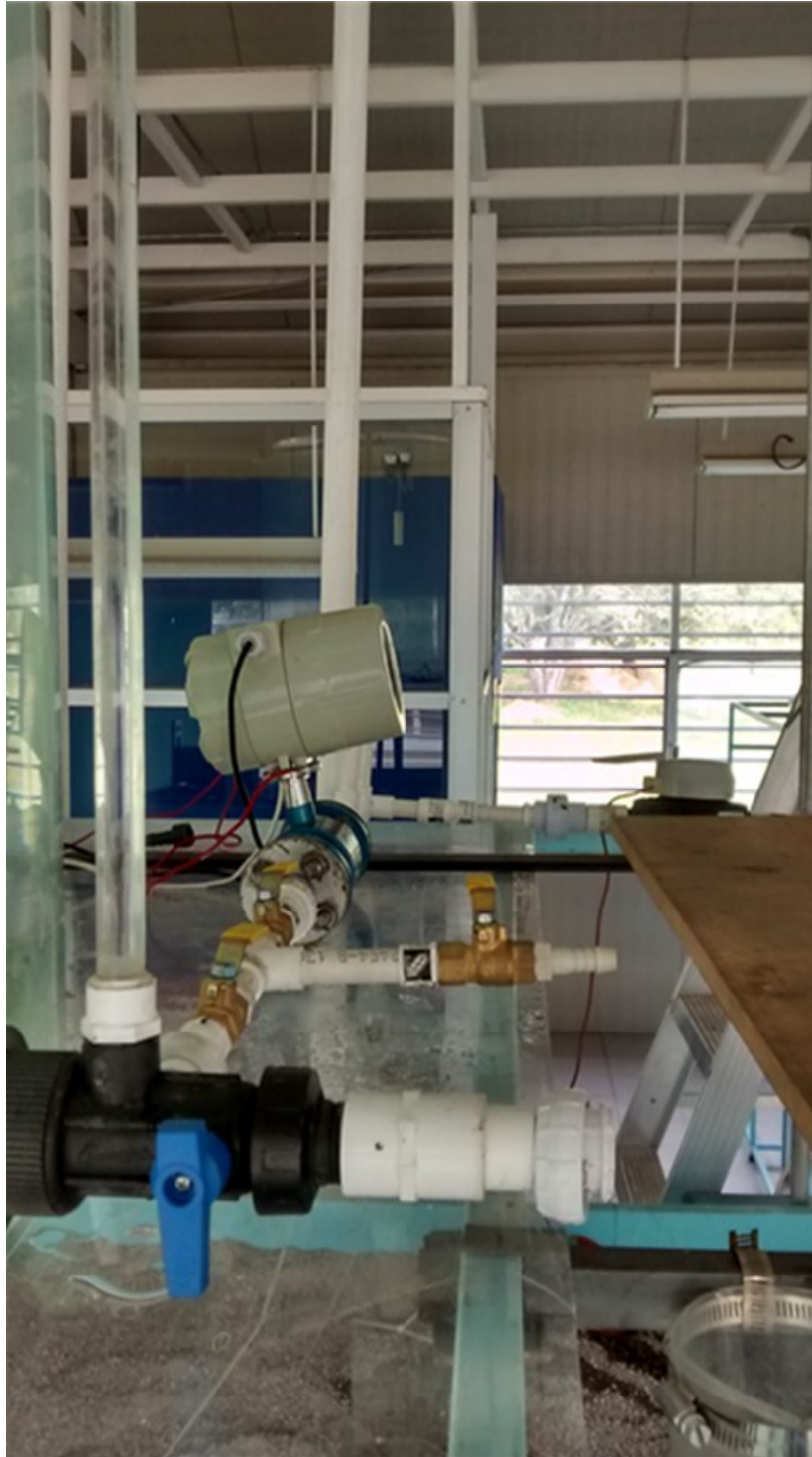
Foto 10. Instalación de caudalímetro electromagnético después del depósito, continuación.
