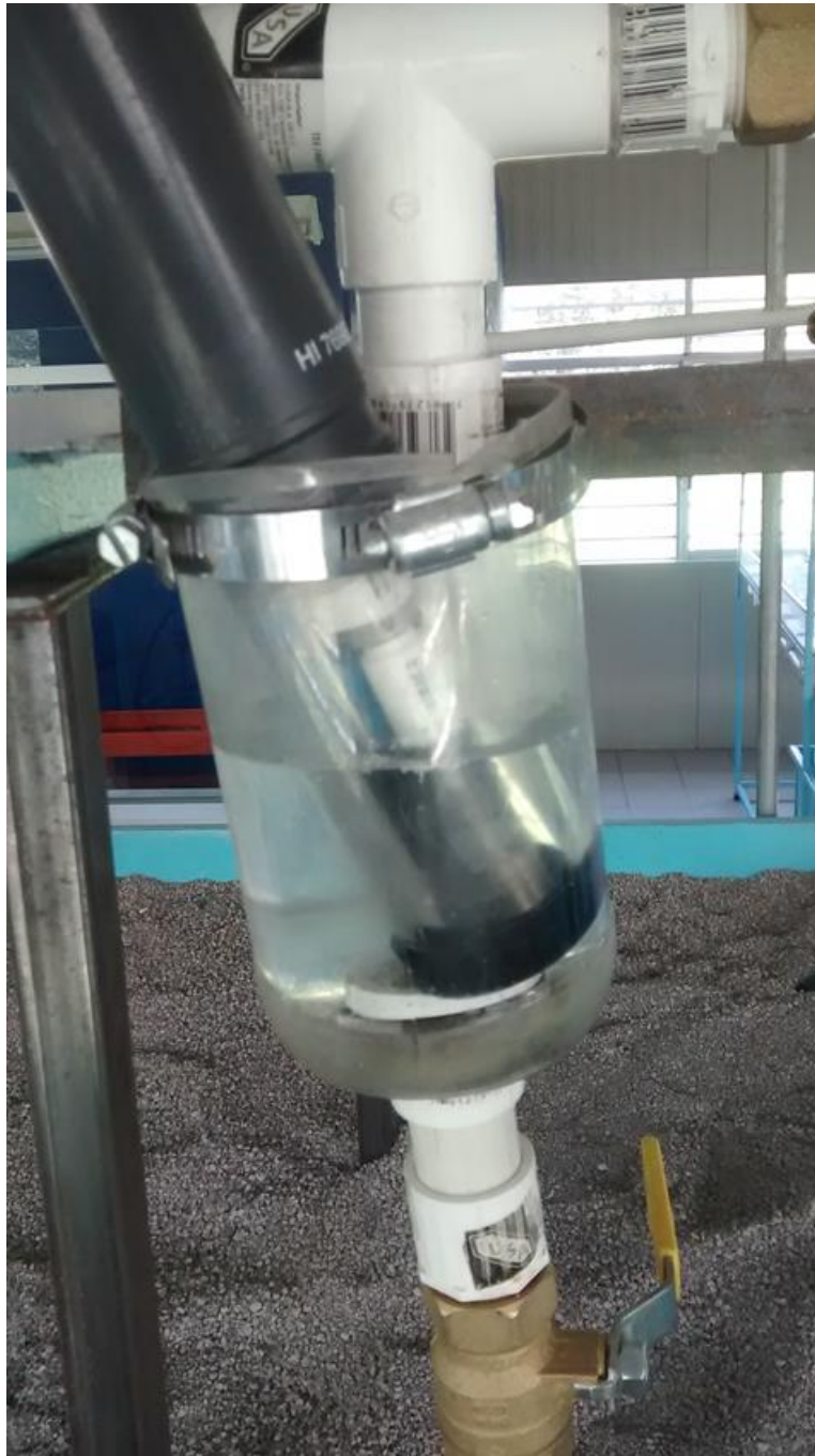
Ilustración 8. Sensor del multiparamétrico en la salida del tinaco.
