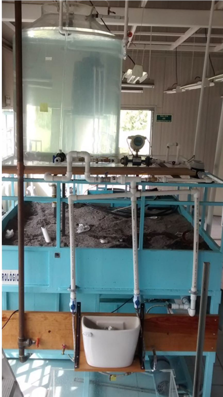
Foto 11. Instalación de caudalímetro electromagnético después del depósito, continuación.
