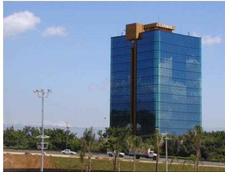
Ilustración 119. Vista de la estructura con la que cuenta la torre Animas.
