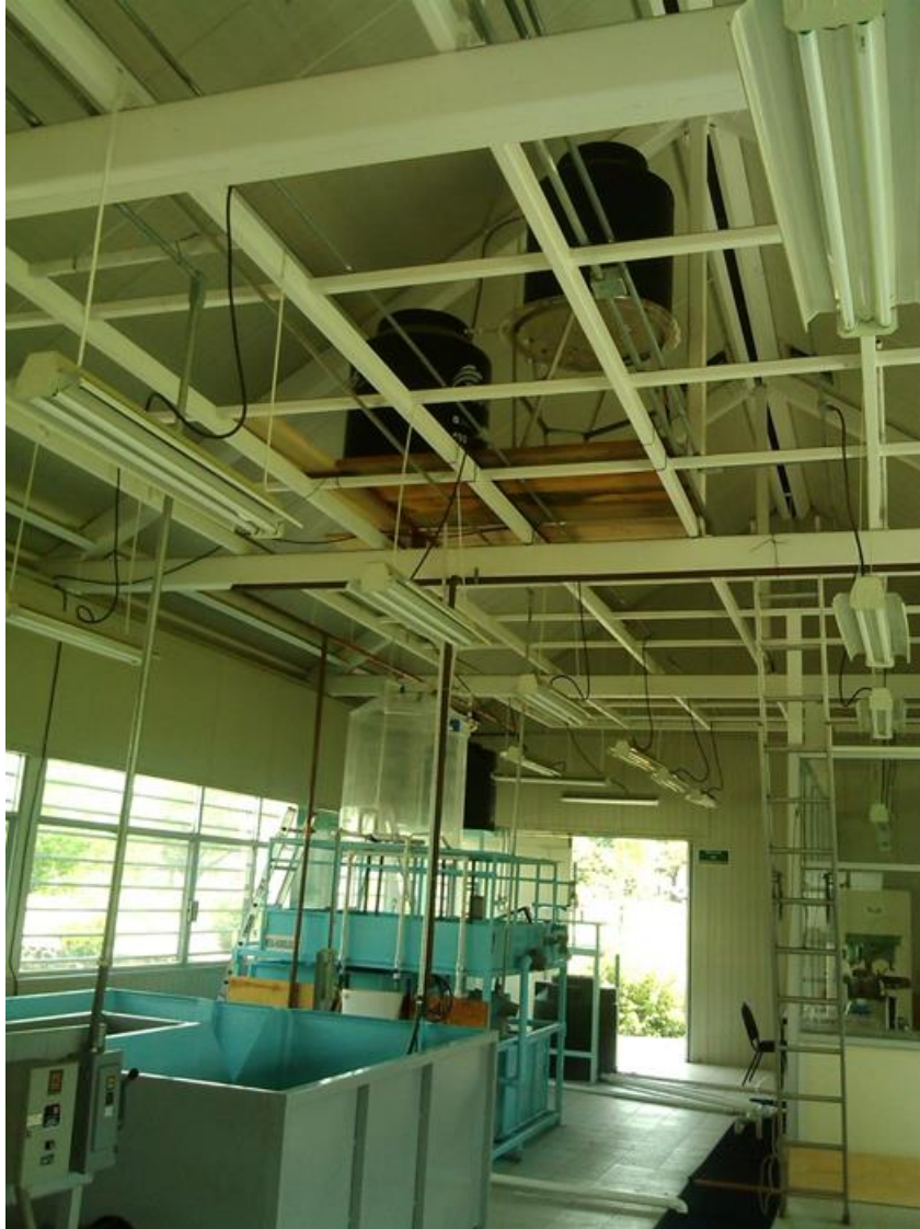
Ilustración 4. Alimentación del tinaco de acrílico
