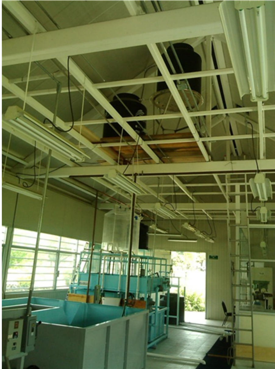
Foto 2. Sistema de depósitos
