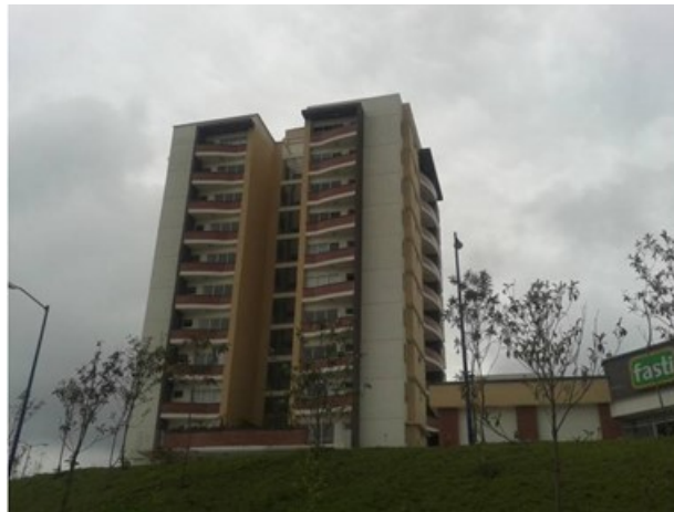
Ilustración 116. Vista de la estructura con la que cuenta la Torre Halcón.
