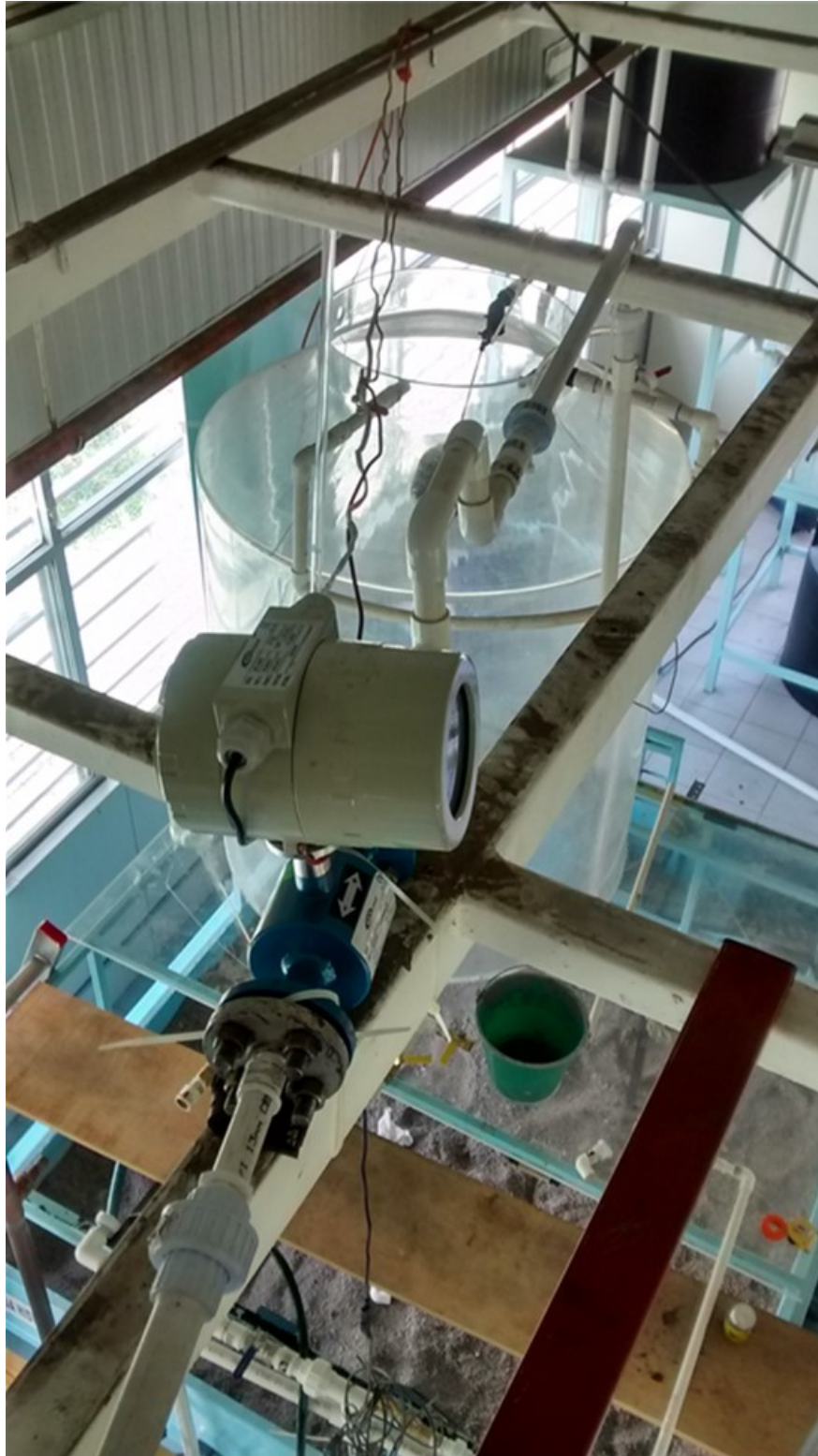
Foto 7. Instalación del Caudalímetro electromagnético antes del depósito, continuación.
