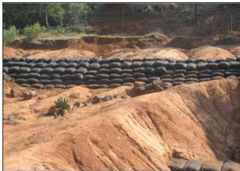
Figura 5.8 Ejemplo de represa de geocostal, comunidad de Nocutzepo
