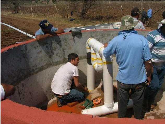
Ilustración 5. Sifón interno y tubería de riego
