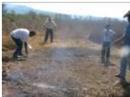
Limpieza del terreno
