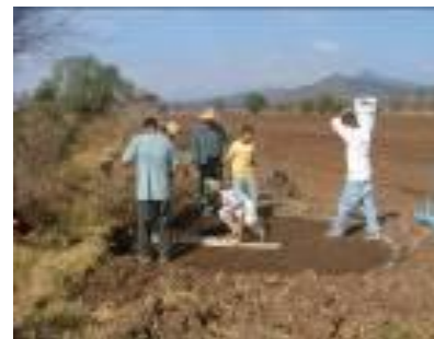
Relleno y nivelación del terreno
