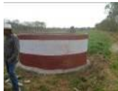
Tanque TDF terminado
