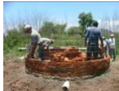
Levantamiento de muro capuchino
