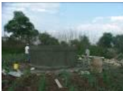
Terminado de Repellado
