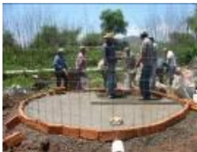
Colado del fondo
