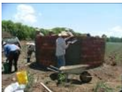
Repellado de paredes
