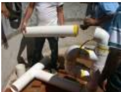
Talleres de instalación del sifón interno autocebante
