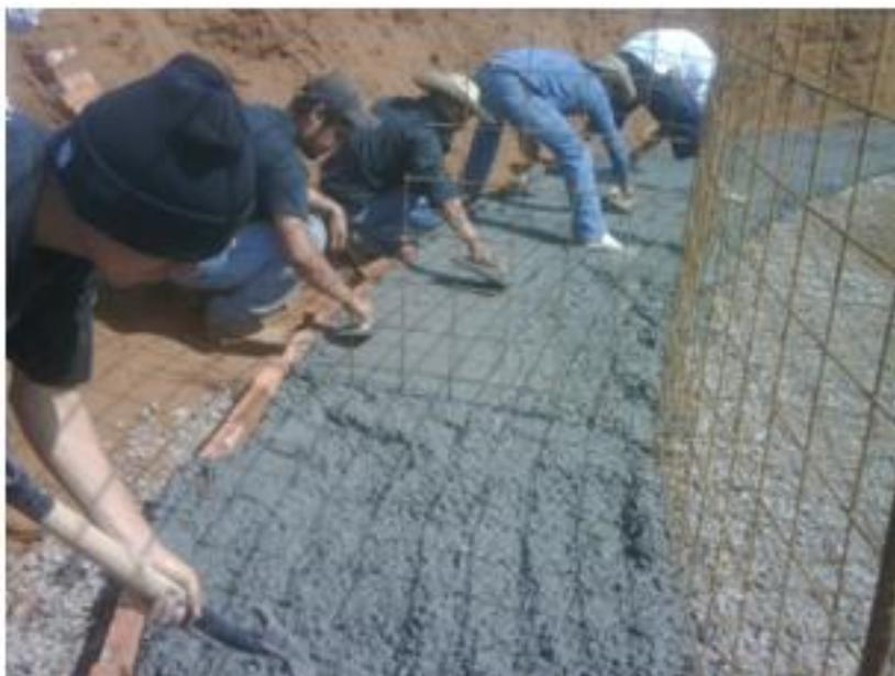
**Ilustración 31.** Colado de la banda perimetral para fijación y refuerzo de los contrafuertes
