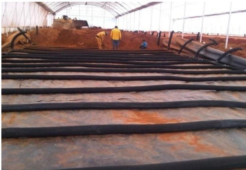
**Ilustración 50.** Colocación de la red de tubería subterránea
