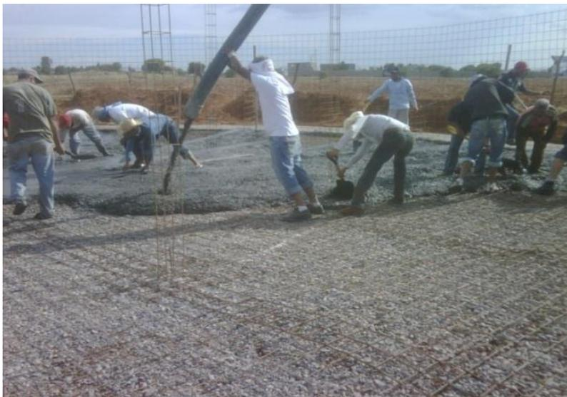
**Ilustración 34.** Colado de losa de fondo de la cisterna
