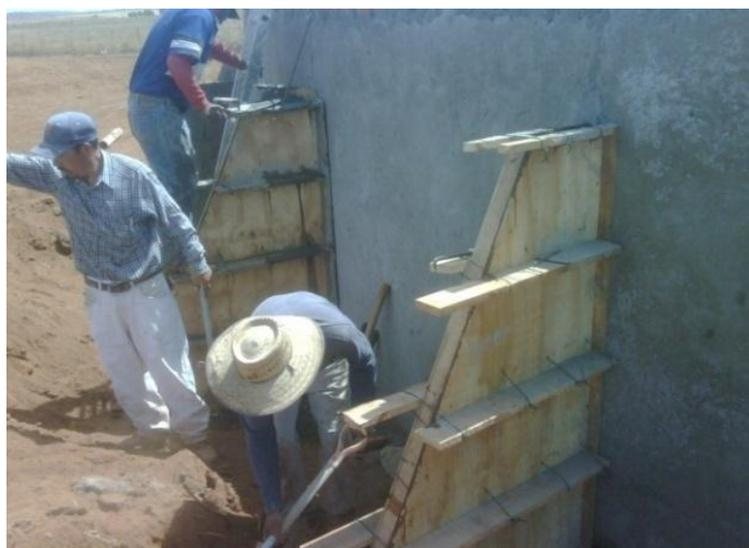
**Ilustración 42.** Cimbra y colado de contrafuertes
