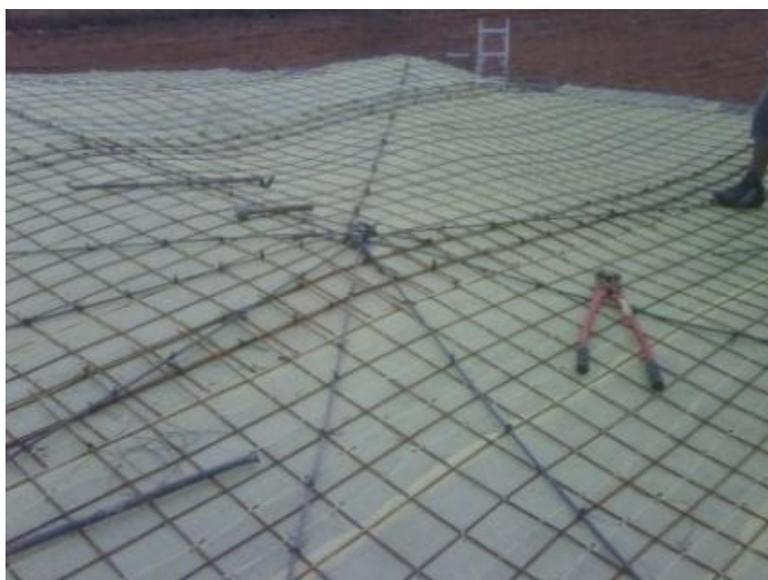
**Ilustración 43.** Armado de varillas en el techo de la cisterna
