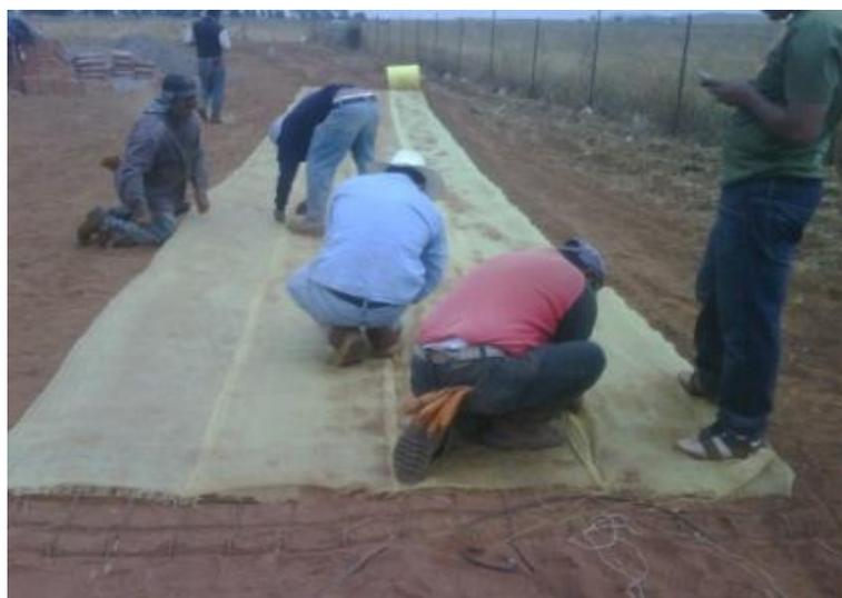
**Ilustración 37.** Corte y tejido de la malla con la arpilla para el armado del techo de la cisterna
