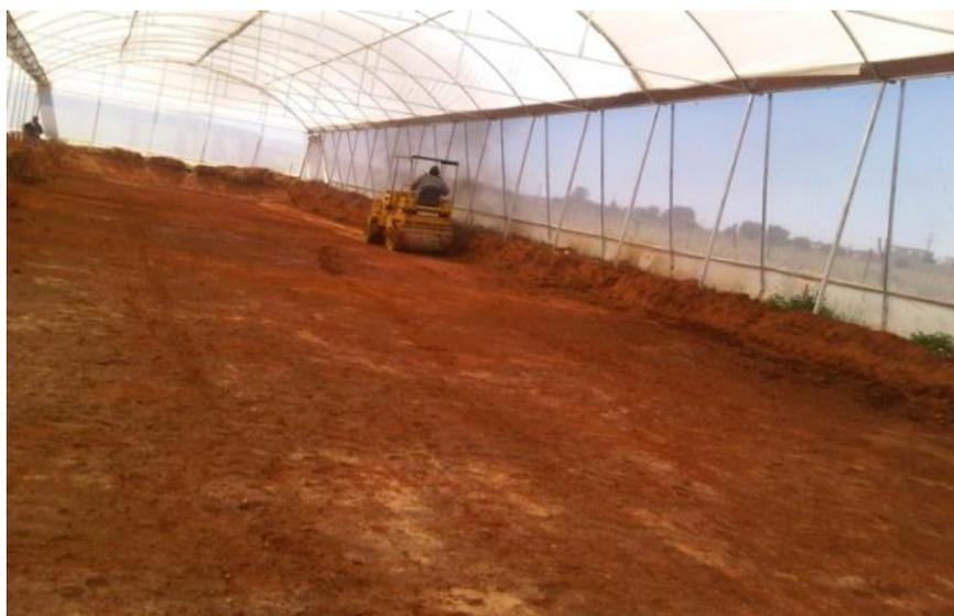
**Ilustración 52.** Paso de maquinaria sobre el terraplén
