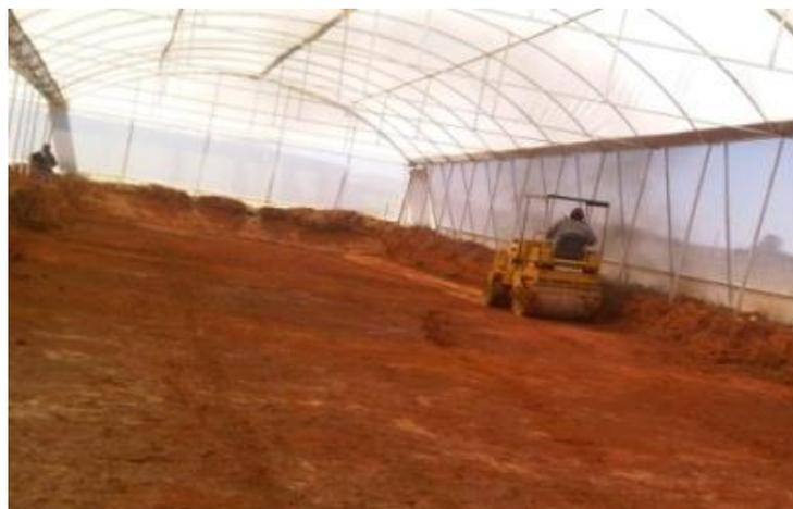
**Ilustración 14.** Paso de maquinaria sobre el terraplén
