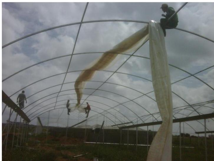
**Ilustración 22.** Instalación del hule en la parte superior del invernadero (techo del invernadero)
