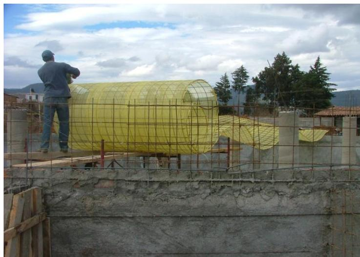
**Ilustración 38.** Colocación del armado del techo de la cisterna
