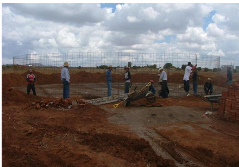
**Ilustración 29.** Armado general de la cisterna
