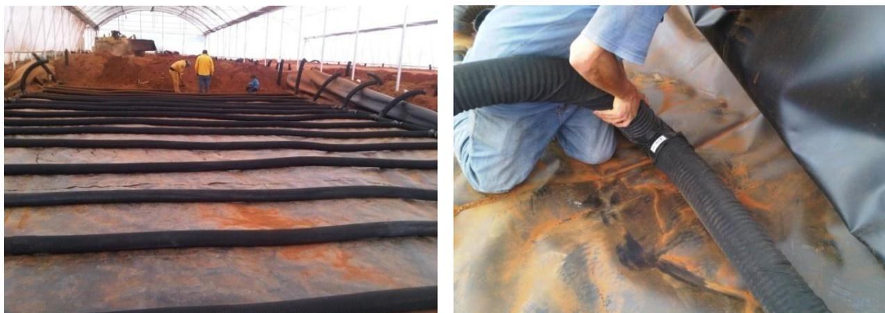
**Ilustración 13.** Colocación de la red de tubería subterránea
