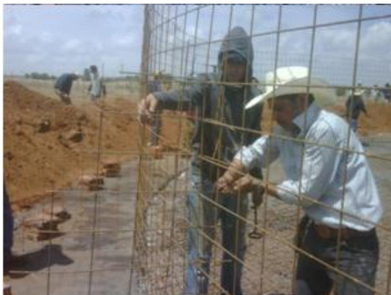
**Ilustración 32.** Fijación y amarre de contrafuertes al cuerpo perimetral de la cisterna
