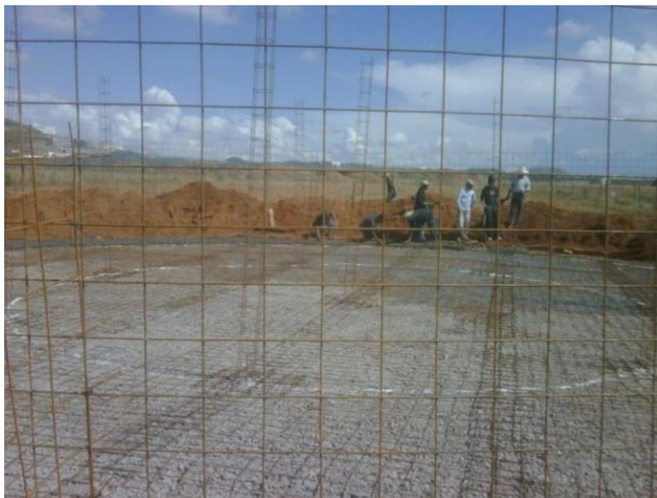
**Ilustración 33.** Armado del cuerpo de la cisterna y columnas
