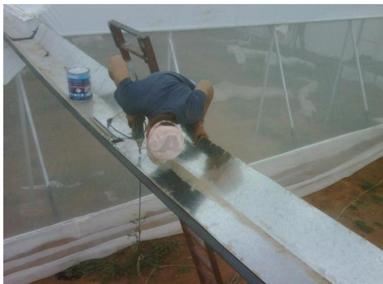
**Ilustración 20.** Instalación de canaleta de recolección de agua de lluvia hacia la cisterna
