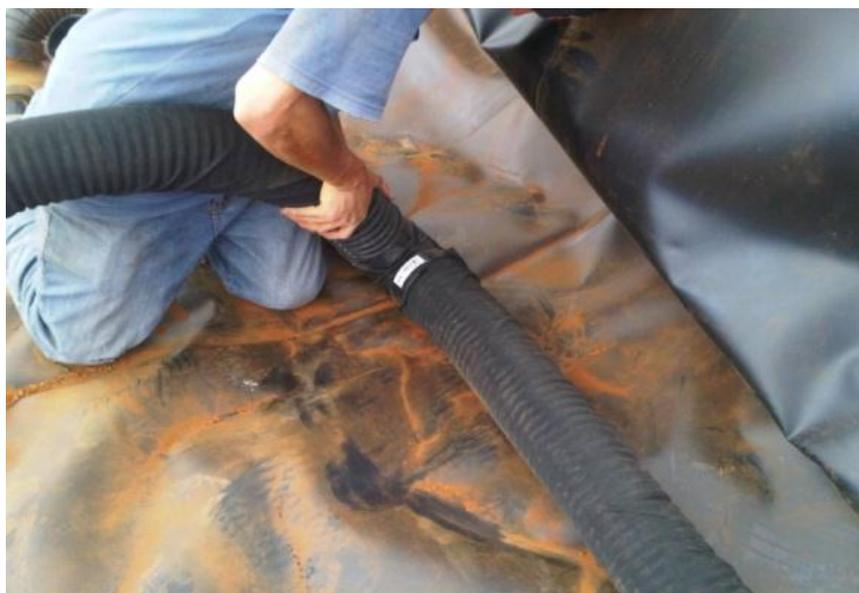
**Ilustración 51.** Ensamble de la red de tubería subterránea
