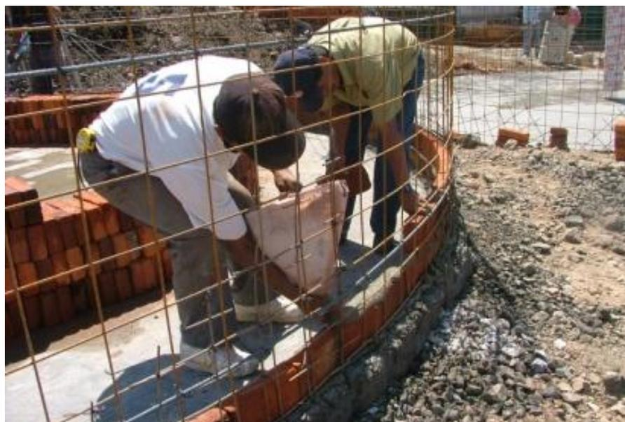
**Ilustración 35.** Levantamiento del muro capuchino
