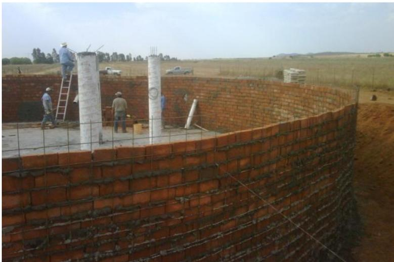
**Ilustración 36.** Levantamiento del muro de la cisterna - muro capuchino
