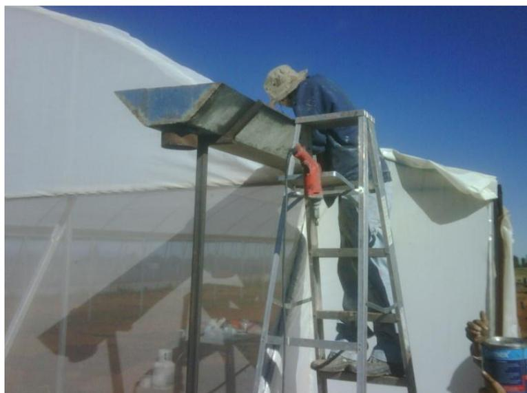
**Ilustración 21.** Instalación de canaleta de recolección de agua de lluvia
