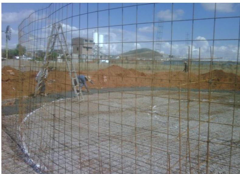
Ilustración 30. Anillo de refuerzo en paredes
