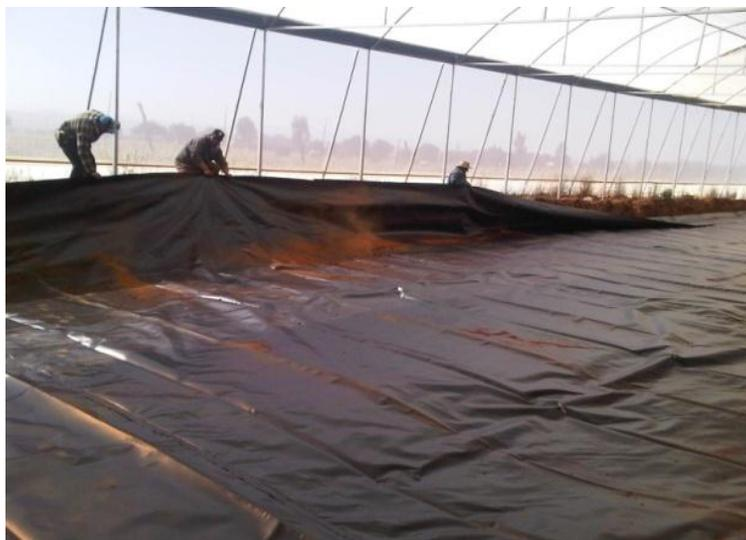
**Ilustración 12.** Colocación de la geo membrana
