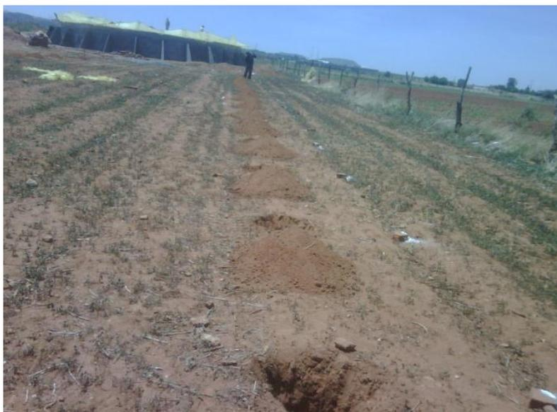
**Ilustración 15.** Hoyos de 45 centímetros para cimentación de columnas
