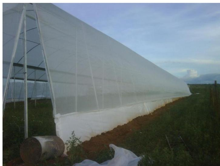
**Ilustración 23.** Instalación de la malla antiáfidos en los laterales del invernadero
