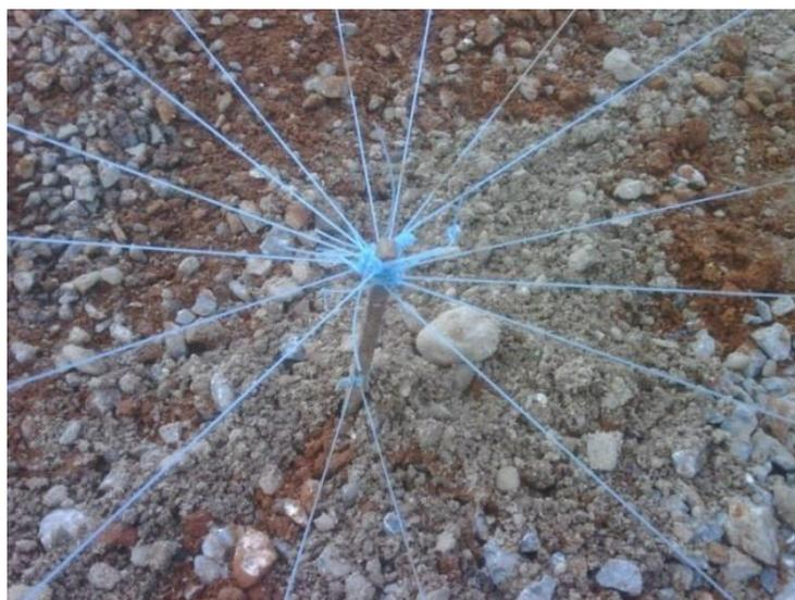
**Ilustración 27.** Nivelación con hilo radialmente
