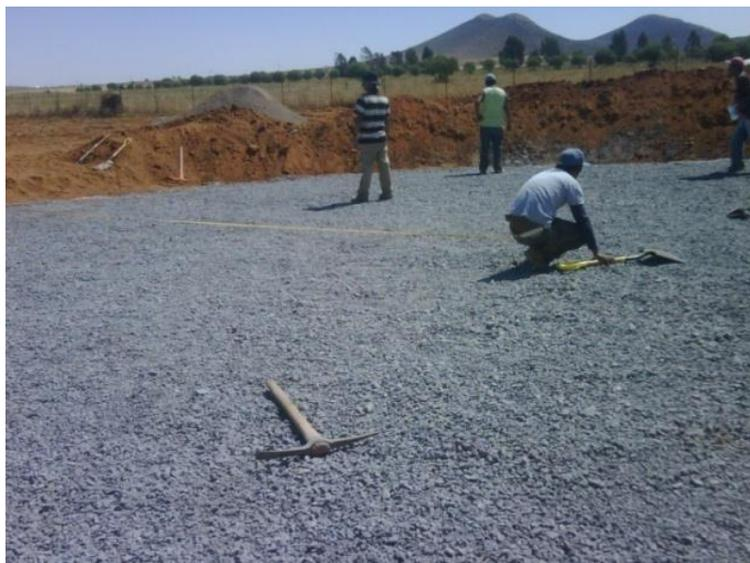
**Ilustración 28.** Preparación y colocación de una capa de grava para el colado de losa de fondo
