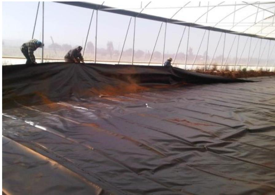
**Ilustración 49.** Colocación de la geo membrana
