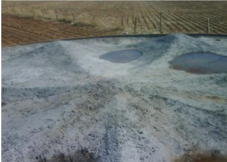
**Ilustración 44.** Colado del techo de la cisterna
