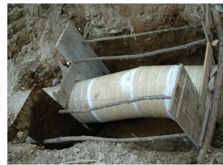
d) Colocación de tubería y cinturones de sellado
