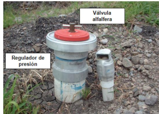
a) Codo de arranque, regulador de presión y válvula alfalfera
