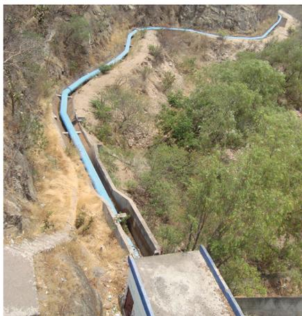
Foto 1.1. Reemplazo de canal a cielo abierto por entubado
