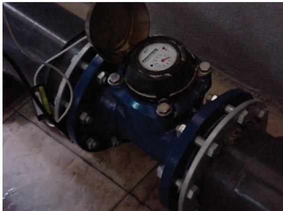
Foto 4.8 Medidor de propela con contador volumétrico
