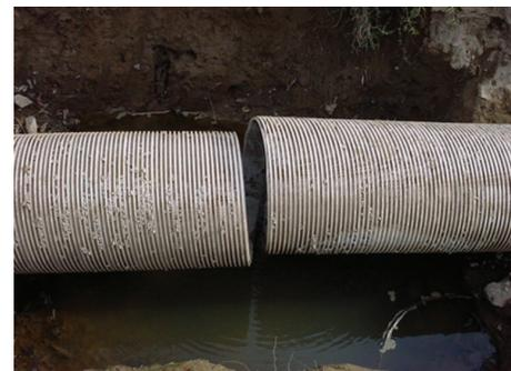
Foto 6.2 Fugas en la tubería
