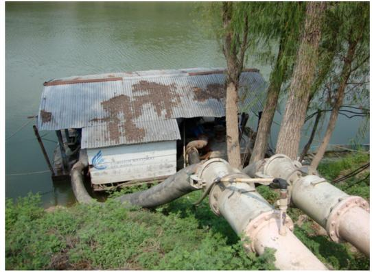
a) Equipo de bombeo con extracción de un río
