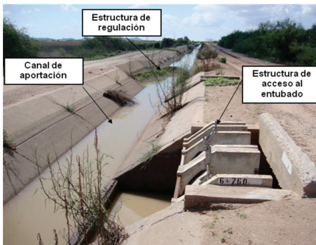
b) Represa tipo pico de pato y módulo aforador
