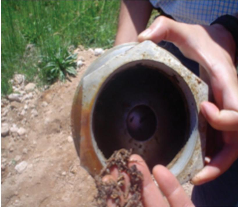
Foto 6.16 Limpieza de azolve en una válvula de aire
