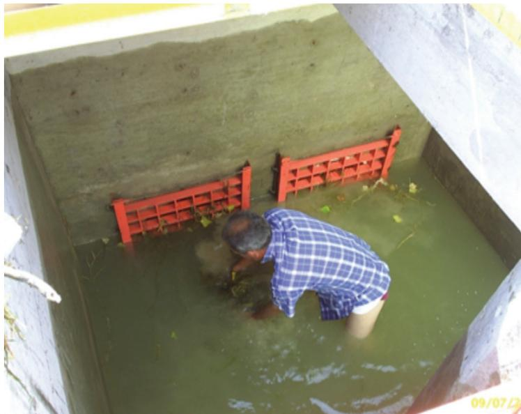
Foto 6.13 Mantenimiento manual de rejillas
