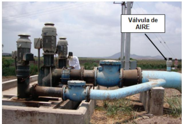
b) Tren de descarga en pozo o cárcamo de bombeo
