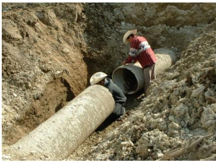
a) Cortar los extremos de la tubería dañada
