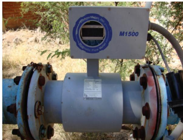
Foto 2.35 Medidor electromagnético
