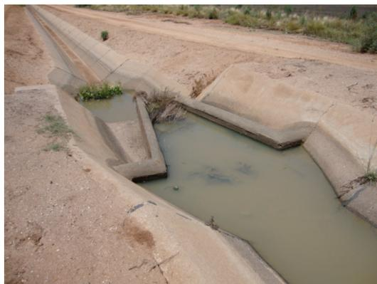
d) Inexistencia de la compuerta de mantenimiento
