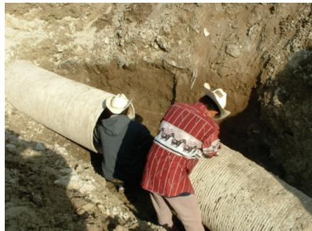
c) Limpieza del interior de la tubería
