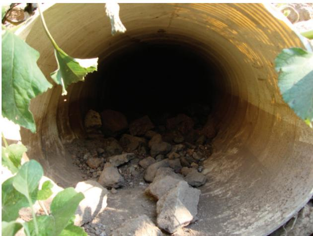
Foto 6.6 Azolve en la tubería
