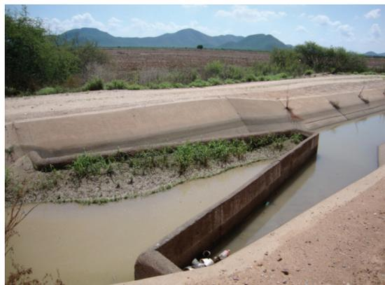
c) Azolve en la estructura de regulación
