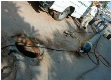
c) Adaptador y cabezal de rompimiento
