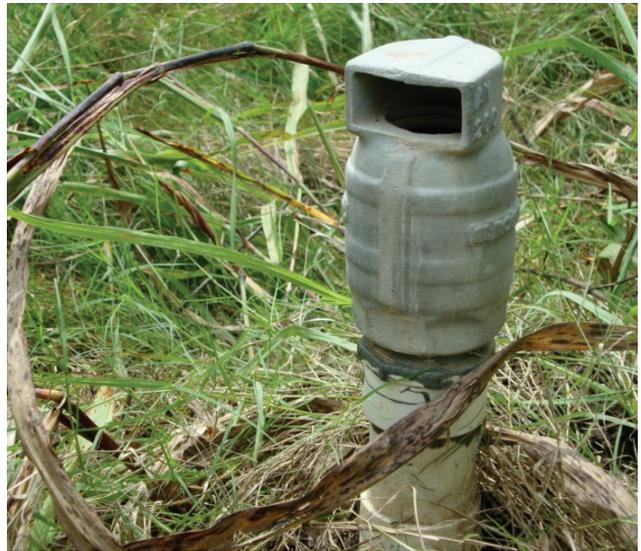
Figura 2.13 Válvula de aire en la red de distribución
