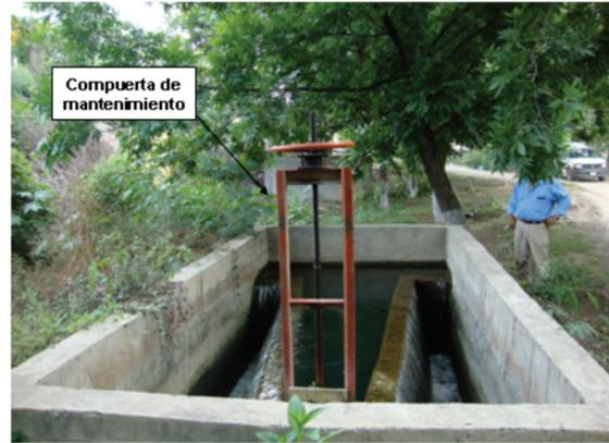
Foto 6.7 Compuerta de mantenimiento en una caja de control
