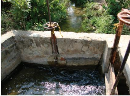
a) Deterioro de la compuerta por calidad del agua
