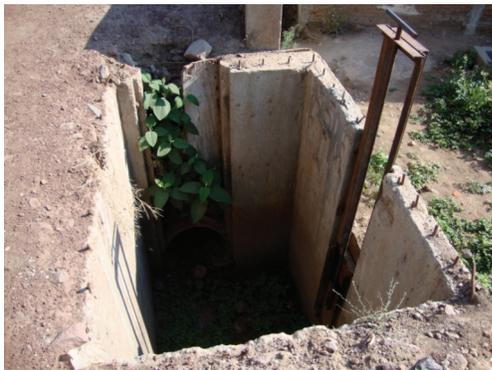
c) Compuertas y mecanismos inexistentes
