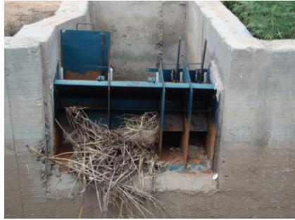
b) Oxidación de la estructura metálica
