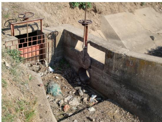
a) Trampa de azolve aguas arriba de la tubería
