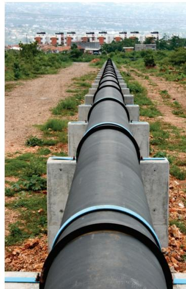
Foto 2.17 Tubería de hierro dúctil
