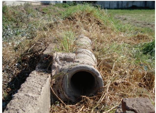
Foto 2.7 Tuberías de concreto reforzado
