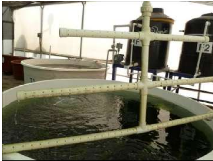
Foto 5.3 Ramal de succión de tanques
