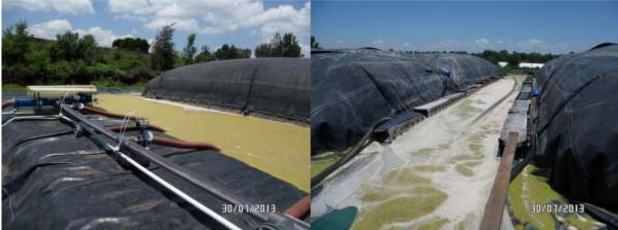
Figura 4.3. Digestores anaerobios para el tratamiento de vinazas de la tequilera Centinela
