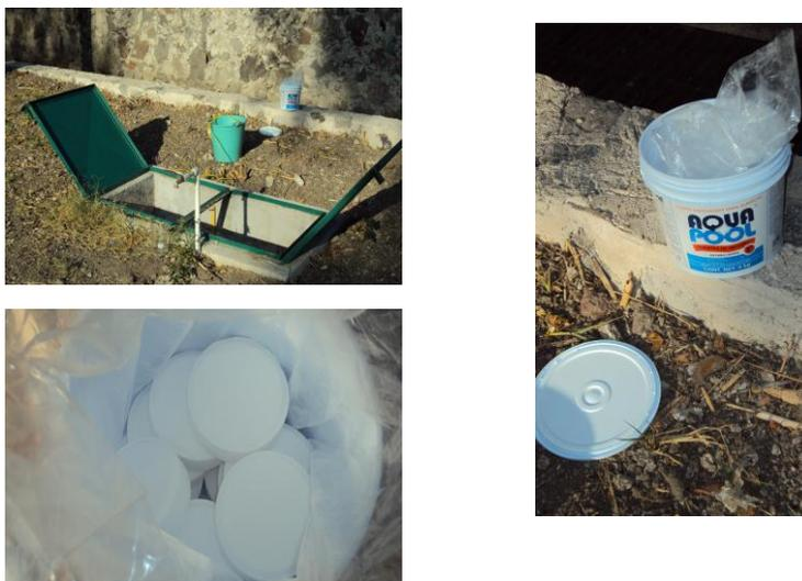
**Figura 5.** Adición de pastillas de cloro para desinfección en el tanque de almacenamiento de agua residual tratada
