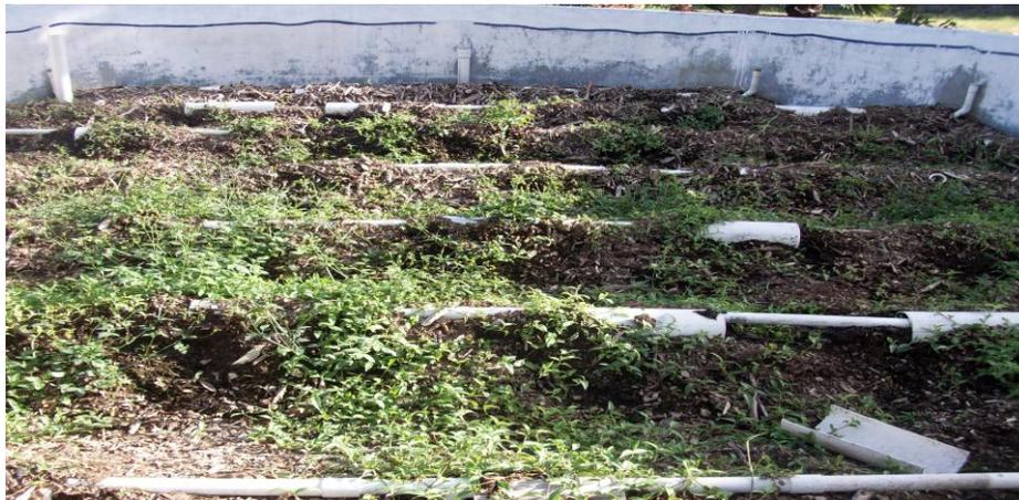
**Figura 12.** Limpieza de maleza en biofiltro
