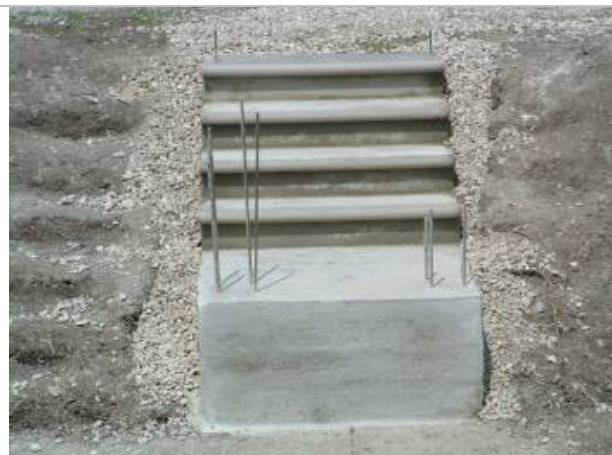
ACABADO APARENTE EN CIMENTACION Y ESCALERAS DE AMBAS MARGENES DEL CANAL DE RIEGO LAS ESTACAS.
