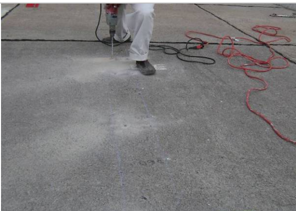
PERFORACION CON TALADRO INDUSTRIAL PARA COLOCAR TAQUETES EXPANSIVOS Y TORNILLOS
