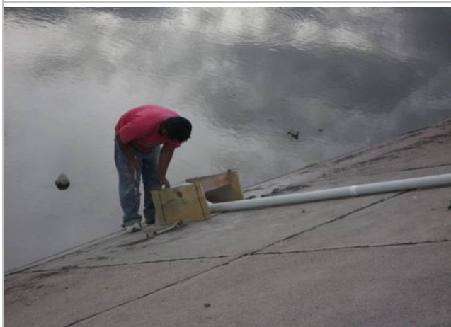
BASE DE CONCRETO Y PLACA DE NYLACERO
