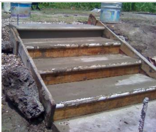
COLADO DE CIMENTACION Y ESCALERAS PARA EMPOTRAR EL PUEBTE DE AFORO.
