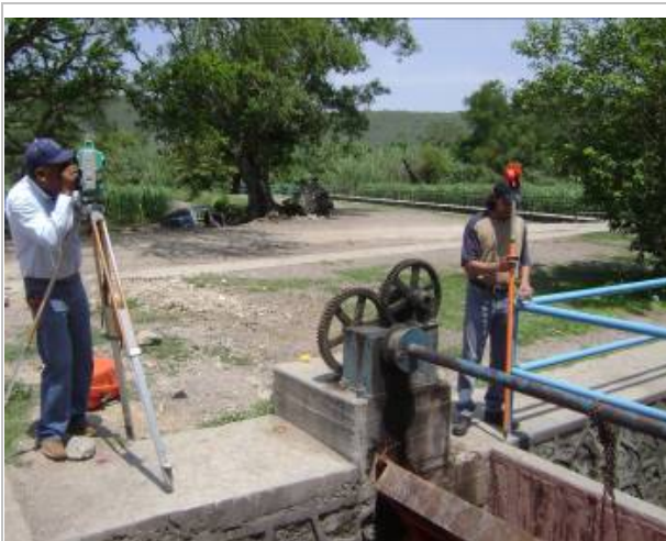
TRABAJOS NECESARIOS PARA EL LEVANTAMIENTO DE LA ESTRUCTURA DONDE SE LOCALIZA LA COMPUERTA
