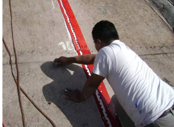
COLOCACION DE ESCALA METALICA
