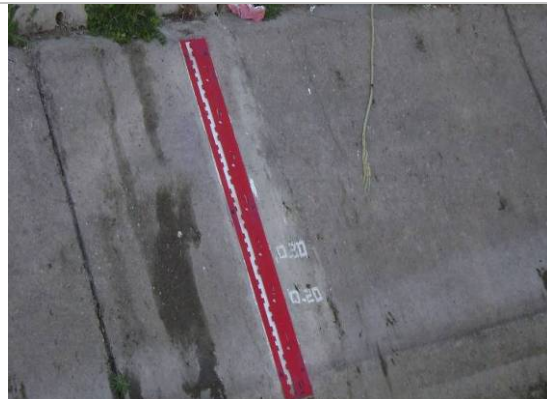
TRABAJOS DE COLOCACION DE ESCALA TERMINADOS
