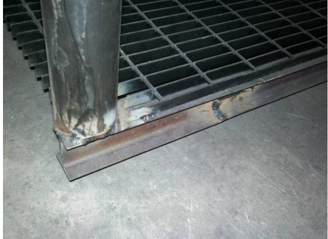
REJILLA TIPO IRVING DE 1/8" SOLDADA A LAS VIGAS
