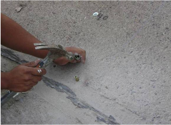
TAQUETES EXPANSIVOS Y TORNILLOS DE CABEZA PLANA DE SEGURIDAD
