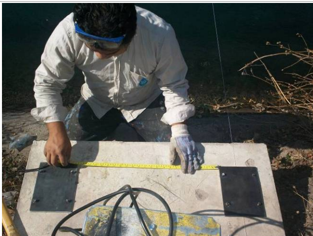
COLOCACIÓN DE PLACA DE ACERO DE 0.25 x 0.25 M. DE 1/4"
