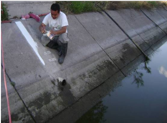
APLICACIÓN DE PINTURA EPOXICA BLANCA
