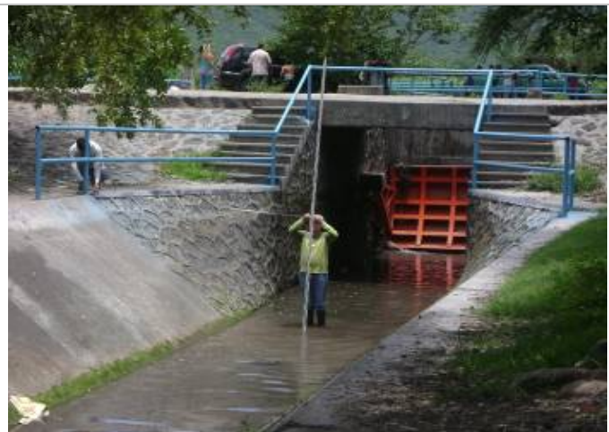
POSICIONAMIENTO DEL ESTADAL DENTRO DEL CANAL PARA OBTENER LA CONFIGURACION DE LA SECCION.
