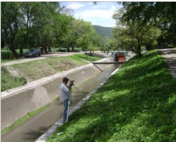
UBICACIÓN Y NIVELACION DEL EQUIPO PARA COMENZAR CON LOS TRABAJOS DE ALTIMETRIA.
