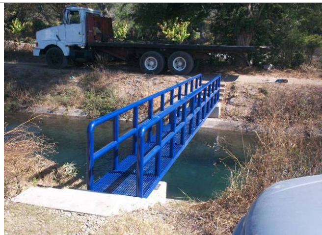
PUENTE COLADO Y SOLDADO
