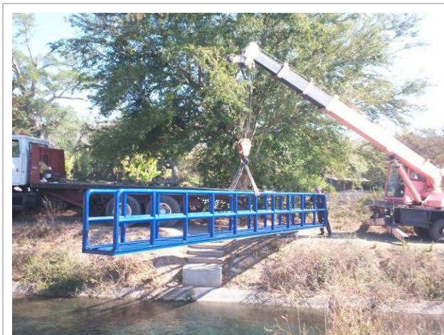
MANIOBRA DE COLOCACIÓN DE PUENTE
