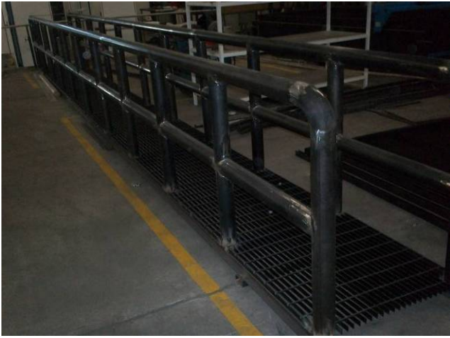
VIGAS IPS DE 3" EN FORMA PARALELA CON UNA SEPARACIÓN DE 0.80 M.
