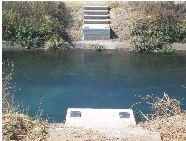
COLOCACIÓN DE PLACAS DE AMBOS LADOS
