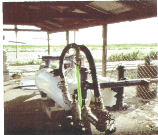
Lámina 15b. Vénturi funcionando con válvula.
