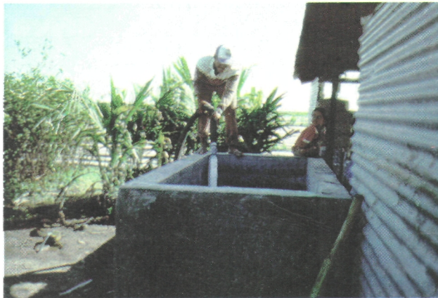
Lámina 11. Adición de agua de la fuente al tanque.
