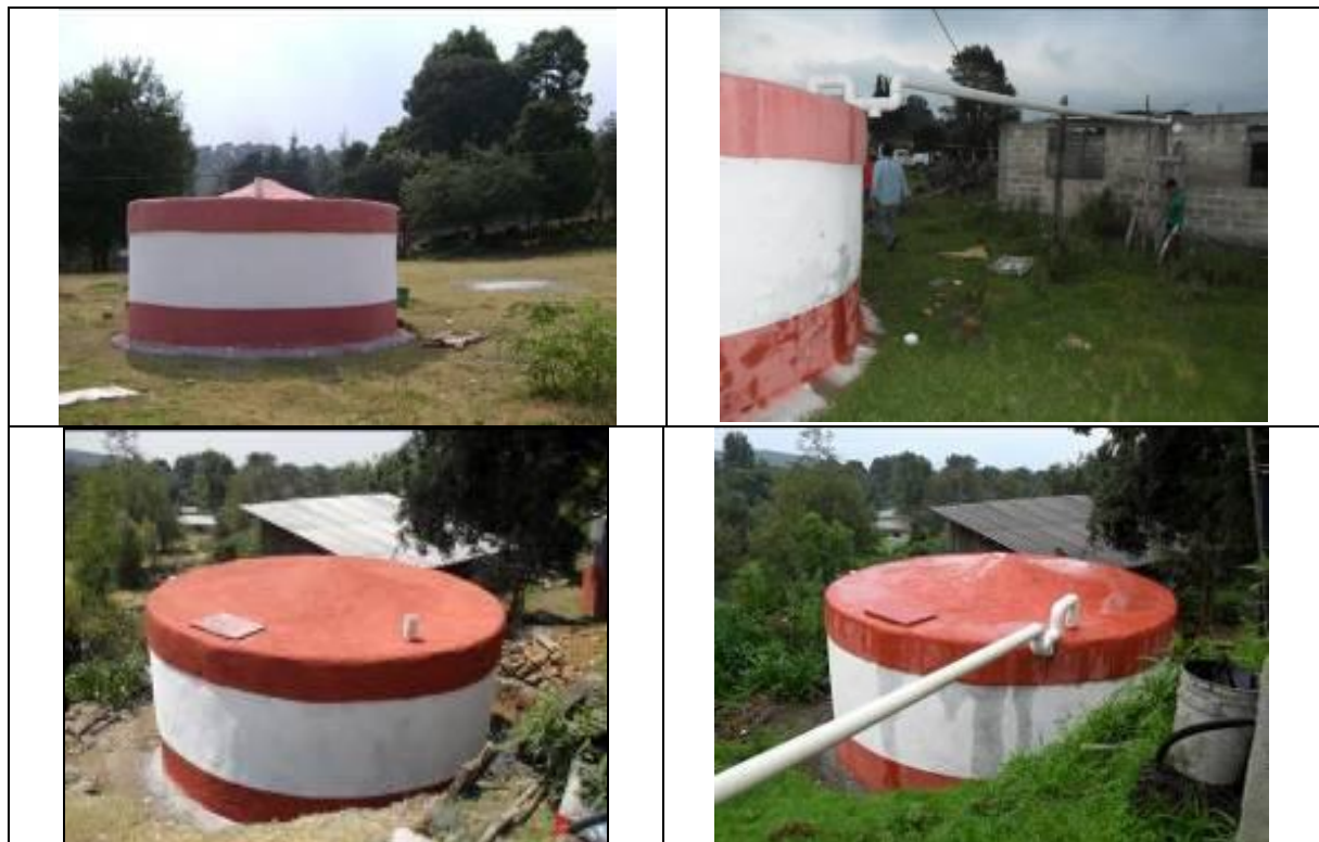
Ilustración 30. SISTEMAS DE CAPTACIÓN DE AGUA DE LLUVIA Y CISTERNAS CAPUCHINAS DE 20m 3 (a,b y c)
