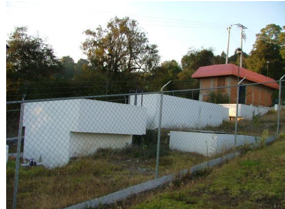
Vista lateral de la planta potabilizadora.
