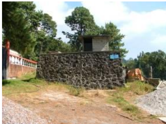
Ilustración 12. Tanque de almacenamiento comunitario (105 m 3 ) en la Comunidad de Tetecuintla Municipio de Huitzilac.
