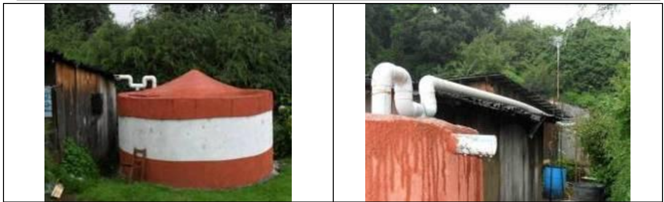
Ilustración 27. Ejemplo del taller práctico para la instalación de sistemas de captación de agua de lluvia y cisternas capuchinas de 20m 3 en Coajomulco. (Lat 478451, Long 2104296)
