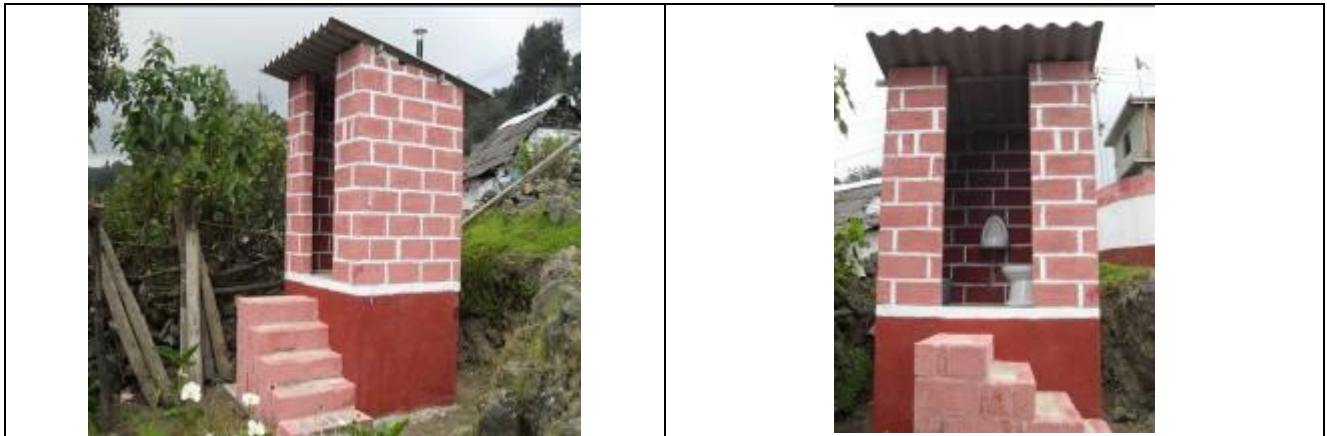
Ilustración 29. Ejemplo del taller práctico para la instalación de sanitarios ecológicos secos en Coajomulco. (Lat 478564, Long 2105049)
