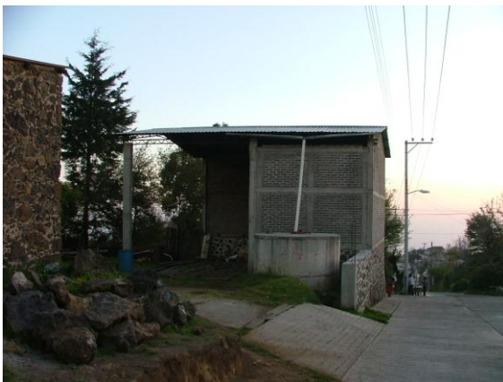
Captación de agua de lluvia
