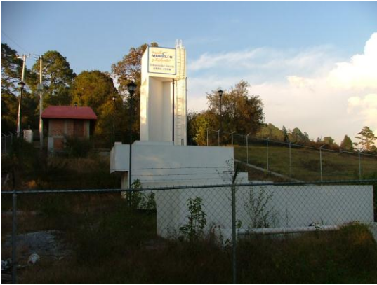
Vista frontal de la planta potabilizadora.
