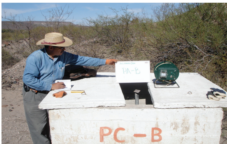
Foto 4. Evaluación de un piezómetro abierto. Presa El Naranjo, Durango.
