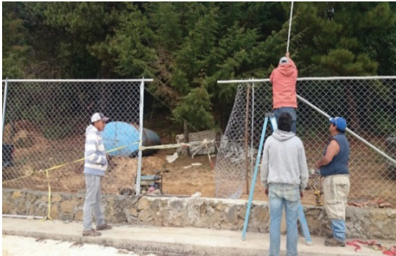
Figura 31. Revisión del estado físico de la malla ciclónica..
