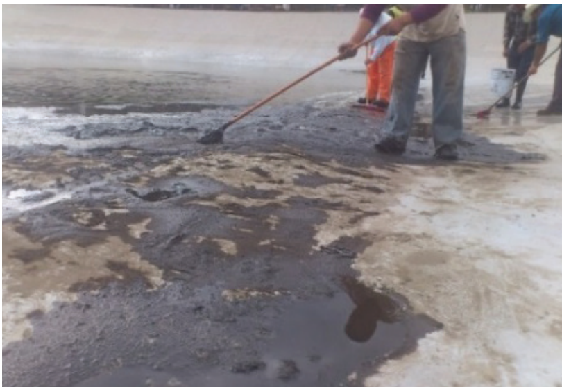
Figura 34. Retiro manual de los charcos o residuos sedimentados.
