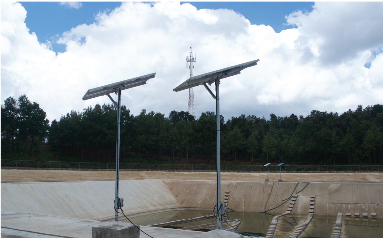
Figura 40. Mantenimiento de los paneles fotovoltaicos.
