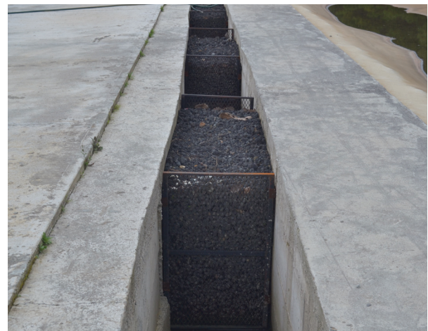
b) Canal sedimentador.
