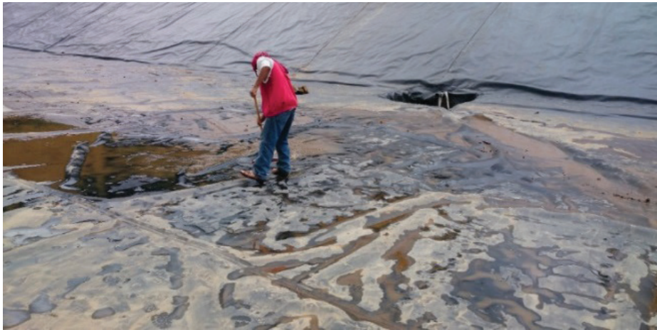
Figura 35. Retiro del sedimento adherido a la geomembrana.
