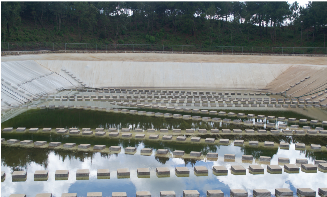
Figura 4. Línea de flotadores y canal de conducción de agua de lluvia.
