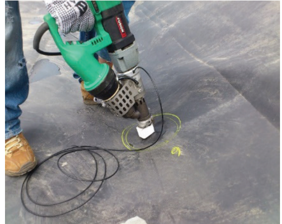
b) Reparación de daños a la geomembrana.
