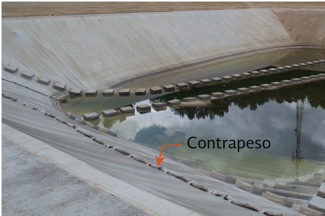
Figura 5. Contrapesos para la formación del canal de conducción de agua de lluvia en la cubierta flotante.
