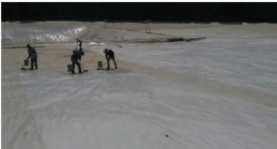
Figura 30. Limpieza del área de captación.
