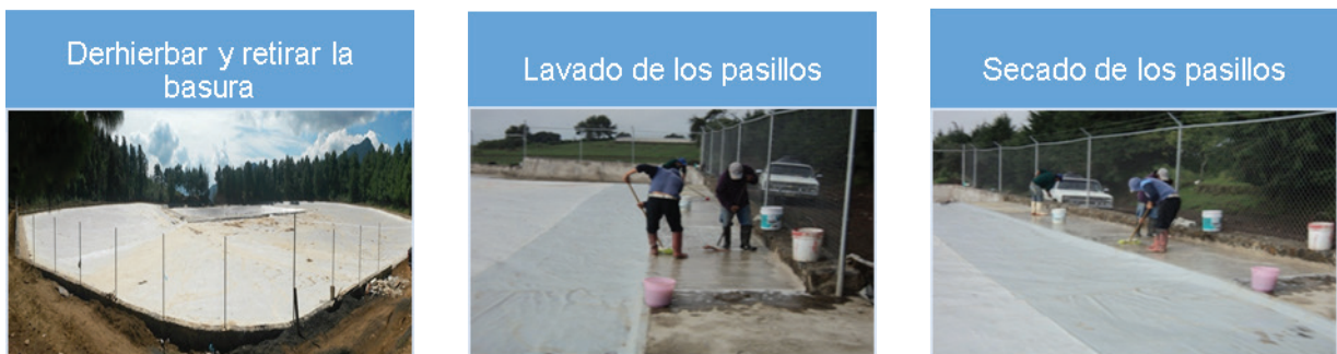
Figura 29. Limpieza de andadores.
