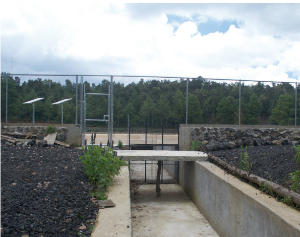
a) Canal de demasías.
