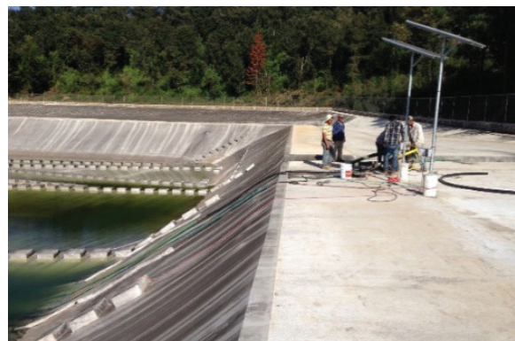
Figura 33. Bombeo y extracción del agua de la cubierta flotante
