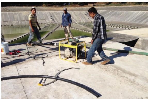
Figura 33. Bombeo y extracción del agua de la cubierta flotante
