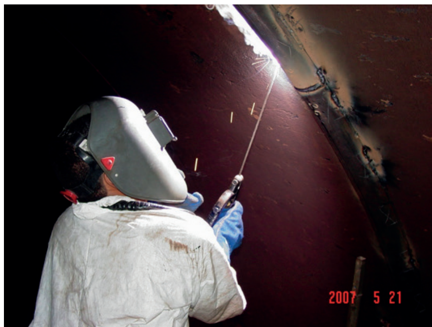
Figura 2.29 Aplicación de material de aporte. Soldaduras para fijar elemento circunferencial de sujeción.
