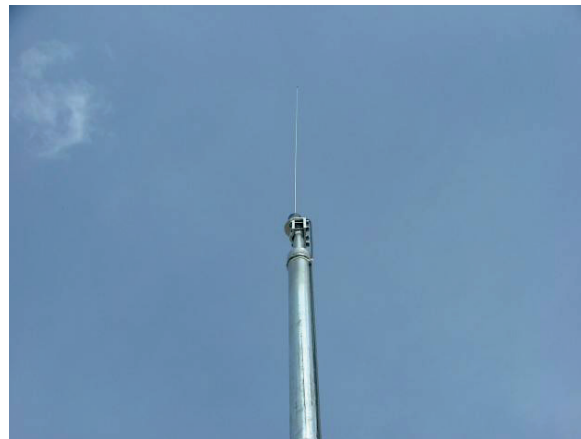
Figura 3.24 Vista de antena satelital.
