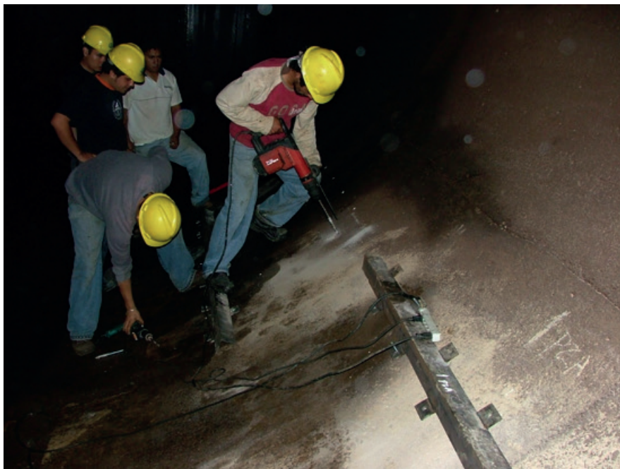
Figura 2.35 Perforación de barrenos para la fijación de elementos de sujeción en concreto.
