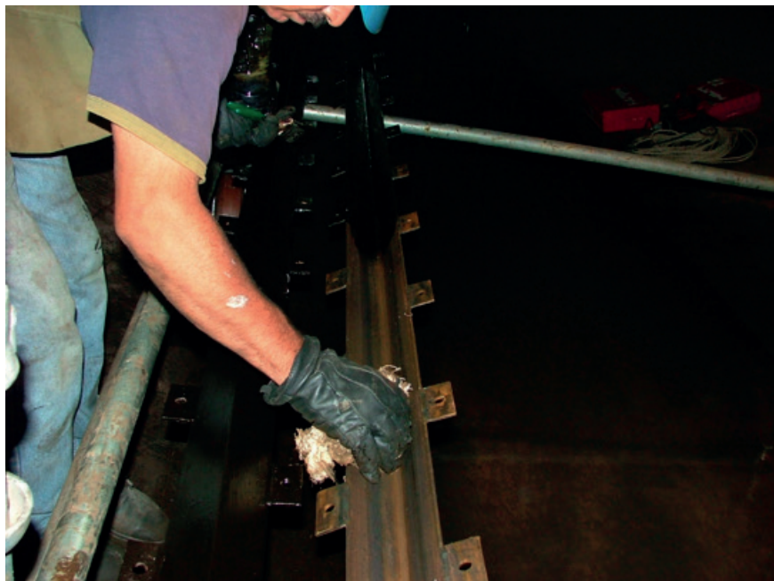
Figura 2.40 Limpieza con desengrasante antes de la aplicación del epóxico.
