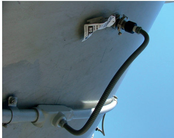
Figura 3.47 Vista de los sensores de inserción.
