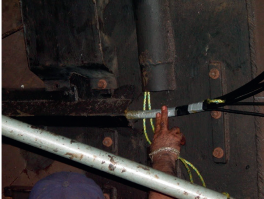
Figura 2.53 Desarrollo del trabajo de cableado.
