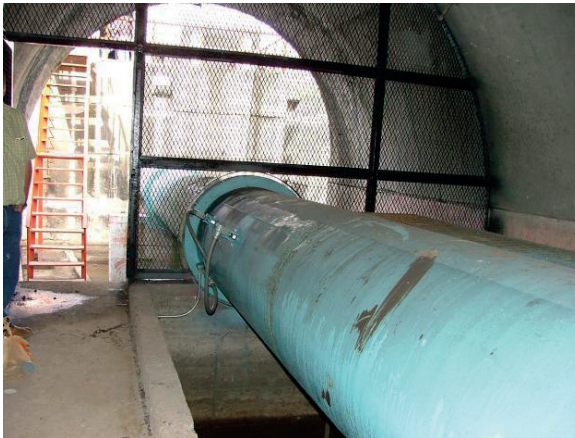
Figura 3.27 Vista hacia aguas abajo.
