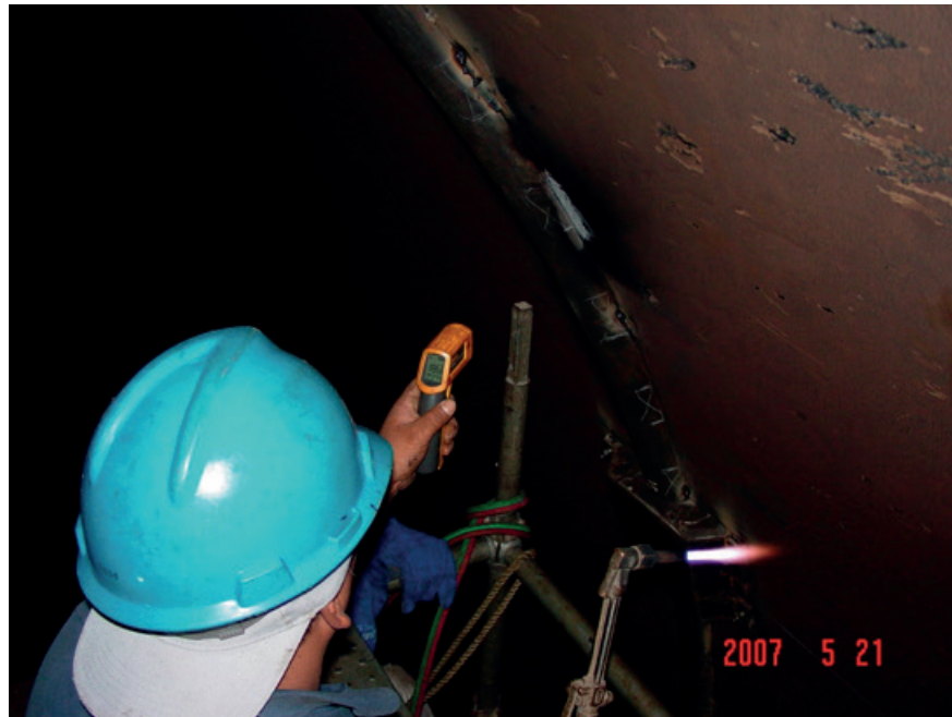
Figura 2.28 Medición de temperatura adecuada de precalentamiento.
