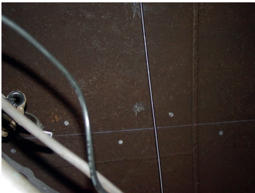
Figura 2.31 Material base preparado para colocación de pernos autosoldables.
