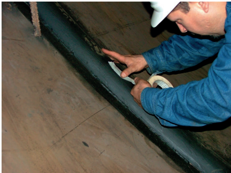
Figura 2.46 Después del rayado de la superficie se procede a adherir una cinta especial para esta prueba.
