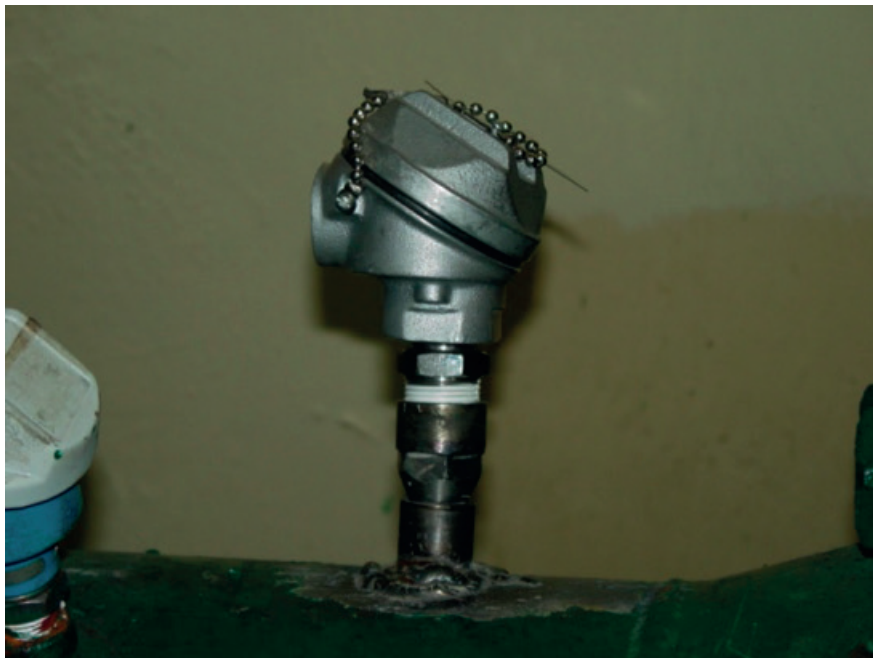
Figura 2.69 Termopar tipo J instalado.
