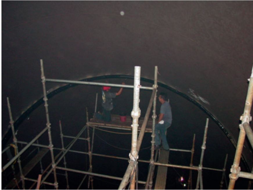
Figura 2.41 Aplicación de la protección anticorrosiva en el anillo colector de cables.
