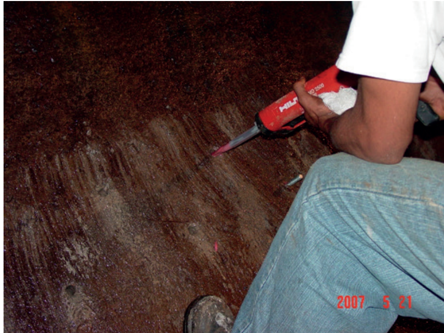
Figura 2.36 Aplicación de anclaje químico para fijar pernos.
