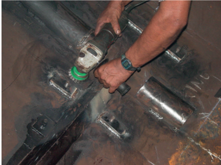
Figura 2.39 Limpieza mecánica anterior a la aplicación de protección anticorrosiva.
