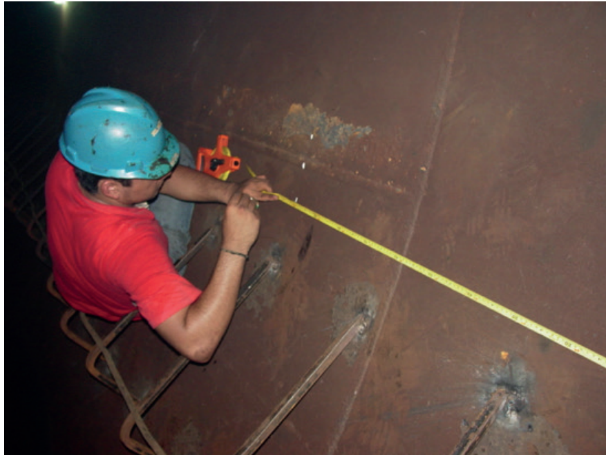
Figura 2.16 Se establece una referencia en plano y de ahí se parte para determinar el Centro del Sistema.
