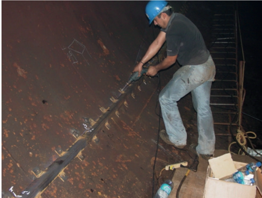
Figura 2.30 Limpieza mecánica del material base para colocar pernos autosoldables.
