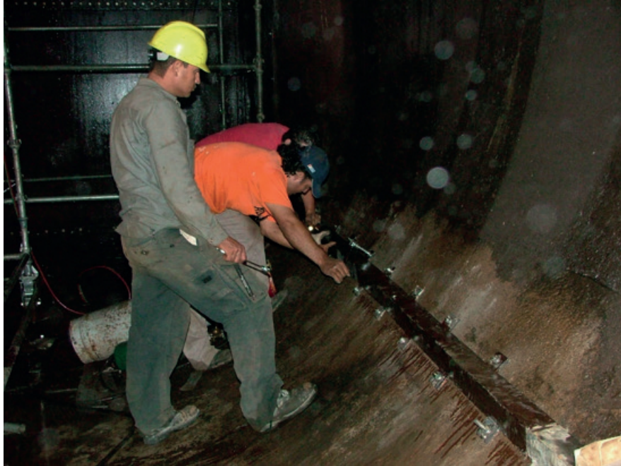
Figura 2.38 Colocación de elemento de sujeción (ángulo) en concreto.
