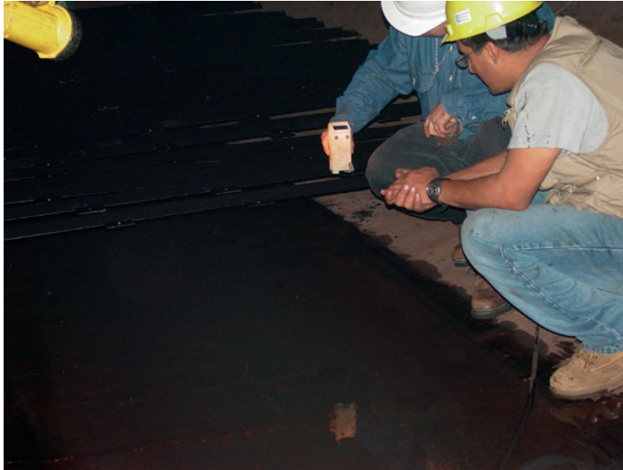
Figura 2.43 Medición de espesores del recubrimiento en los elementos.
