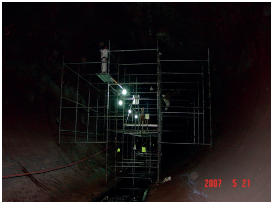
Figura 2.21 Andamio terminado y colocado.
