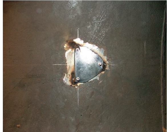
Figura 3.34 Colocación de la placa base para asentar sensor de velocidad.
