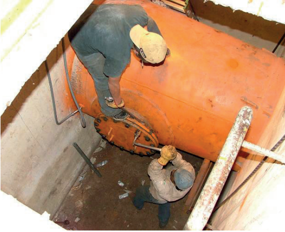
Figura 3.41 Colocación de la escotilla.
