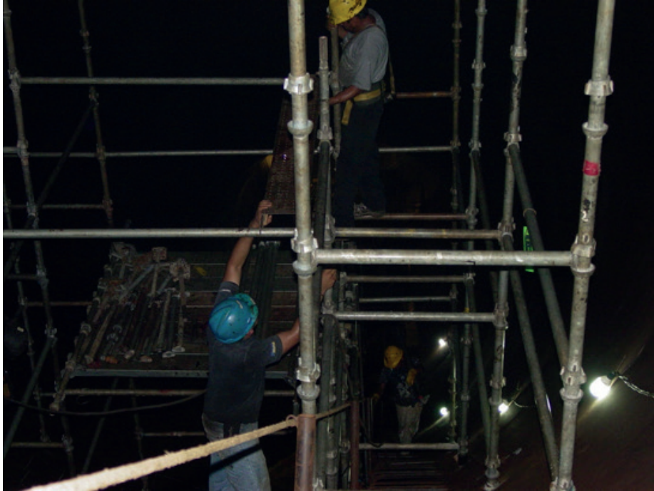
Figura 2.21 Andamio terminado y colocado.
