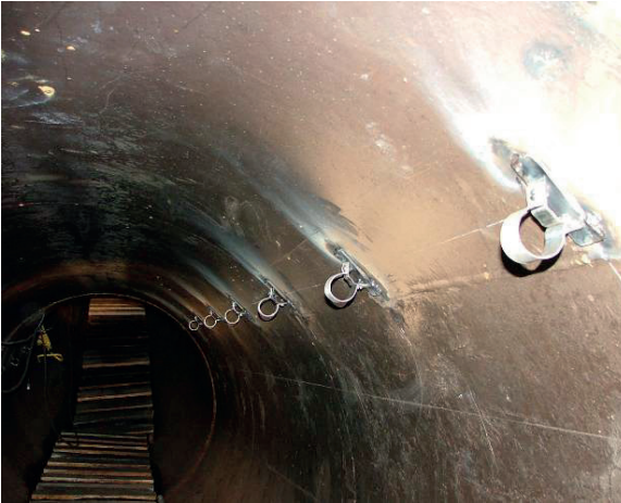
Figura 3.33 Instalación de abrazaderas en el interior de la tubería.
