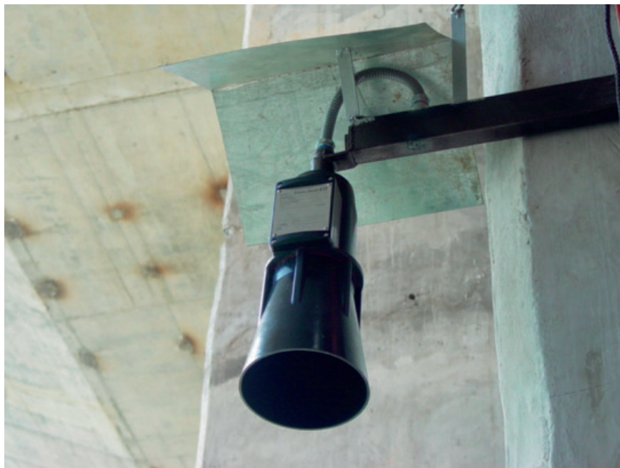
Figura 2.71 Sensor de nivel tipo ultrasónico para determinar la elevación del espejo de agua del embalse.
