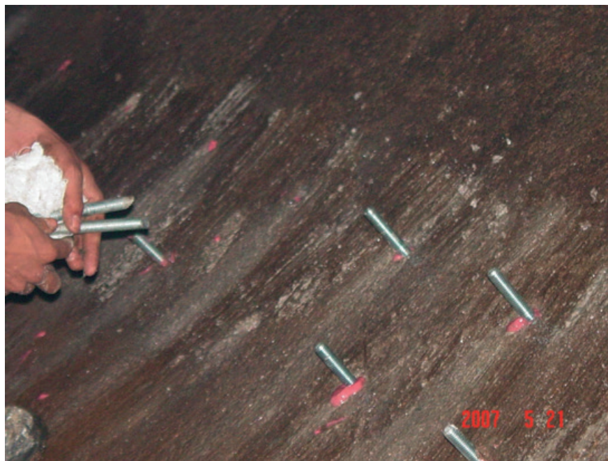
Figura 2.37 Colocación de pernos.
