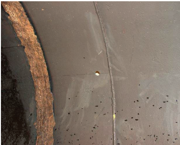
Figura 3.31 Perforación de la tubería para la salida de los cables de sensores.
