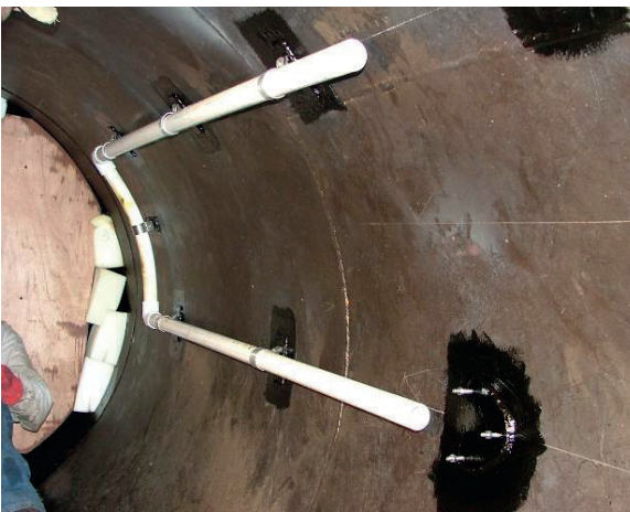
Figura 3.35 Tubería de PVC para alojar cables de sensores.
