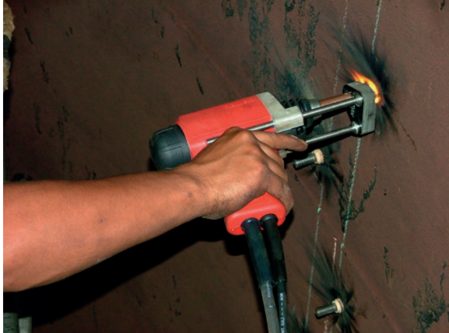
Figura 2.32 Colocación de pernos autosoldables.
