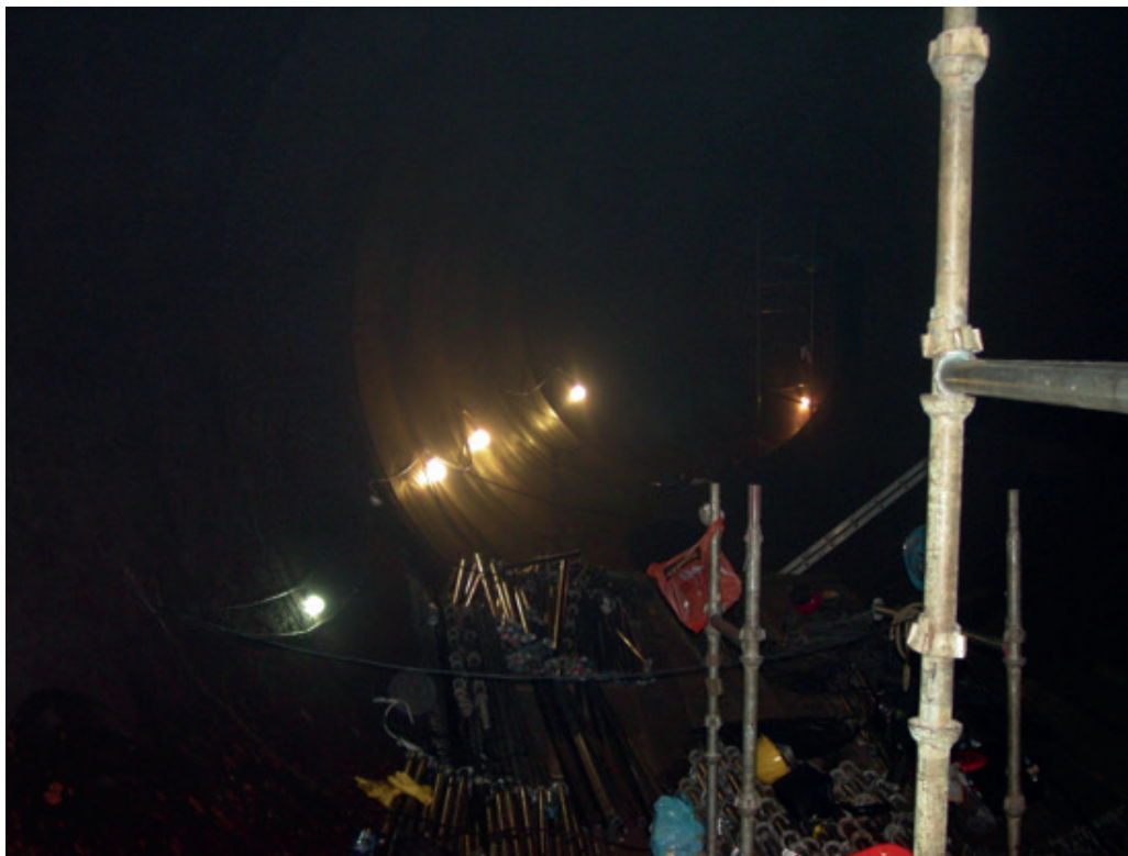
Figura 2.19 Piezas de andamio sin armar.
