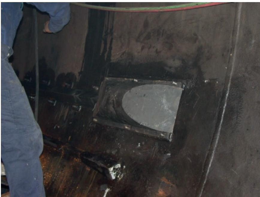
Figura 2.64 Registro colocado al interior del conducto para evitar que el flujo golpee directamente al dispositivo.
