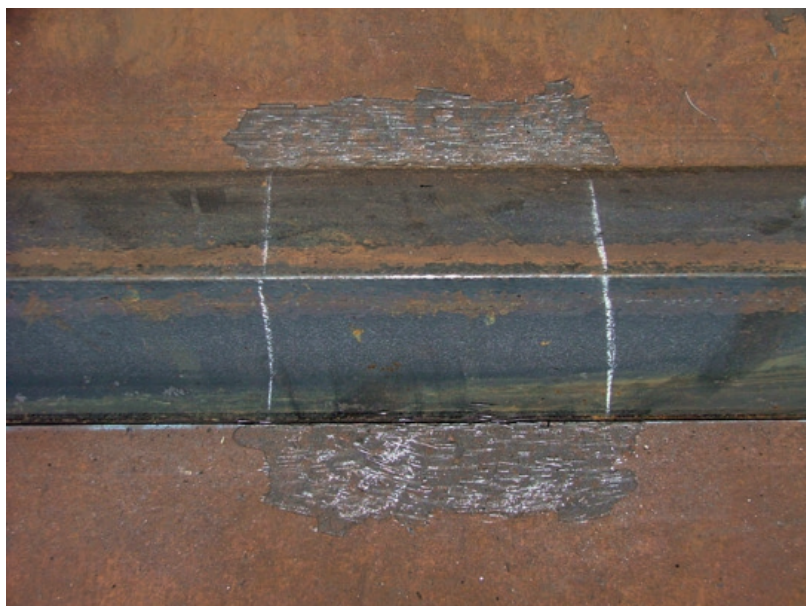
Figura 2.25 Remoción de recubrimiento epóxico como limpieza previa a la aplicación de material de aporte.
