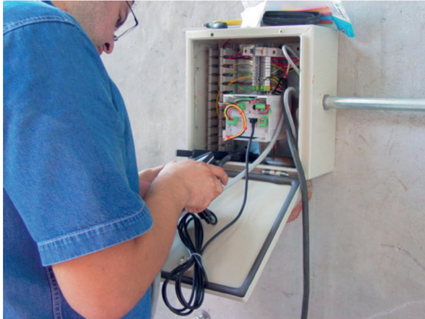
Figura 2.72 Sensor de nivel tipo ultrasónico para determinar la elevación del espejo de agua del embalse.
