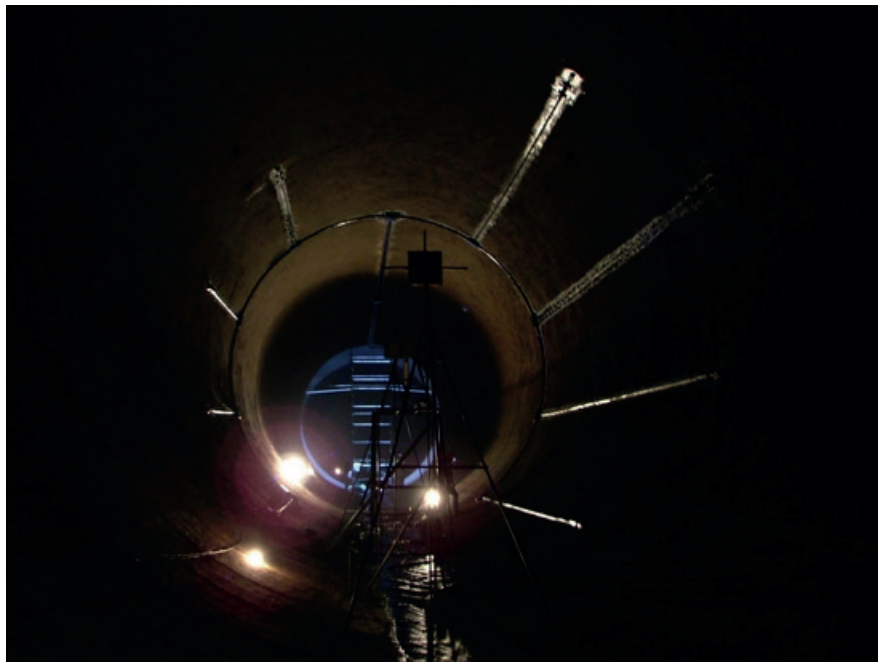
Figura 2.66 Sistema totalmente instalado en el interior de un conducto a presión.
