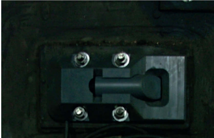
Figura 2.48 Sensor debidamente colocado.
