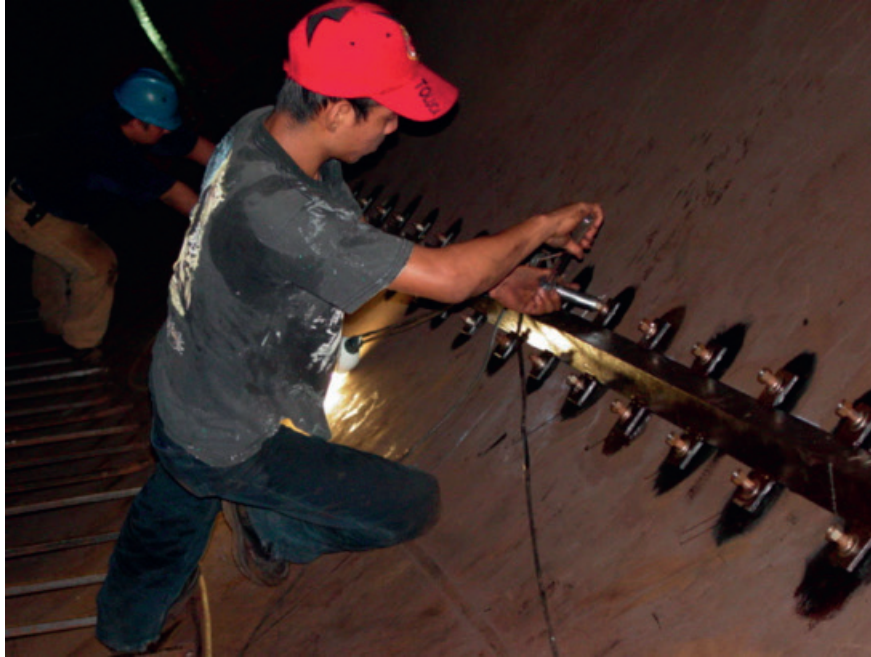
Figura 2.34 Elemento de sujeción fijado con pernos autosoldables.
