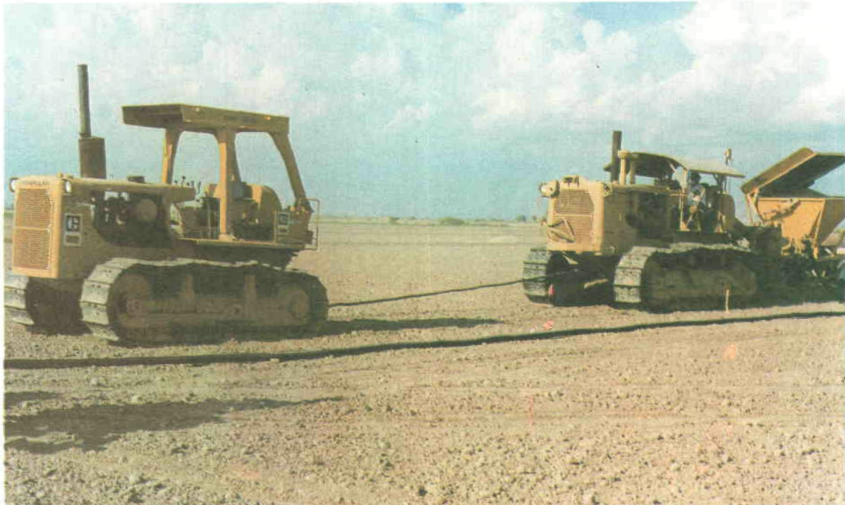
Foto 11. Uso de dos tractores durante la instalación del drenaje parcelario
