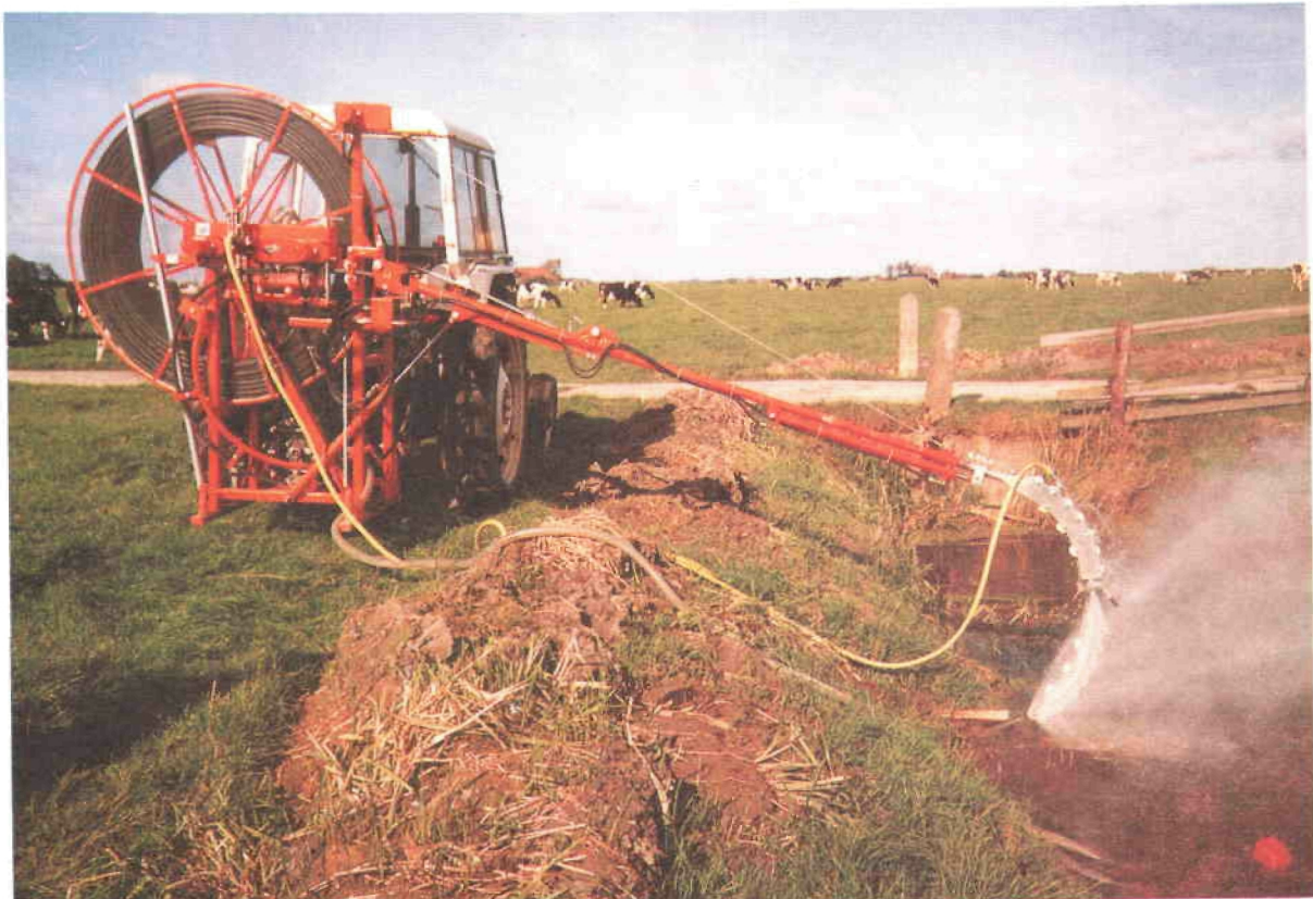
Foto 32. Equipo de inyección de agua a presión para limpieza de drenes entubados
