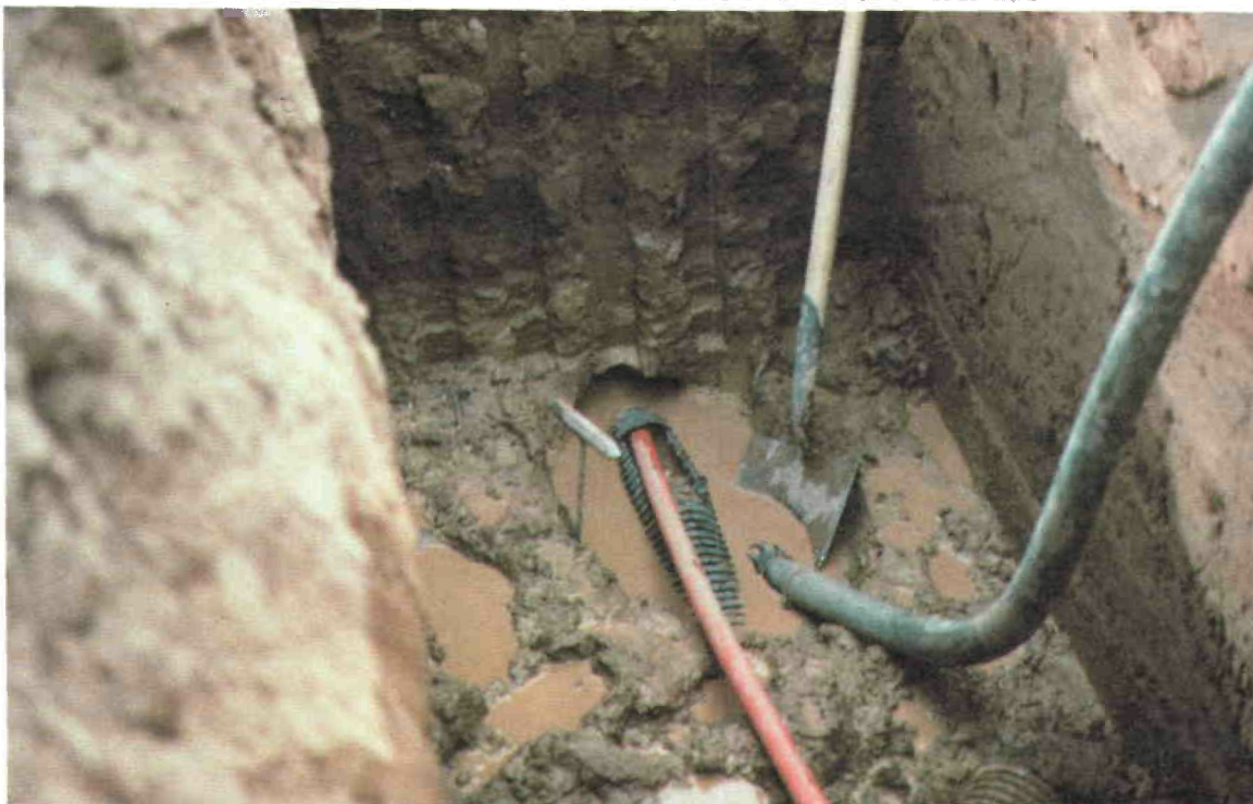
Foto 34. Fosa para limpieza con inyección de agua
