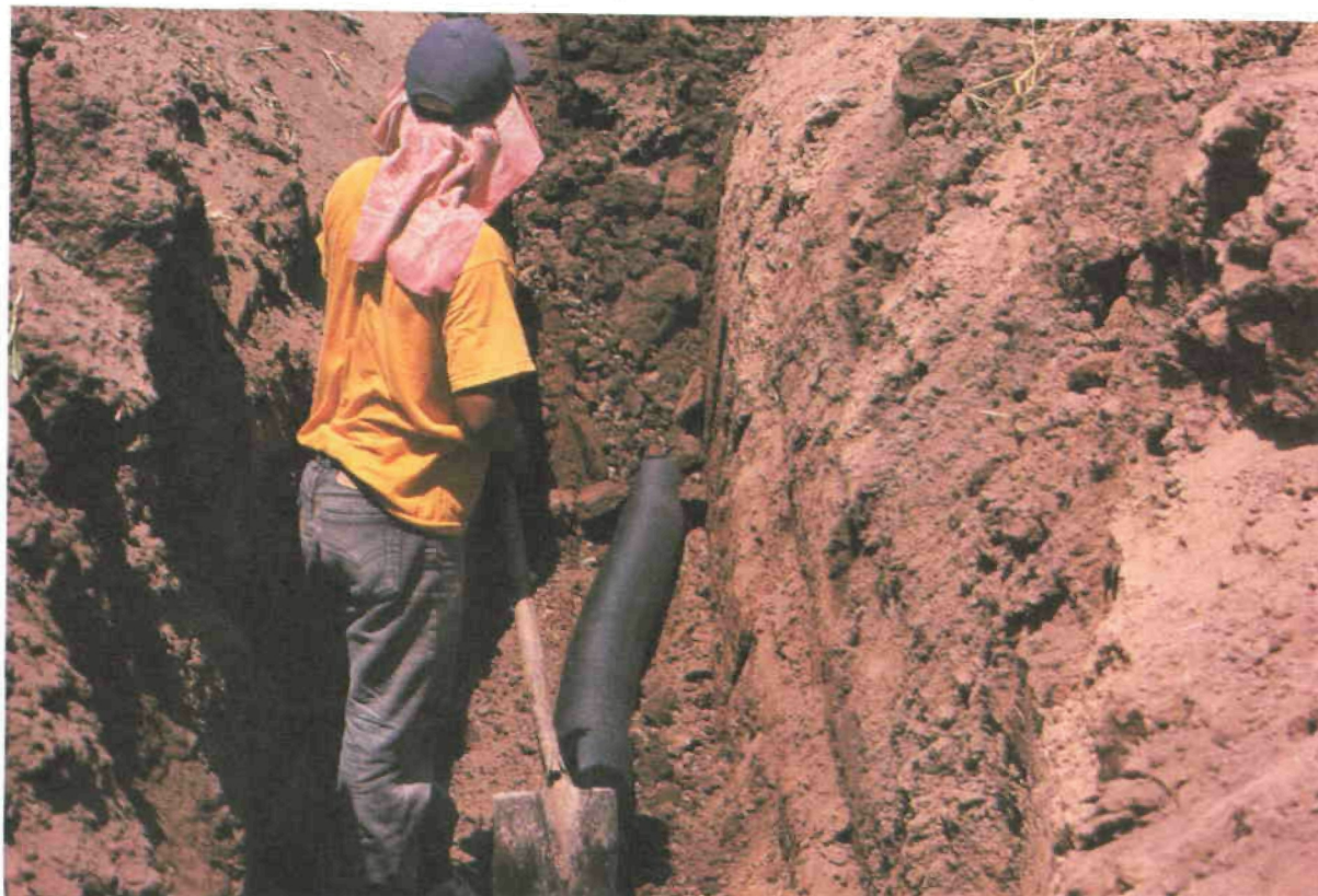
Foto 14. Zanja para conectar un lateral al colector
