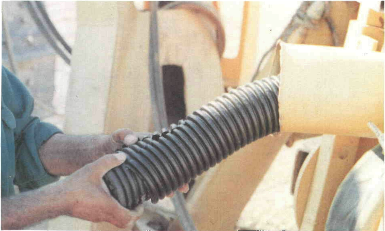
Foto 16. Colocación del tapón al final de un lateral
