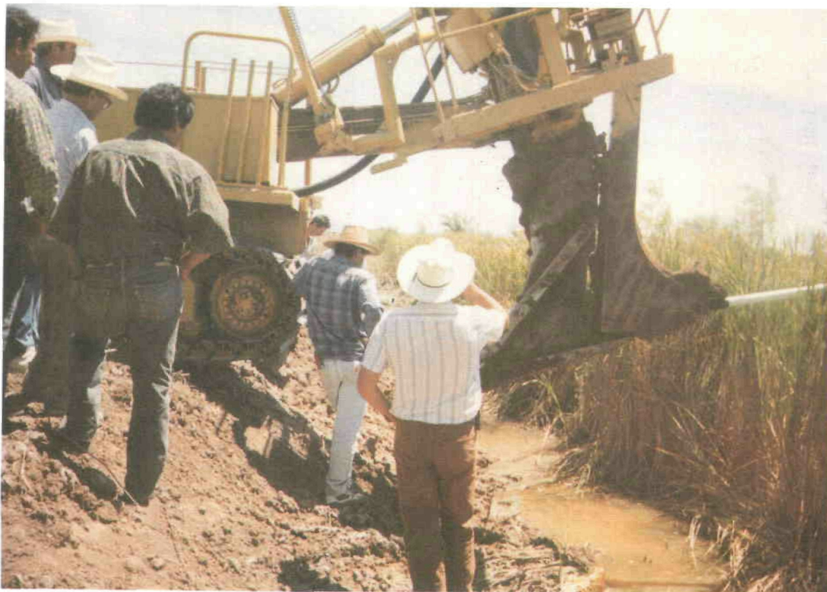
Foto 13. Inicio de la instalación de un colector
