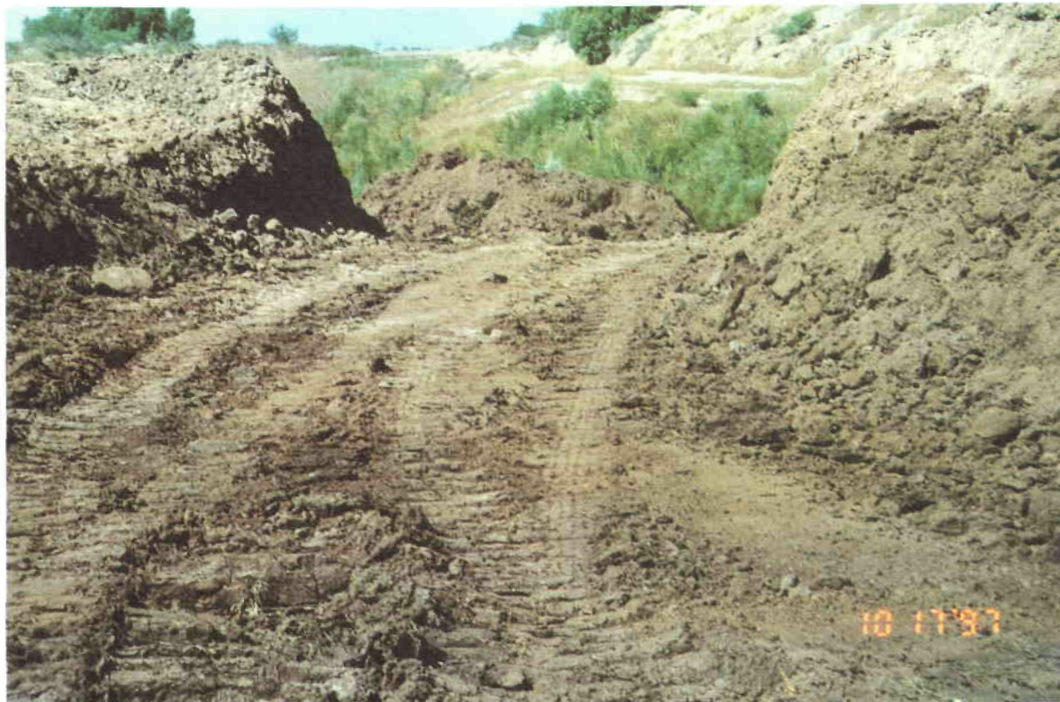
Foto 12. Borrado de la berma de un dren a cielo abierto
