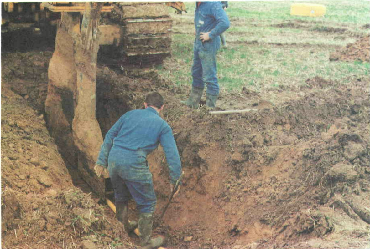
Foto 15. Zanjadora iniciando la instalación de un lateral
