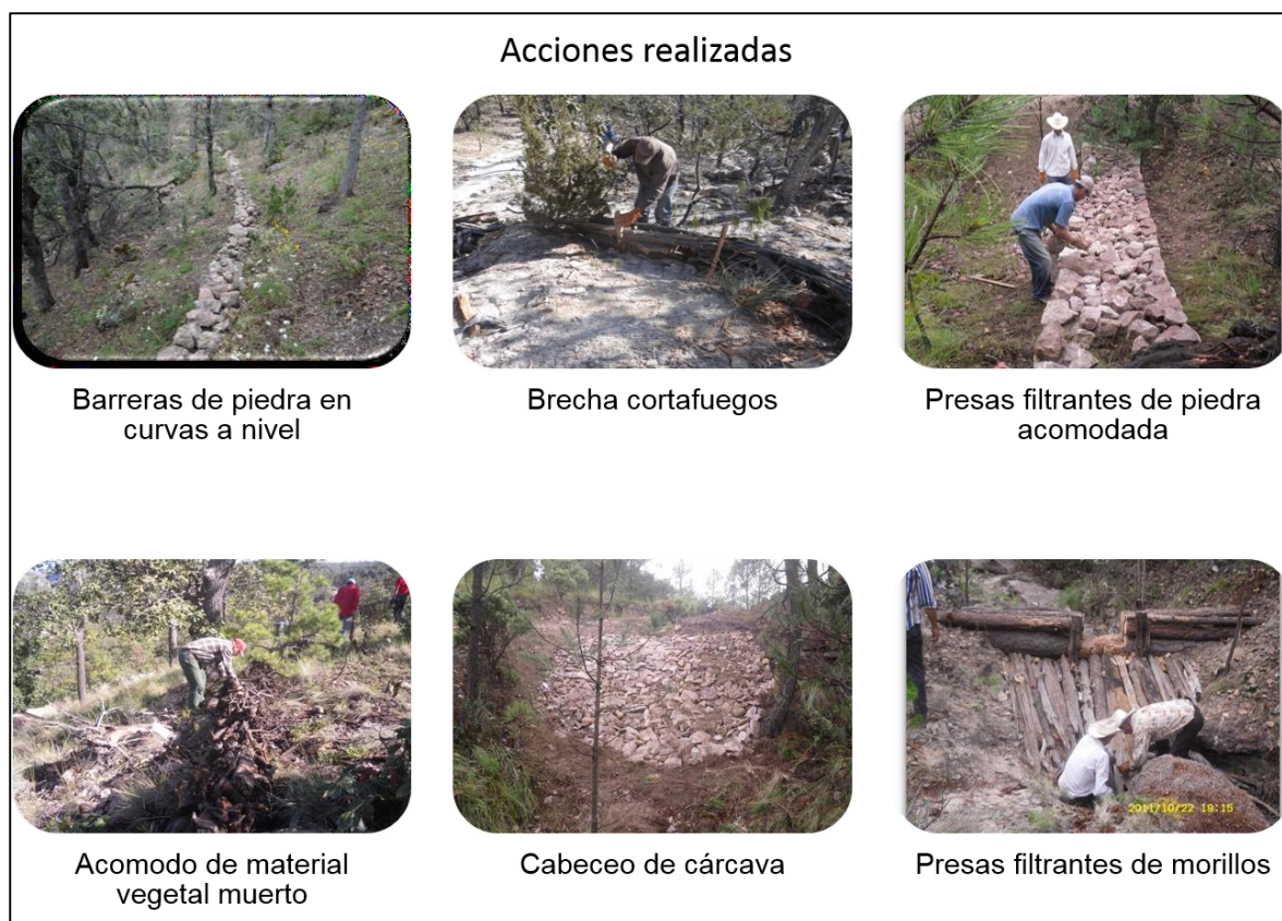
ILUSTRACIÓN 16. OBRAS DE CONSERVACIÓN EN LA CUENCA ALTA DEL NAZAS 33
