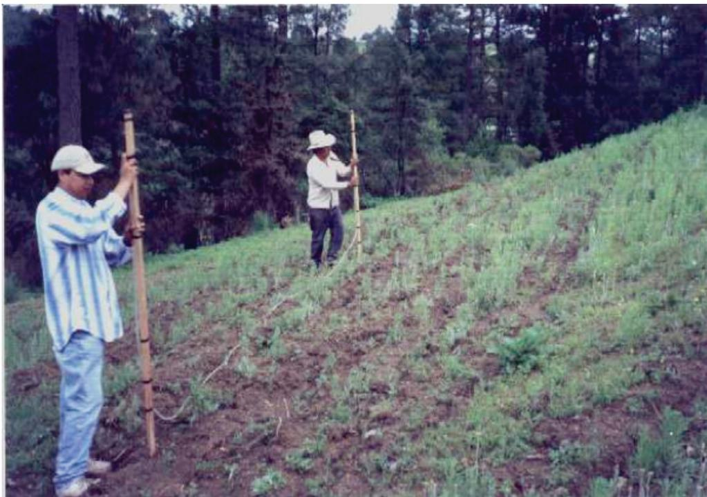
Fotografía 5. Marcando curva de nivel con nivel de manguera.
