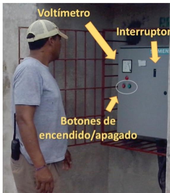
**Ilustración 19. Verificación del voltímetro a 440 voltios.**
