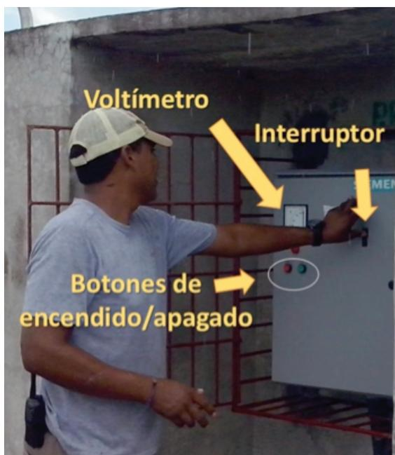
**Ilustración 18. Encendido del interruptor.**
