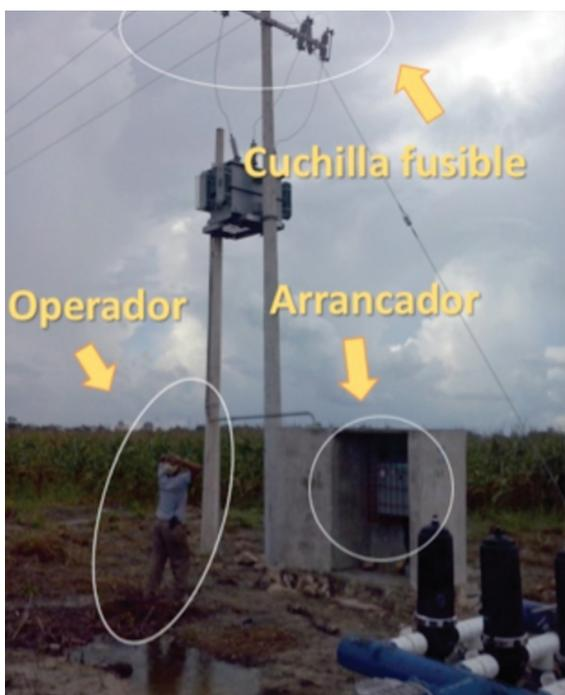
**Ilustración 20. Verificación de cuchillas fusible.**
