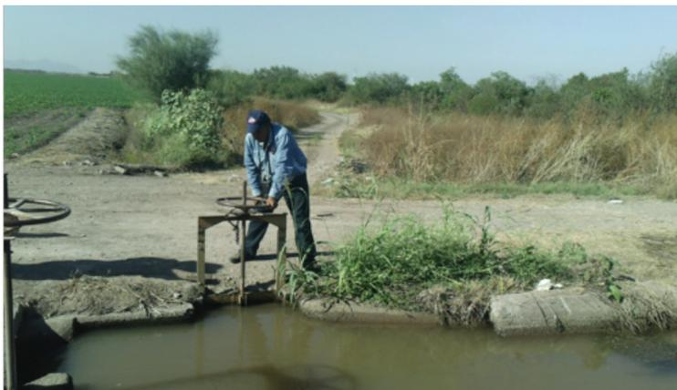
**Ilustración 26. Abertura de la compuerta de acceso al cárcamo de bombeo.**
