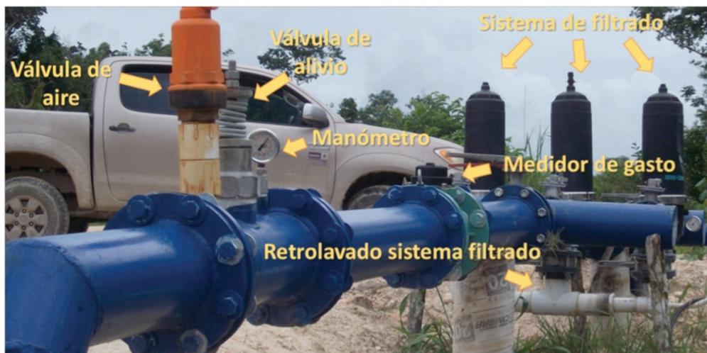
Ilustración 25. Dispositivos de medición y filtros.
