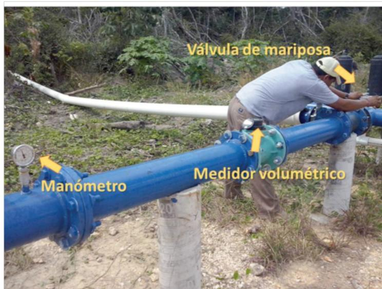
Ilustración 28. Ajuste de la presión de operación del sistema de riego.
