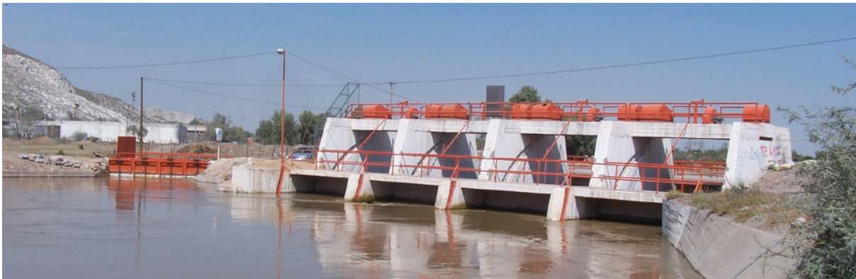
Figura 62. Derivadora San Fernando en funcionamiento. Las compuertas de la izquierda alimentan el canal Santa Rosa-Tlahualilo, y las compuertas de la derecha son la entrada del canal Sacramento.
