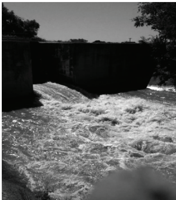
Figura 100. Desfogue parcial en funcionamiento, descargando excedentes del canal 3.18.97 al dren Guadalupe.
