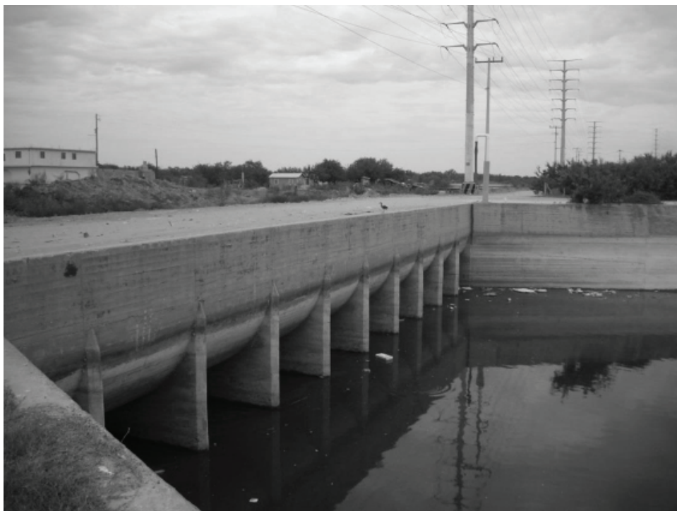
Figura 96. Entrada del sifón invertido Km 13+779 canal Anzaldúas, de 250 m 3 /s de capacidad y 64 m de longitud para cruzar bajo el dren-arroyo El Anhelito. DR 025 Bajo Río Bravo, Tam.
