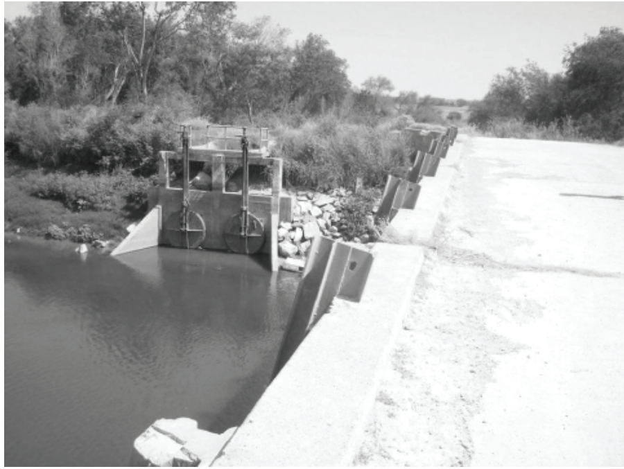
Figura 87. Toma-granja de compuerta rectangular para sustituir a las tipo Miller, con el fin de disminuir las filtraciones y fugas que pueden presentar estas últimas. Módulo de Riego III-4 del DR 025 Bajo Río Bravo, Tam.
