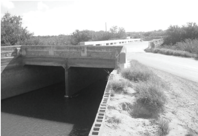
Figura 93. Puente canal vehicular del Km 6+700 del canal Rode, con dos cajones o ductos para 60.0 \text{ m}^3/\text{s} de capacidad, para cruzar el arroyo San Pedro y uso vehicular de la carretera Comales-Camargo. DR 026 Bajo Río San Juan, Tam.
