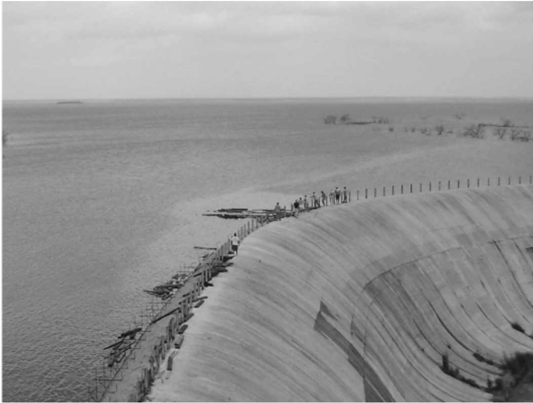
Figura 65. Colocación de agujas de madera para sobreelevar el vertedor semicircular tipo Creager de cresta libre. Presa Marte R. Gómez, DR 026 Bajo Río San Juan, Tam., durante la avenida causada por el huracán Alex, julio de 2010. Cortesía del DR 026.
