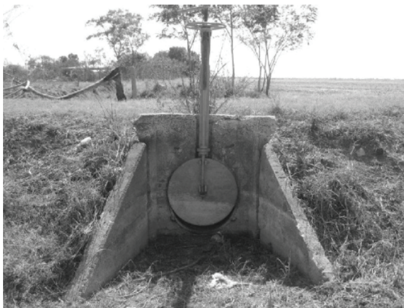
Figura 85. Toma-granja tipo Miller de compuerta circular de 18" de diámetro. Módulo II-2 del DR 025 Bajo Río Bravo, Tam.
