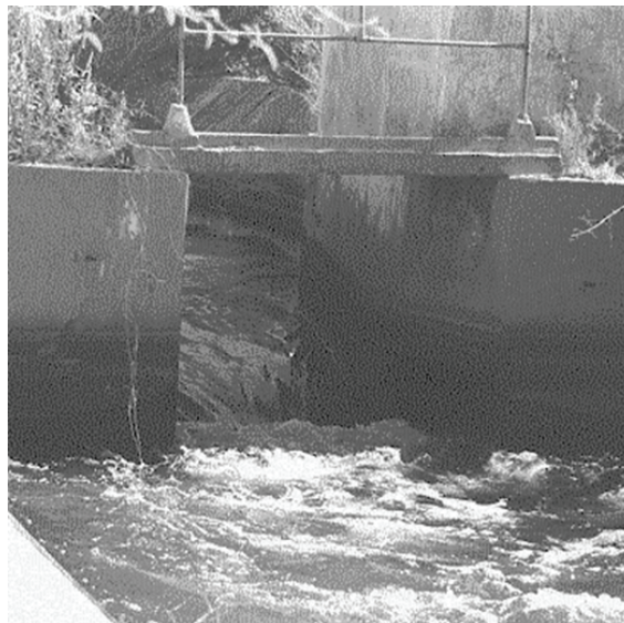
Figura 58. Aforador Parshall, aguas abajo de la presa Altar. Distrito de Riego 037 Altar-Pitiquito, Son.
