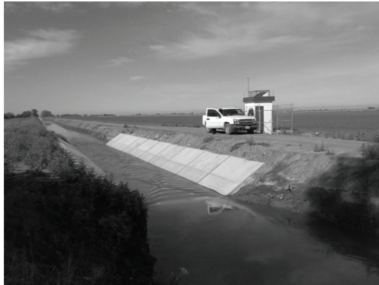
Figura 70. Canal de tierra con una sección de revestimiento, colocado para fines de hidrometría ultrasónica. DR 041 Río Yaqui, Son.
