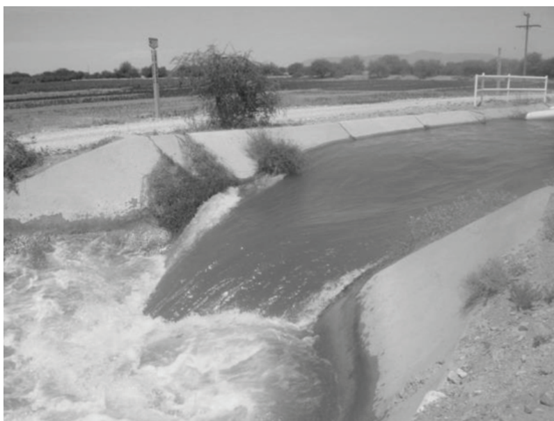
Figura 97. Rápida en el canal 24+060 del DR 017 Región Lagunera Coah-Dgo.
