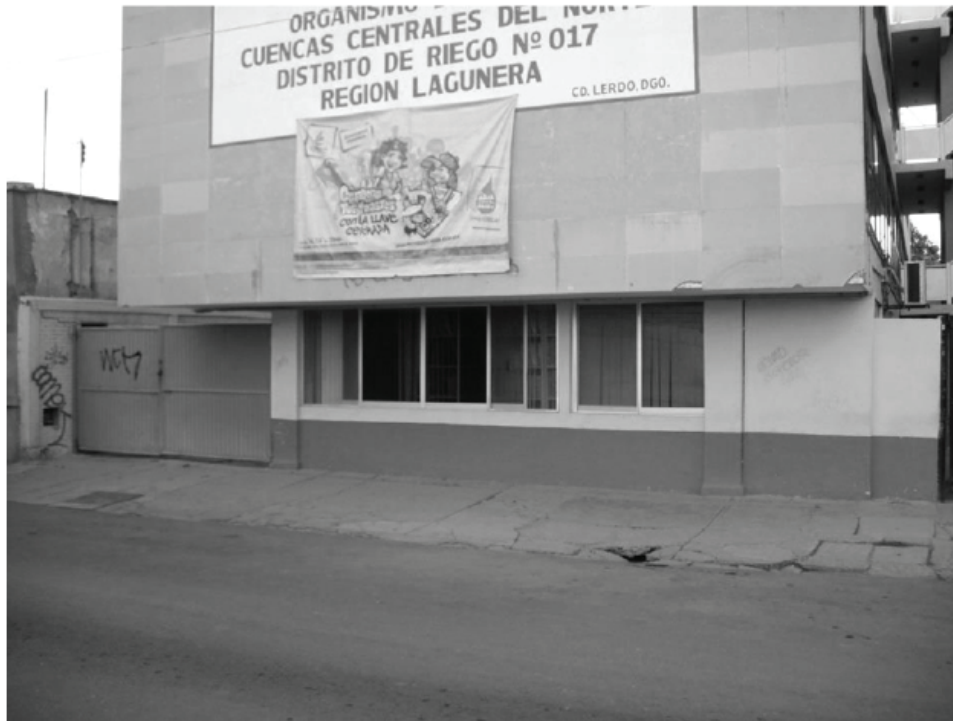
Figura 101. Oficinas de la sede del DR 017 Región Lagunera Coah-Dgo., sita en calle Francisco I. Madero y López Rayón, en Cd. Lerdo, Dgo.
