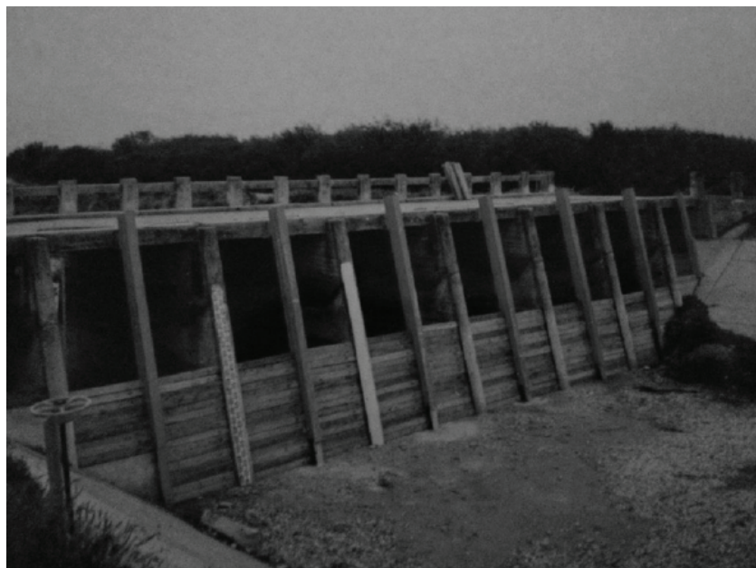
Figura 73. Represa de agujas de madera con sección 3"x 6"x 6 pies (0.75m x 0.15m x 1.80 m) con diez claros de veinte agujas, cada uno y dos de diez agujas para un total de 220 piezas y capacidad de 25 m 3 /s. Represa actualmente sustituida por una represa de compuertas radiales, Km 121+440, canal Rode. Cortesía DR 026 Bajo Río San Juan, Tam.
