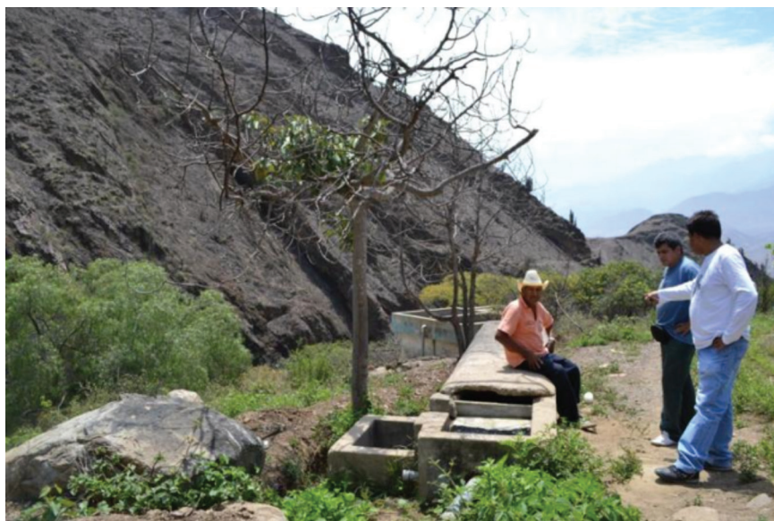
Figura 1-2: Visita del personal de Water for People – Perú a una planta potabilizadora de filtración lenta en arena en abandono en el caserío de Jolluco de Cascas.
