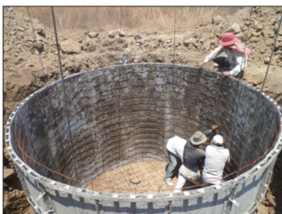
Foto 8. Colocación y amarre de malla de piso y muro
