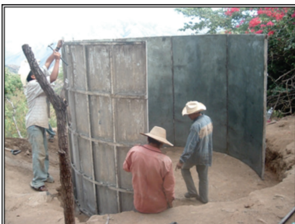
Foto 7. Armado de molde exterior
