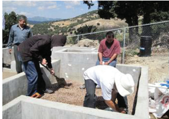
Fotos 1 y 2: Descarga, acarreo y colocación de gravas y arenas en filtros
