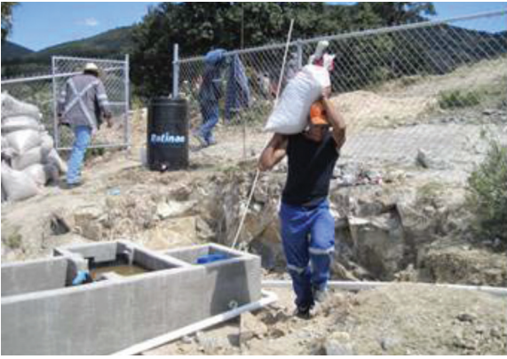
Fotos 1 y 2: Descarga, acarreo y colocación de gravas y arenas en filtros
