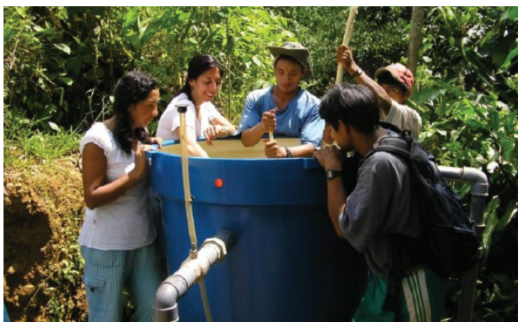
Figura 4-10: Limpieza de un filtro lento prefabricado instalado en la zona de Manu en Perú con el procedimiento de rastrillado (Blackburn & Stellema, 2011).
