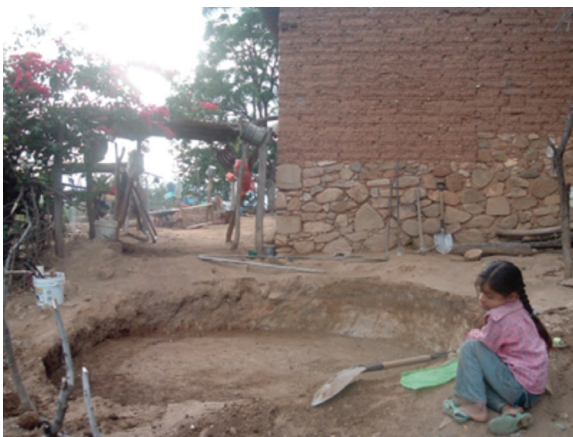
Foto 6. Ubicación del lugar de construcción
