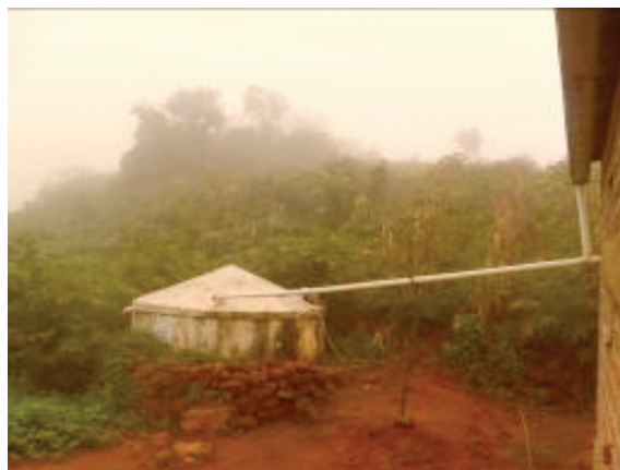
Figura 3. Cisterna del P1MC en el municipio de Santa Cruz da Baixa Verde, PE. Out. 2013
