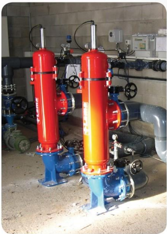
Figura 55 Filtro auto limpiante de malla hidráulico EKO
