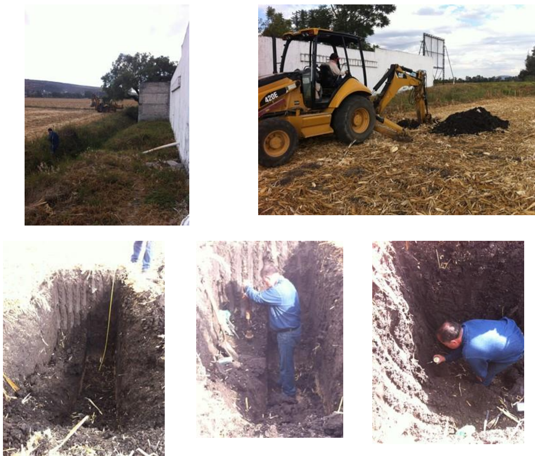
Figura 46 Pozo a cielo abierto realizado en el Pozo 2.
