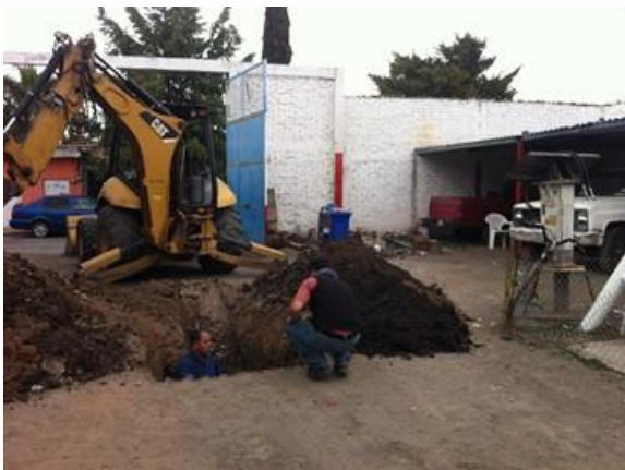
Figura 35 Pozo a cielo abierto realizado en el Pozo 1.
