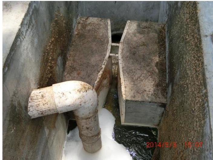
Foto 5.23 Medidor Parshall.
