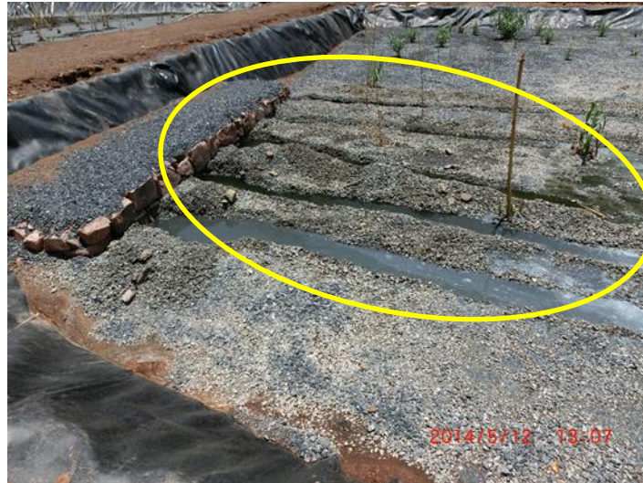
Foto 5.11 Presencia de canales superficiales sobre los humedales de tratamiento.
