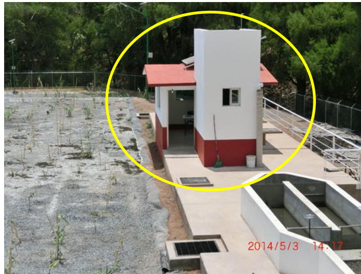
Foto 5.5 Caseta de vigilancia construida sobre el digestor.
