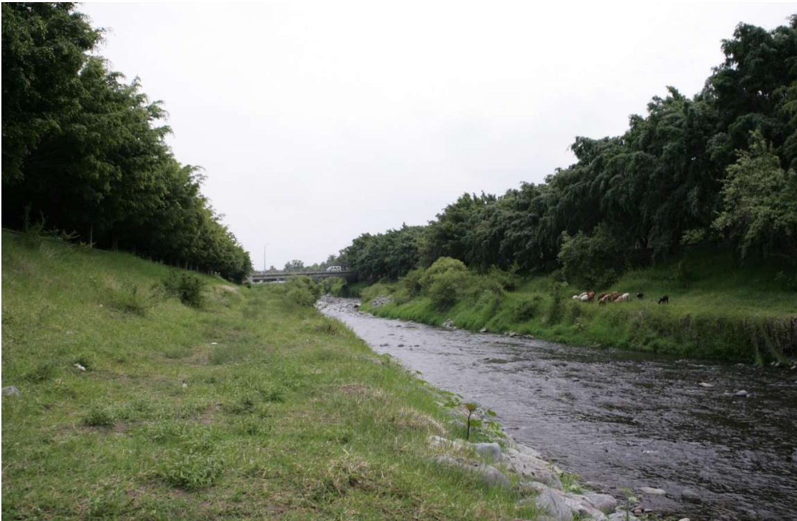
Foto 3.22 Estación Puente Carlos Pacheco aguas arriba subcuenca río Cuautla.
