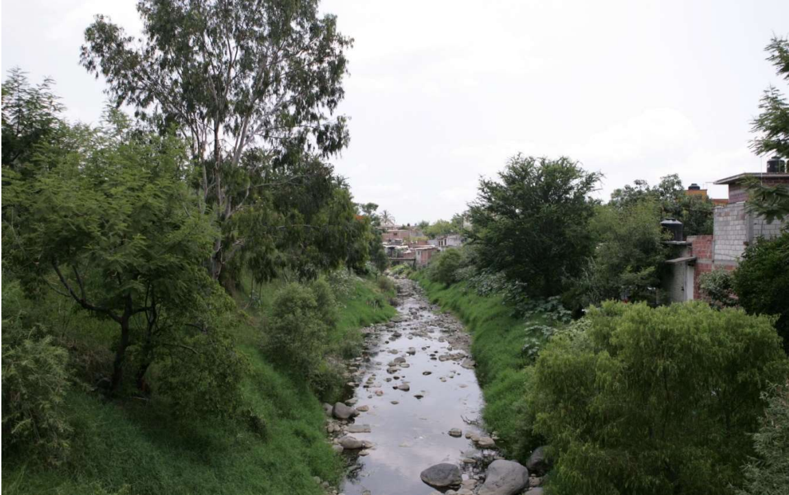
Foto 3.29 Estación Santa Cruz aguas abajo subcuenca río Cuautla.
