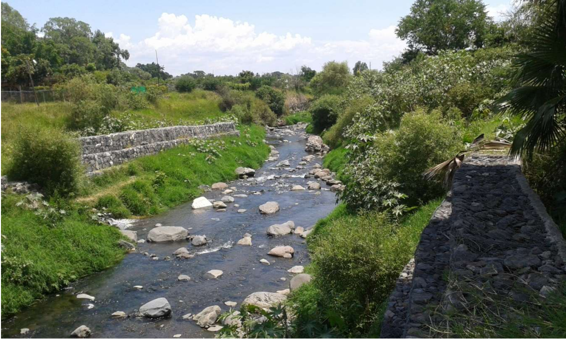
Foto 3.15 Estación Bomba de Agua aguas abajo subcuena río Cuautla.
