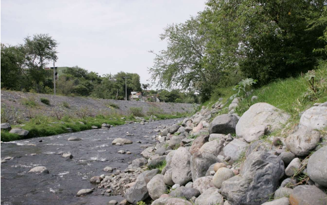
Foto 3.19 Estación Col. Pablo Torres Burgos aguas abajo subcuenca río Cuautla.
