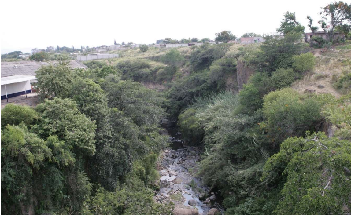
Foto 3.33 Estación La Vía aguas abajo subcuena río Cuautla.
