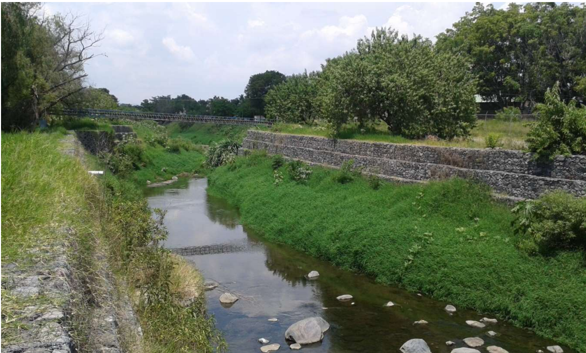
Foto 3.14 Estación Bomba de Agua aguas arriba subcuenca río Cuautla.
