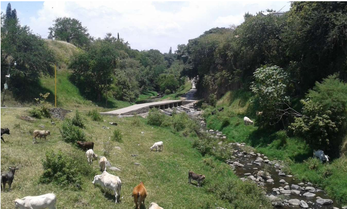
Foto 3.10 Estación Puente Paraíso aguas arriba subcuenca río Cuautla.
