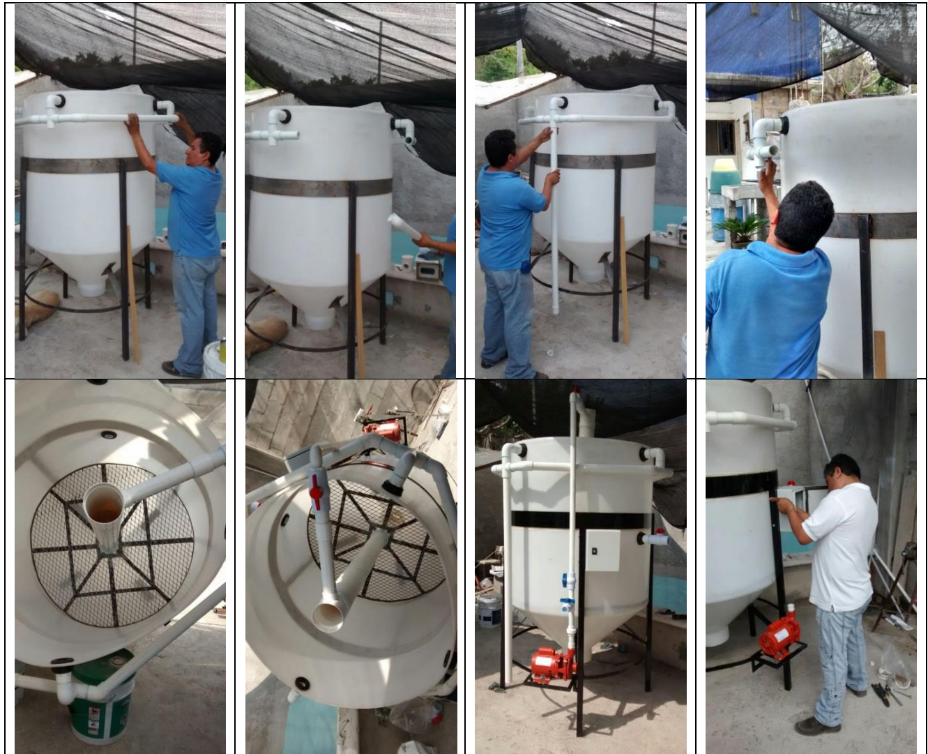
Figura 3.127 Armado tuberías.
