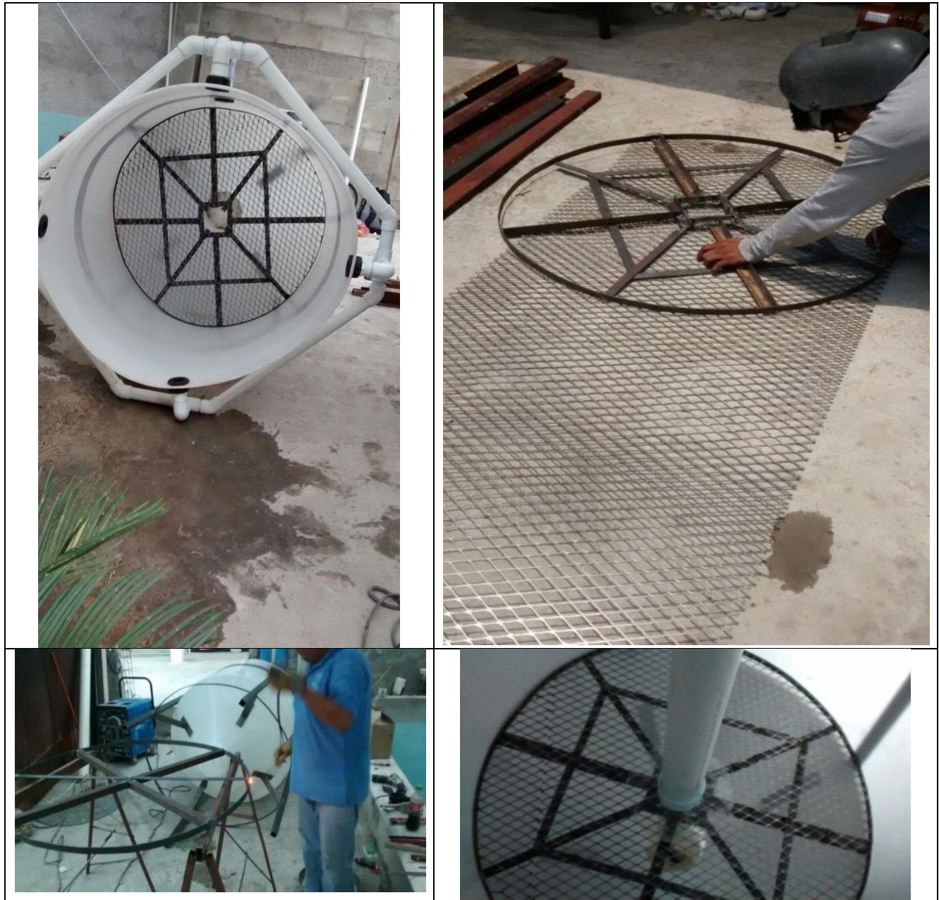
Figura 3.126 Armado estructura interna.
