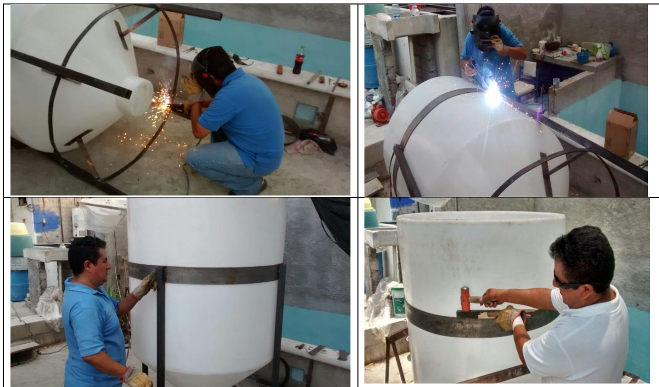
Figura 3.125 Armado de la estructura de soporte.
