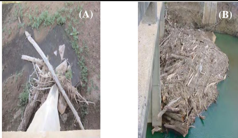
Figura 20. (A) Acumulación en una sola pila, (B) Acumulación entre claros. Fuente: (Lagasse et al. , 2010).
