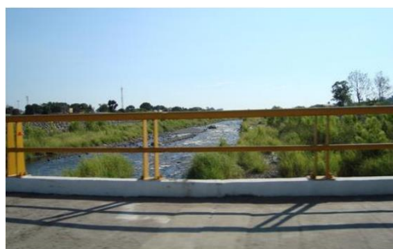
Figura 6. Cauce antes de la llegada del huracán Stan. Fuente: (Aguado Sandoval, 2012).
