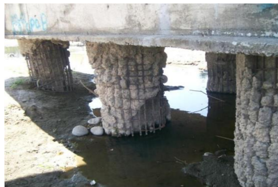
Figura 5. Exposición de la cimentación. Fuente: (Aguado Sandoval, 2012).
