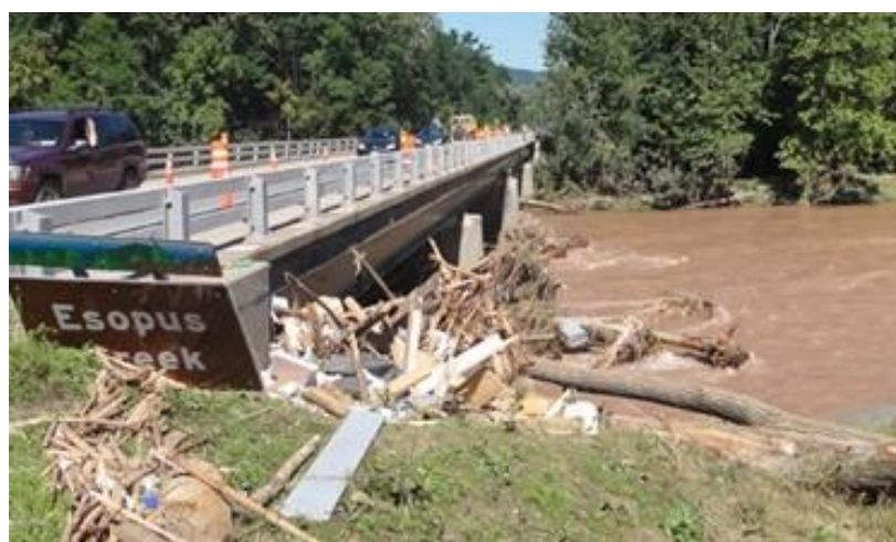
Figura 19. Acumulación de material en un puente. Fuente: (Conservation Department of Environmental, s.f.).
