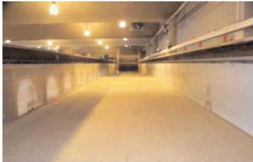
Figura 31. Canal de la Universidad de Colorado antes de la instalación de las pilas. Fuente: Lagasse et al. , (2010).
