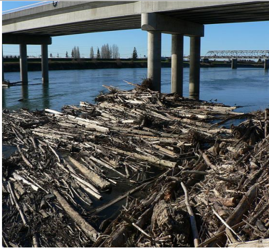
Cauce natural con acumulación de material leñoso en pilas de puente. Fuente: (Wikipedia, 2017)
