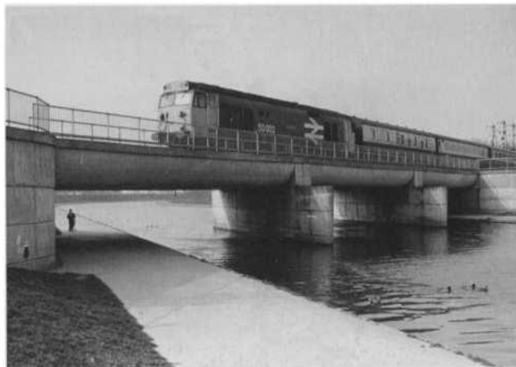
Figura 1. Puente ferroviario de Exwick. Fuente: (Hamill, 1999).
