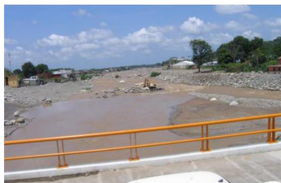
Figura 7. Cauce después del paso del huracán Stan. Fuente: (Aguado Sandoval, 2012).
