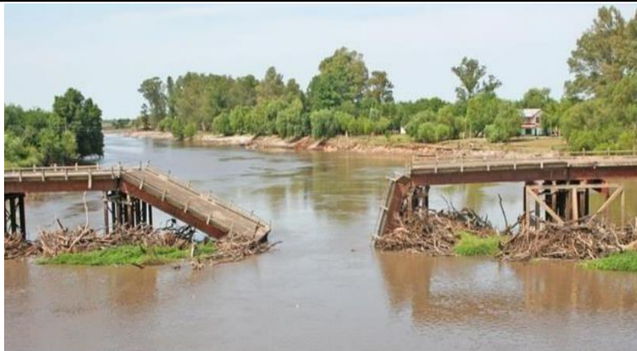
Figura 26. Puente Pellegrini colapsado en Gualeguay, Argentina. Fuente (El Día, 2013)
