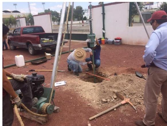
**Figura 4. Equipo de penetración estándar en operación en pozo 33 A**
