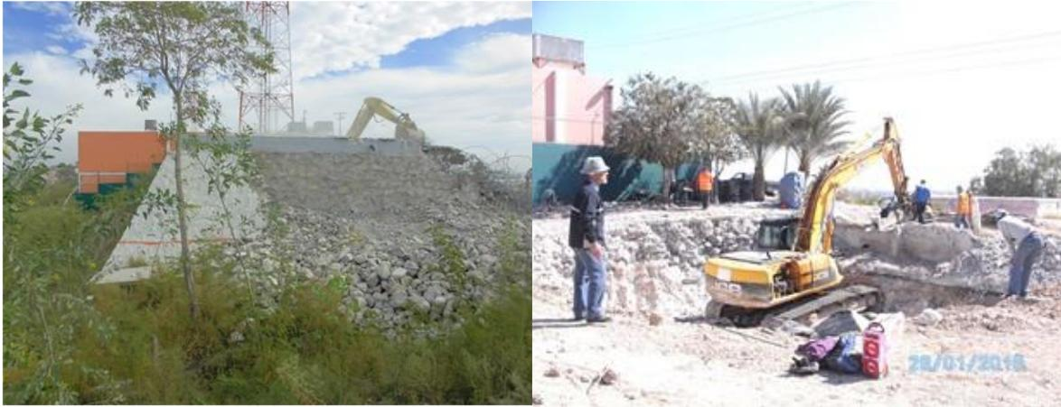
**Figura 11. Demolición de tanque viejo y excavación para tanque nuevo de almacenamiento**
