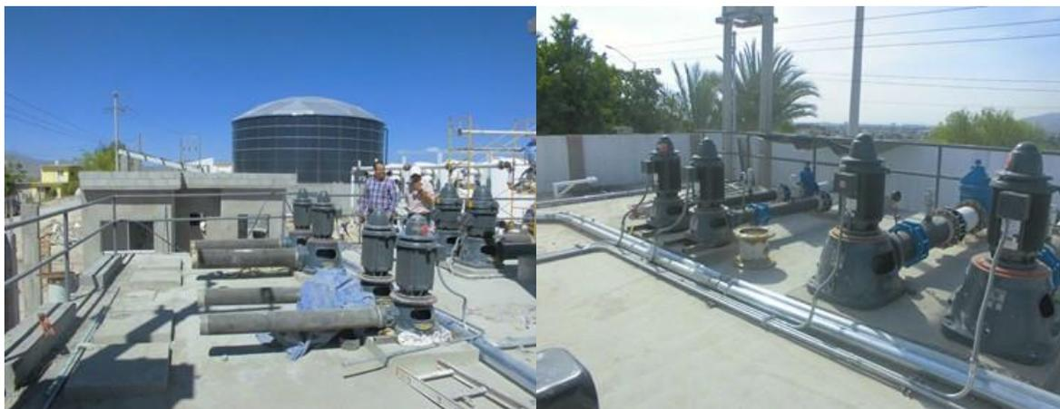
**Figura 18. Cárcamo de bombeo de agua filtrada y bombas de suministro a tanques y retrolavado**
