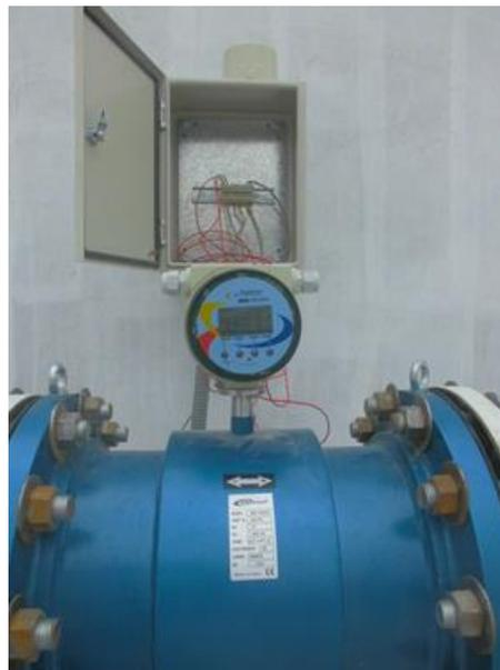
**Figura 24. Medidores de presión y caudal en agua cruda**
