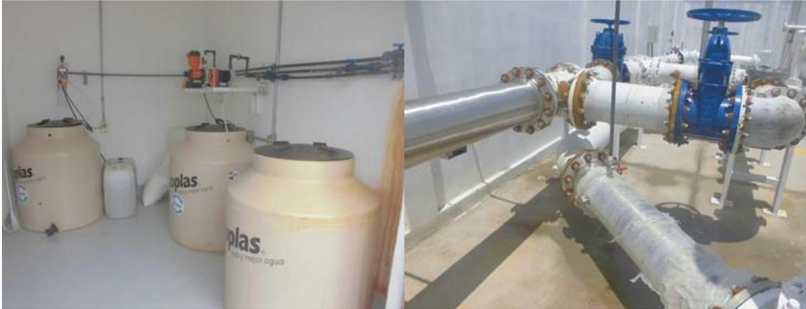
**Figura 19. Caseta de dosificación y mezcladores estáticos para agua cruda y de retrolavado**
