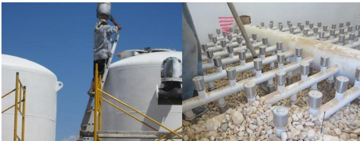
**Figura 17. Empaquetado de material filtrante; toberas en el fondo**
