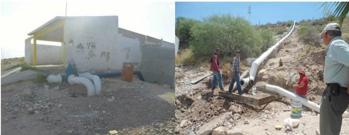
**Figura 14. Interconexión de llegada a planta y tanque de agua tratada; línea de conducción a zonas de influencia de pozos 4A y 34**
