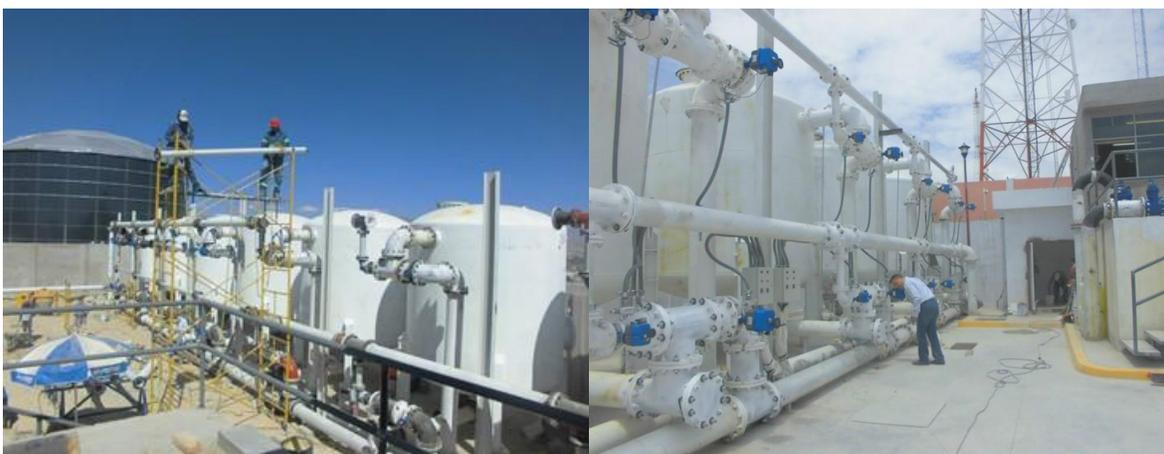
**Figura 16. Proceso de conexión de filtros a líneas de tuberías y verificación de control de válvulas**
