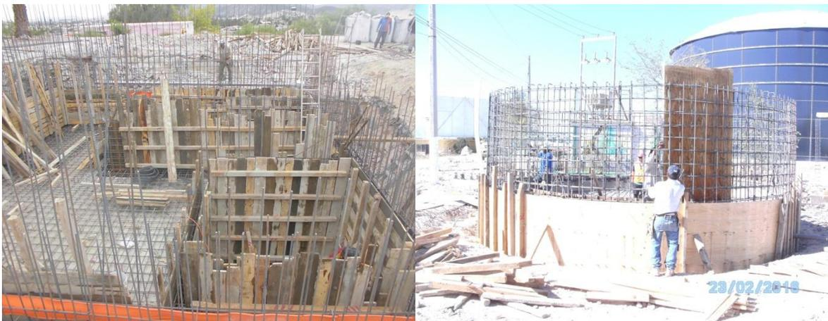
**Figura 12. Cimbra y armado de acero en tanque de almacenamiento y sedimentador**
