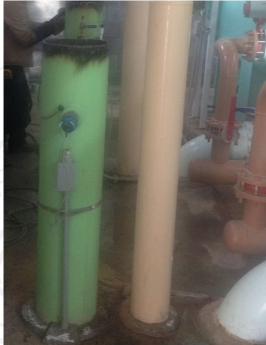
Figura 8. Corte de la tubería.
