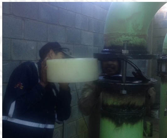
Figura 12. Colocación de la placa de inducción de turbulencia.
