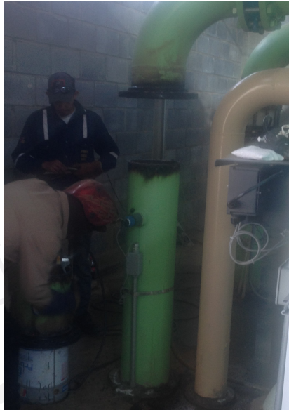
Figura 9. Brida colocada en el corte superior.
