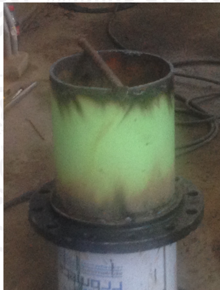
Figura 10. Brida soldada en el tubo cortado.
