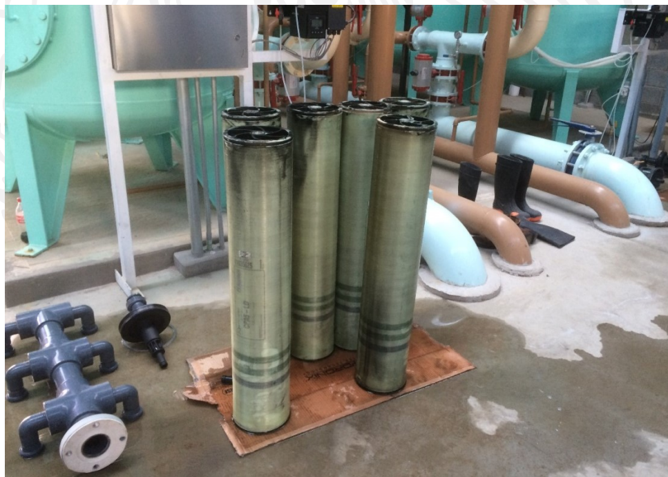
Figura 3. Membranas en posición vertical para el drenado.
