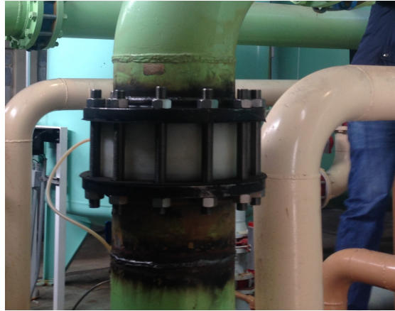
Figura 13. Ajuste de las bridas.
