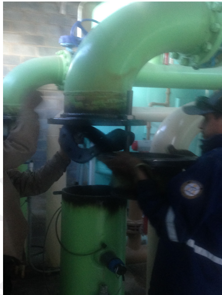
Figura 11. Colocación del tubo cortado.
