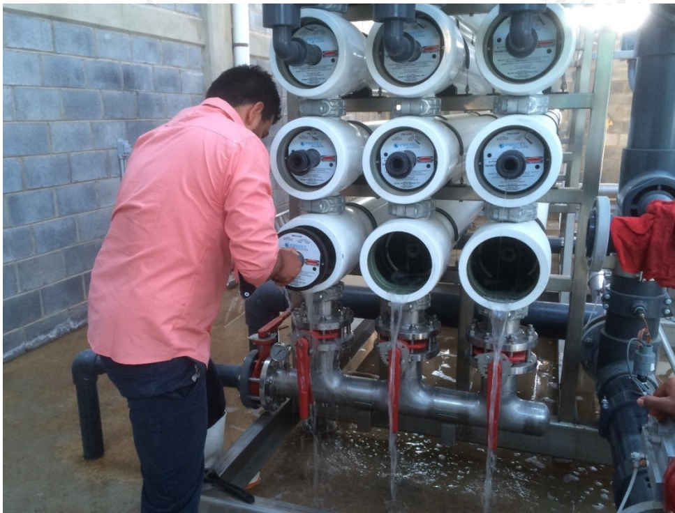
Figura 1. Remoción de las tapas de las vasijas de presión del tren # 1.
