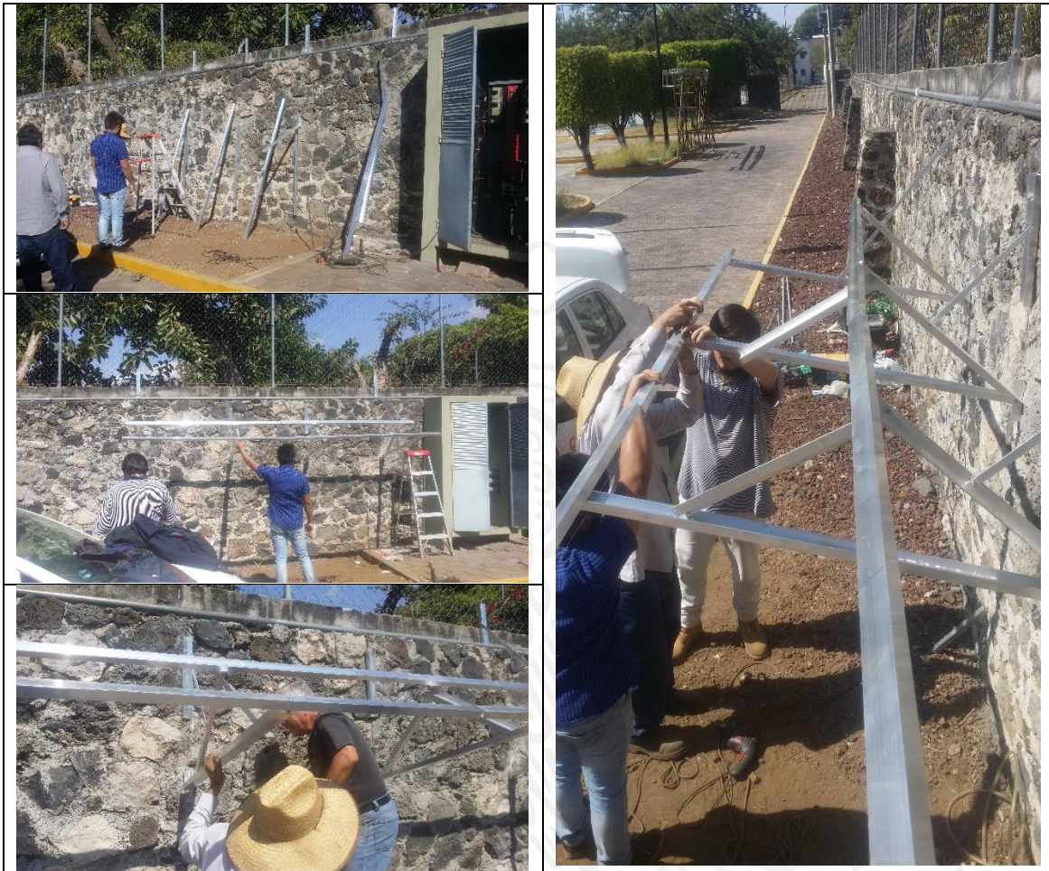
Ilustración 5.54 Colocación de una base de aluminio
