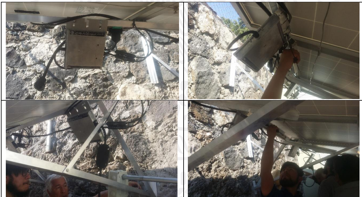
Ilustración 5.56 Colocación y conexión de los microinversores
