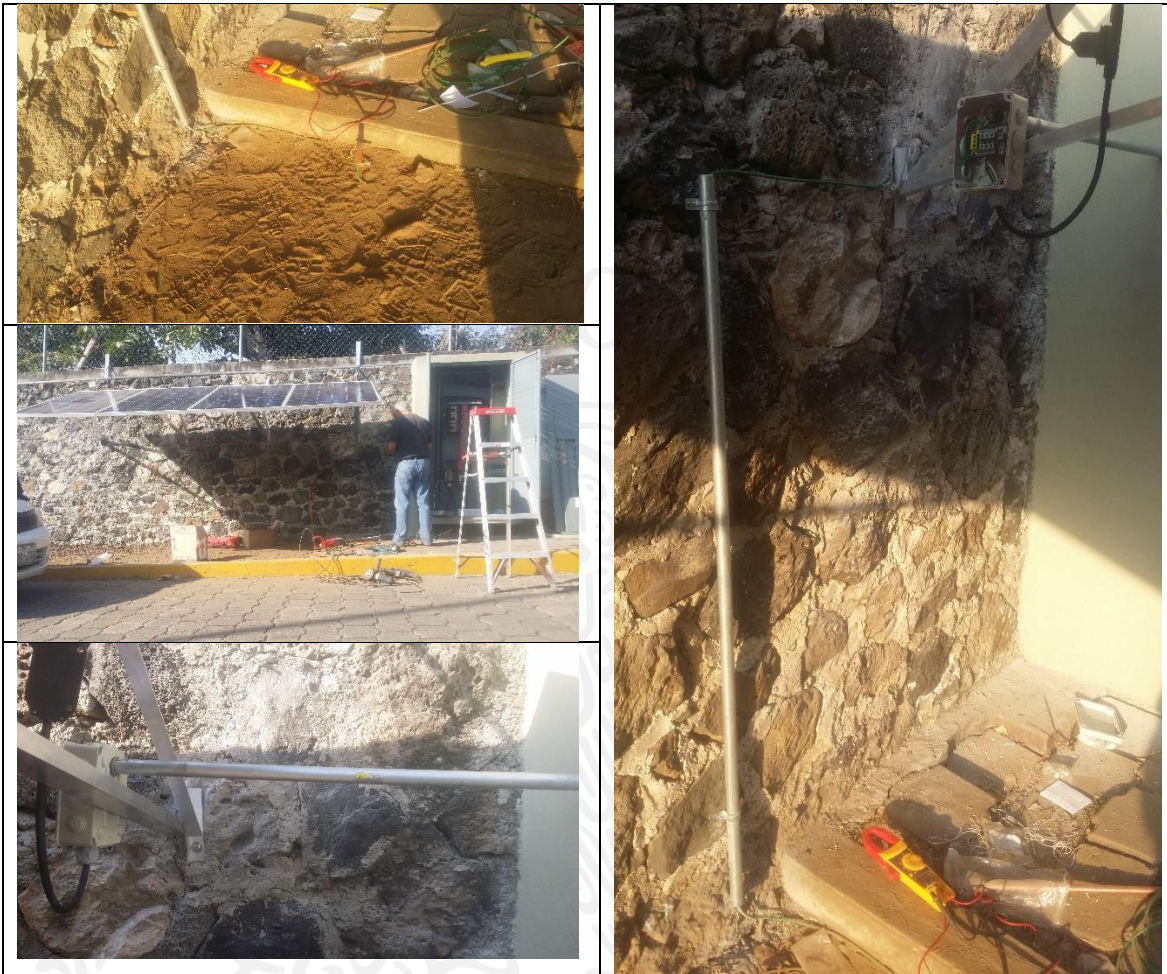
Ilustración 5.57 Colocación del sistema de tierra
