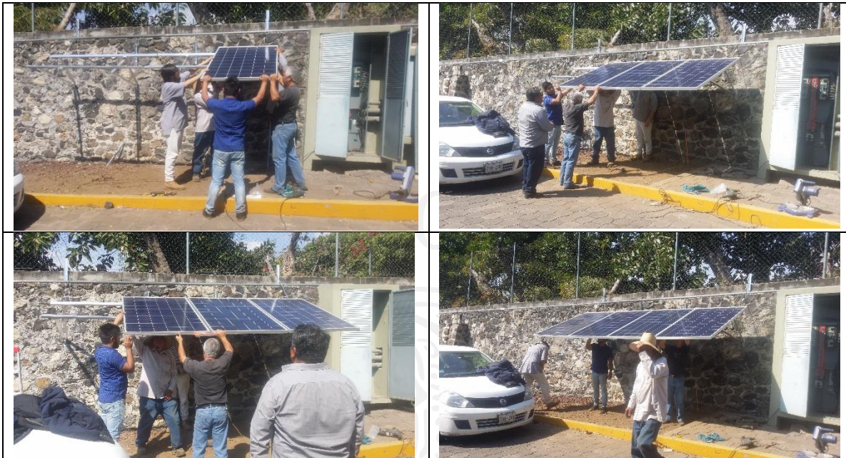
Ilustración 5.55 Colocación de los módulos solares
